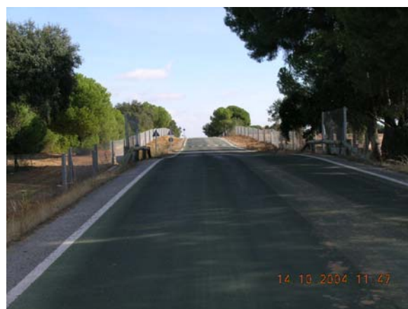
Carretera de Villamanrique a El Rocío 1
