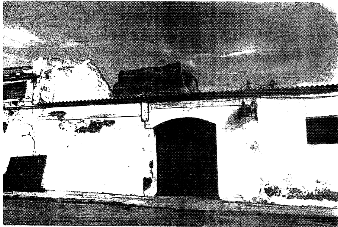
1.-Torre en C/ Arco Tomisa
