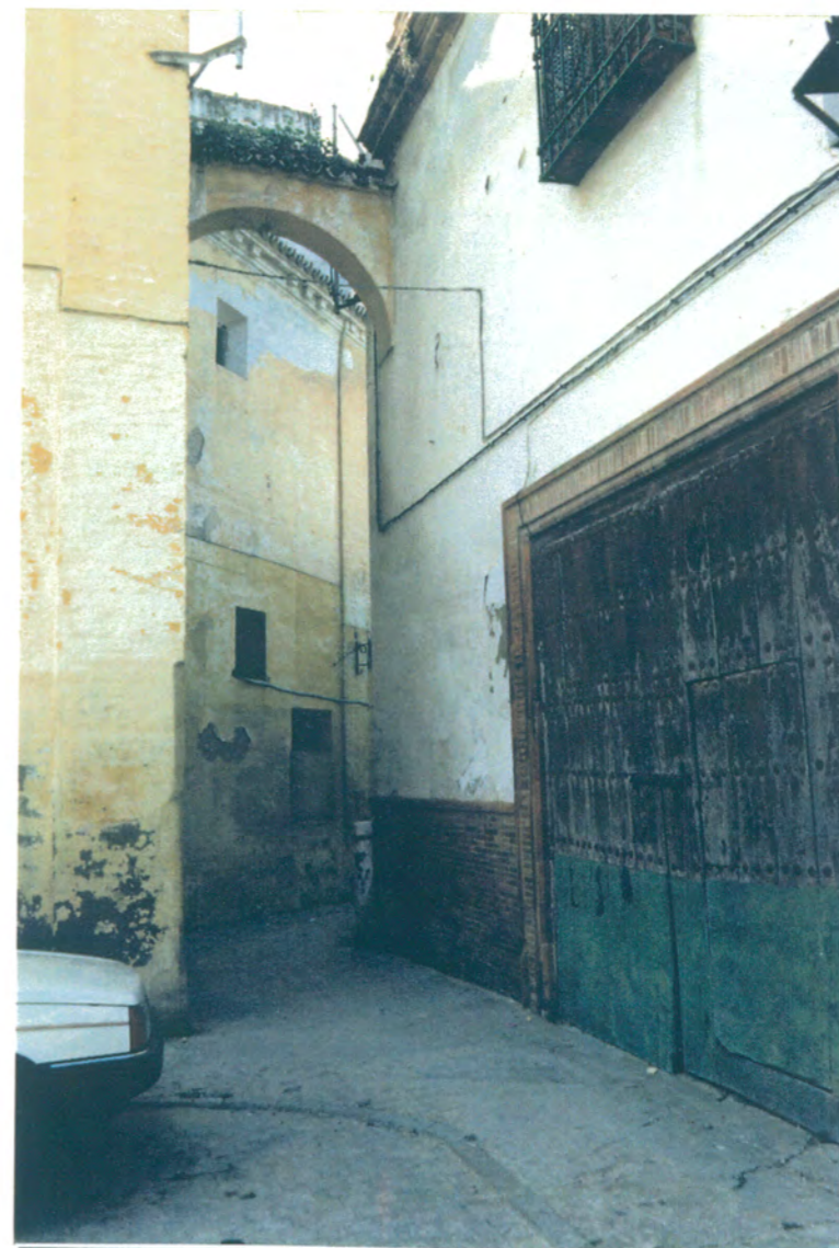
78. Arquillo, en la trasera de la iglesia medianero con la casa nº 1 de la C/. Cristobal de Morales.
