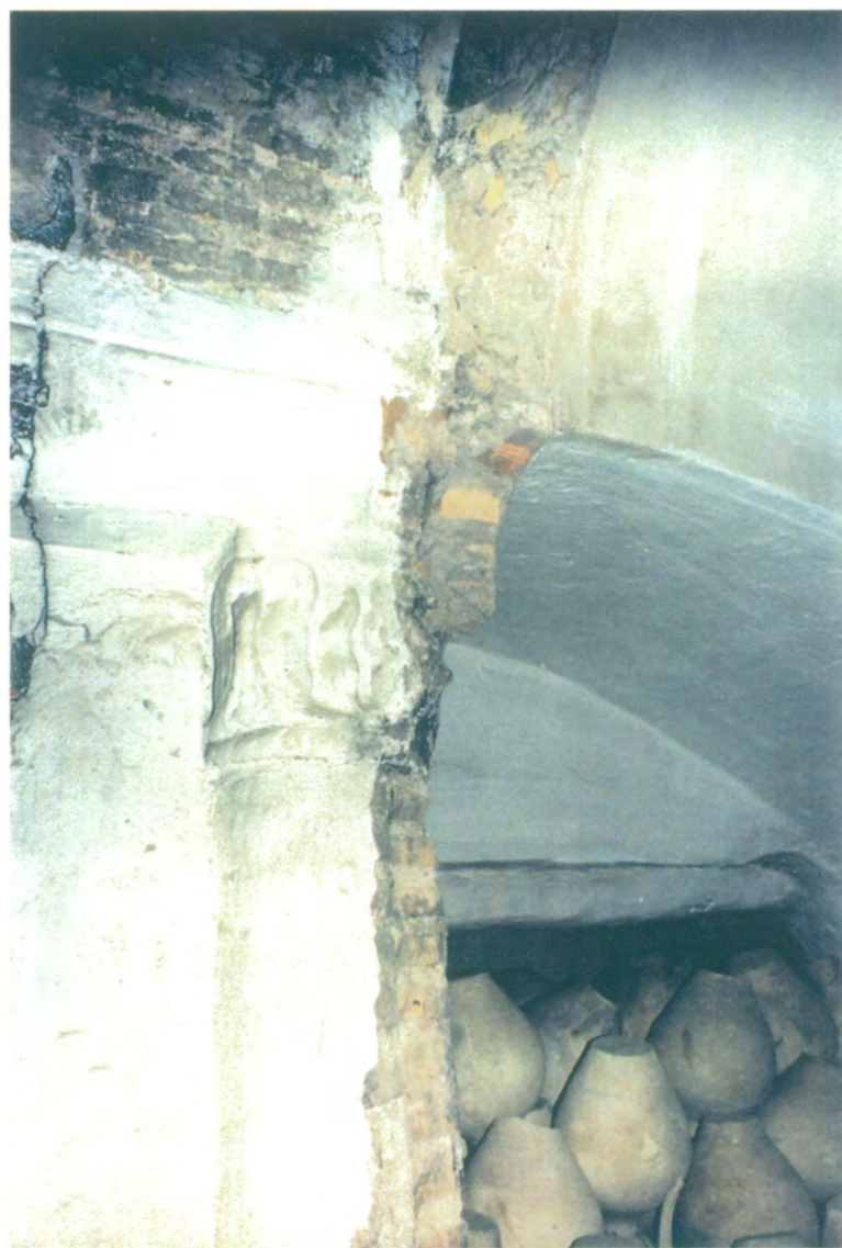
14. Detalle del Arco y columna con capitel a los pies de nave colateral del lado del Evangelio. Esta columna es de mampostería de ladrillo y el capitel de piedra; al fondo se observan los cántaros de barro, hallados en el interior de la cubierta, con motivo de la restauración realizada en 1.991. Estas vasijas y otras son anteriores a 1.550.
