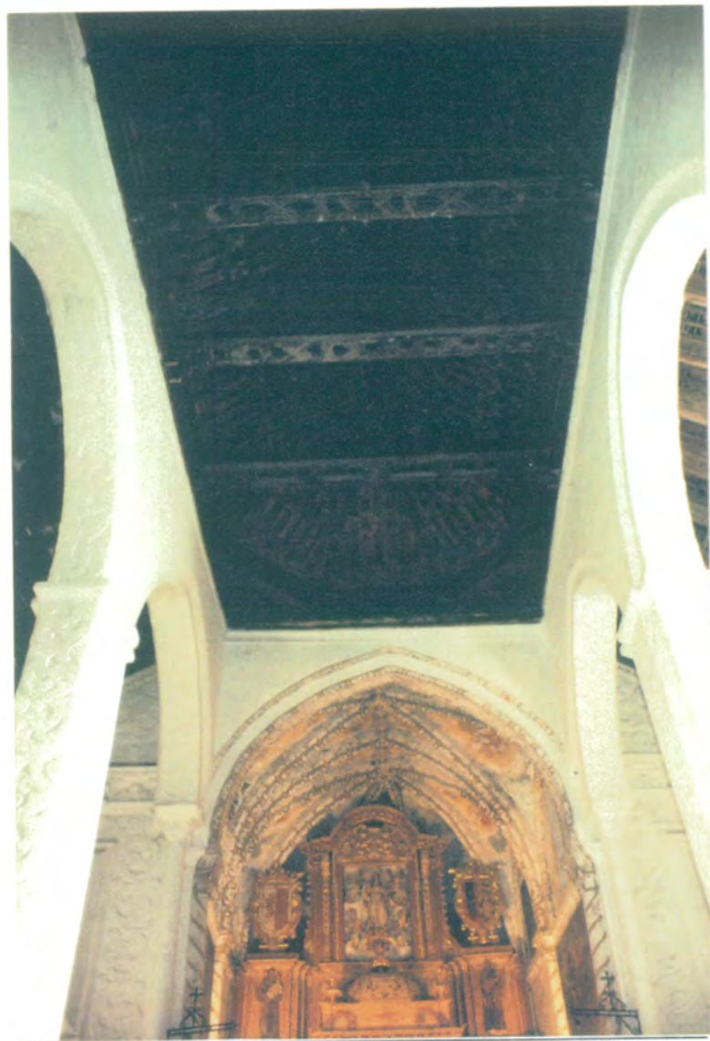
8. Vista artesonado nave central, mudéjar, par y nudillo con lacería, arco triunfal apuntado y bóveda de nervadura.
