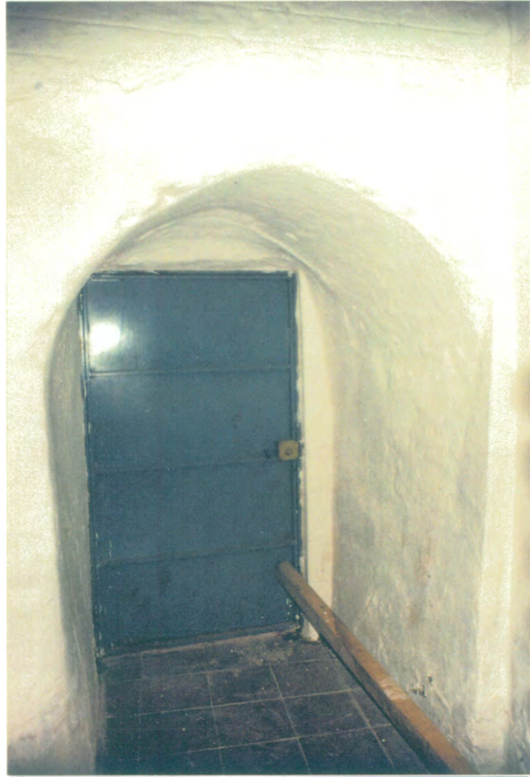
25. Puerta de acceso a la huerta del Convento.
