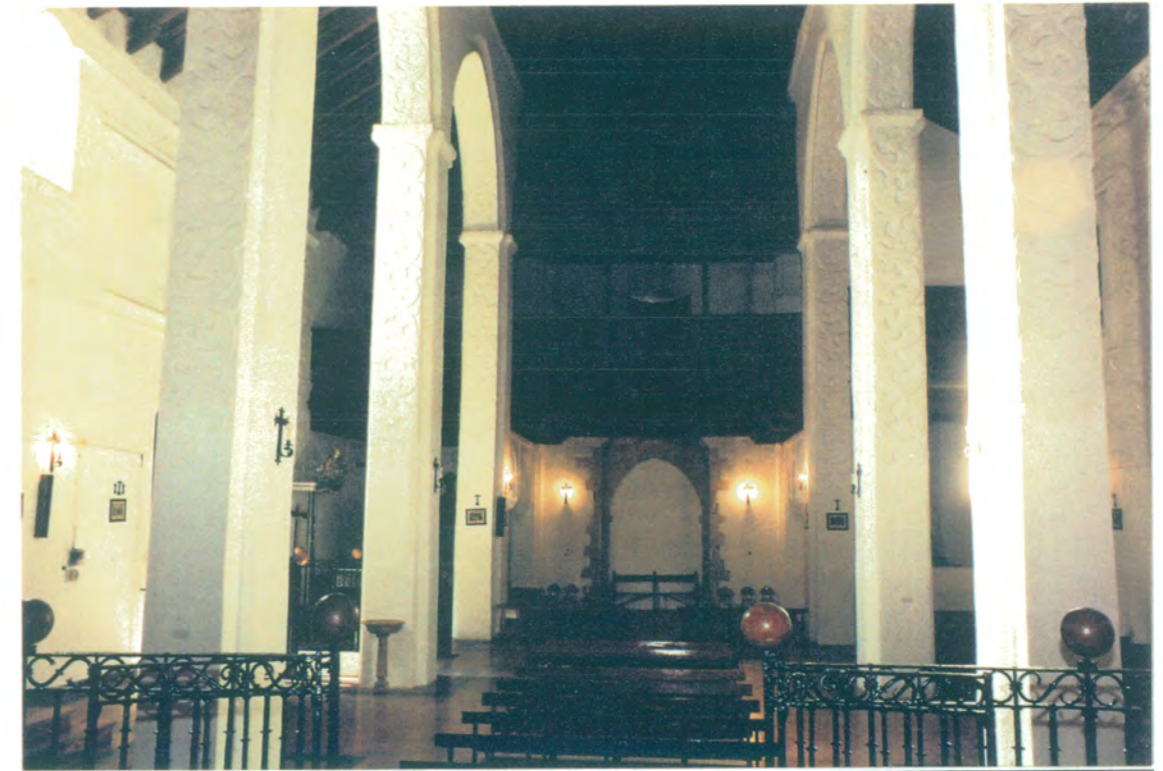
14. Vista general donde se aprecia la reja que cierra el presbiterio, realizada en hierro forjado del siglo XVII, rematada por bolas de jaspe rojo. También se observan pilares cruciformes mudéjares, donde apoyan arcos apuntados. En los muros yesería barroca siglo XVIII. A los pies Tribuna Palatina con celosía de madera del siglo XVI.
