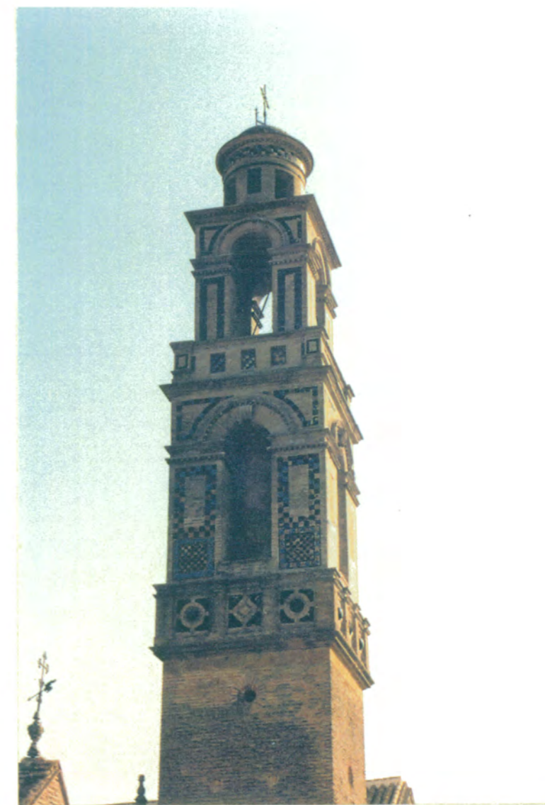
3. Campanario de la torre fechado en 1.580 sobre estructura anterior, que posiblemente fuera un torreón almohade de 1.360.
