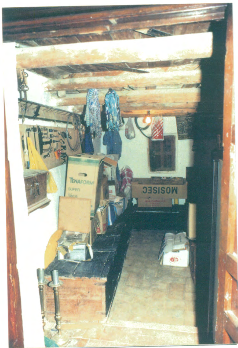
19. Habitación situada en sala capitular y donde se observa la estructura de madera que sustenta la capilla de la Virgen de la Soledad.
