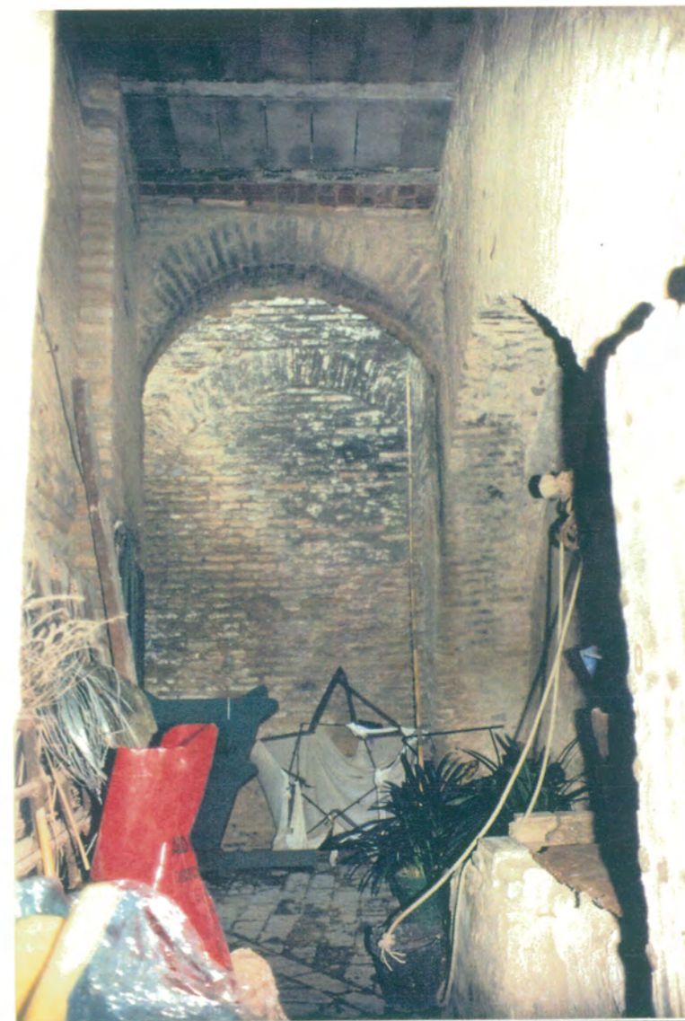
24. Vista del pozo, desde el acceso del Convento a la Iglesia.
