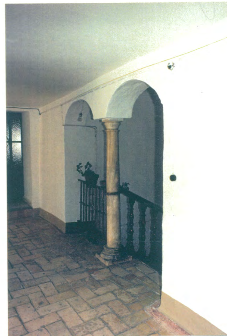
20. Llegada al cláustro superior por escalera, anteriormente descrita, en el que se aprecia la solería existente, la baranda de balaustre de madera y arcos rebajados sobre columna toscana.
