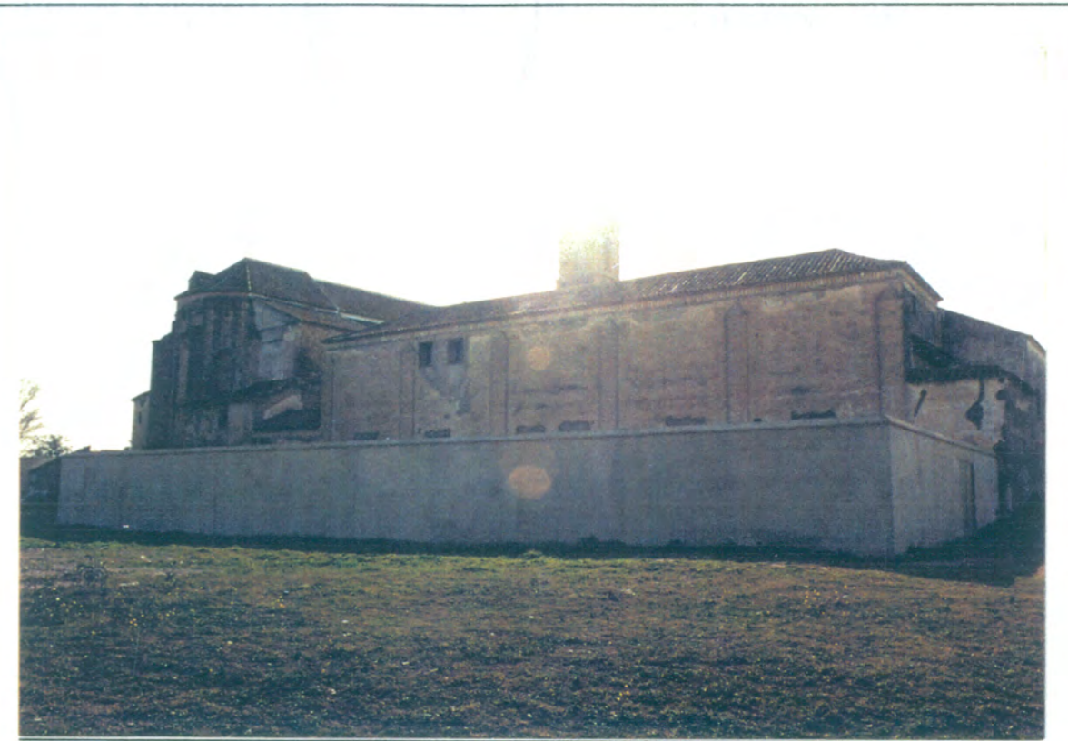
41. Fachada posterior (N.E.) del Convento y de la Iglesia, con cerramiento de reciente construcción.
