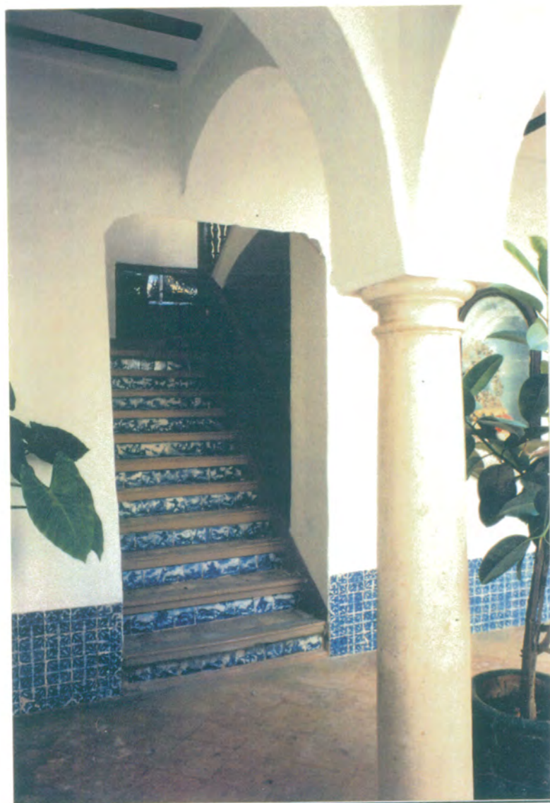
17. Escalera de acceso al claustro alto, siglo XVIII, formada por azulejos de la misma época, ladrillos y mamperlán de madera.
