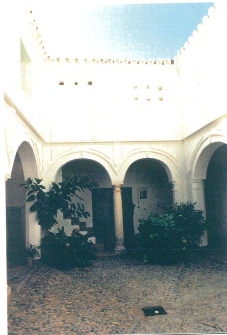
10. Vista del patio, en la que se aprecia el pavimento y la escalera de acceso a planta superior.
