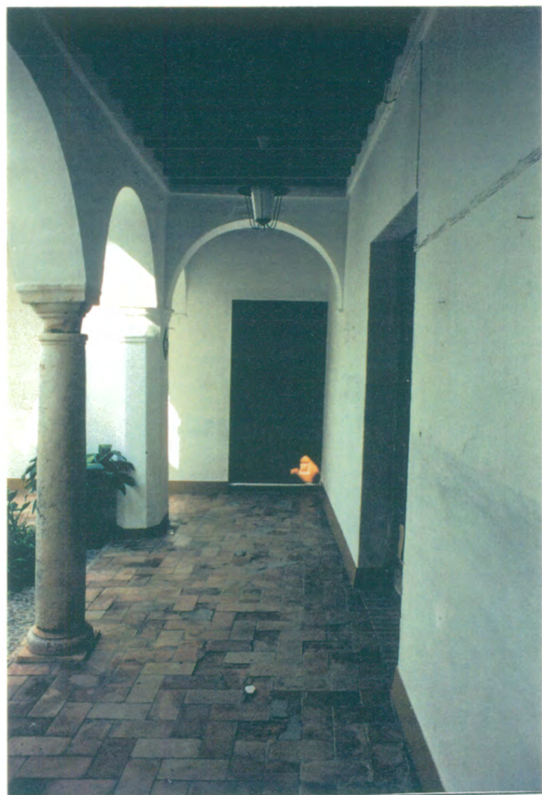
13. Vista general de la galería, ala suroeste.
