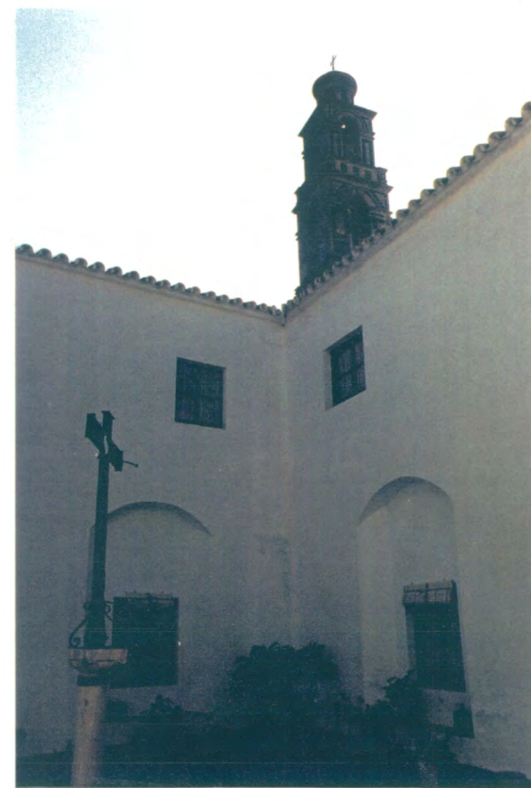
16. Patio interior del Convento. Ha sido pavimentado con materiales inadecuads.
