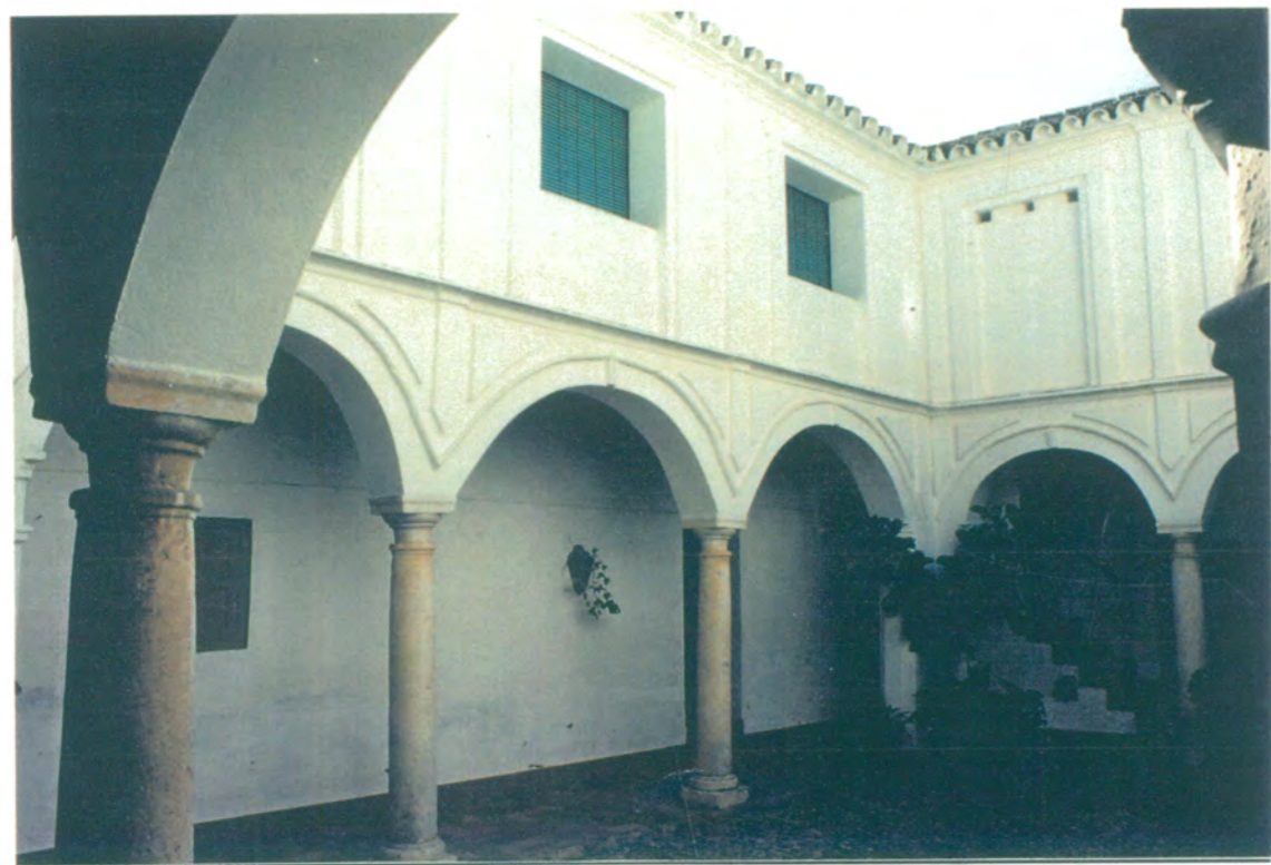
9. Vista desde el mismo lugar, donde se aprecia la pequeña escalera que da acceso a la planta superior.
