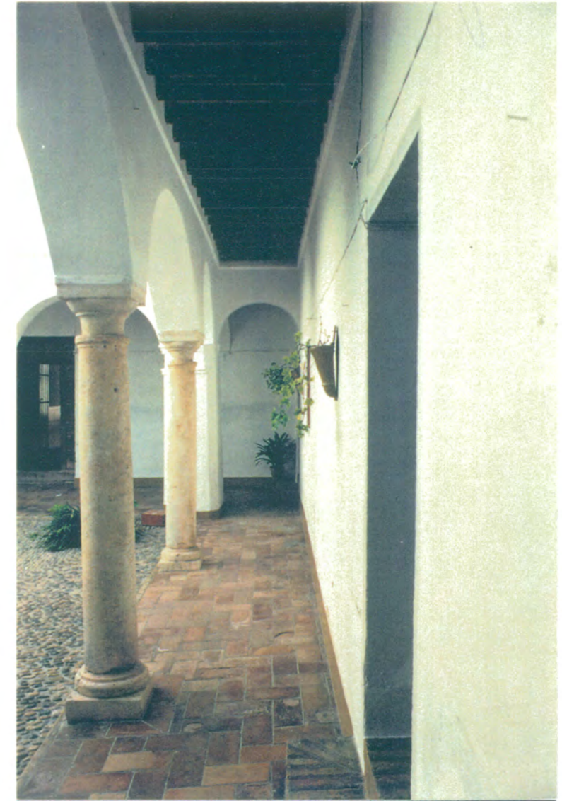
12. Vista de la galería, donde se aprecia la puerta de entrada al patio, que da acceso a la vivienda. El tipo de solería y artesonado son antiguos.
