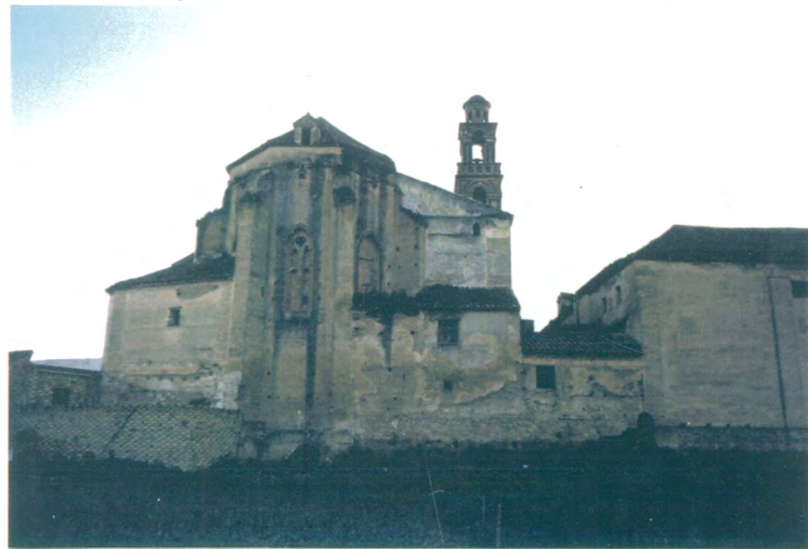
40. Fachada posterior (N.E.). Detalle del ábside de la Iglesia de Sta. María de la Mota.
