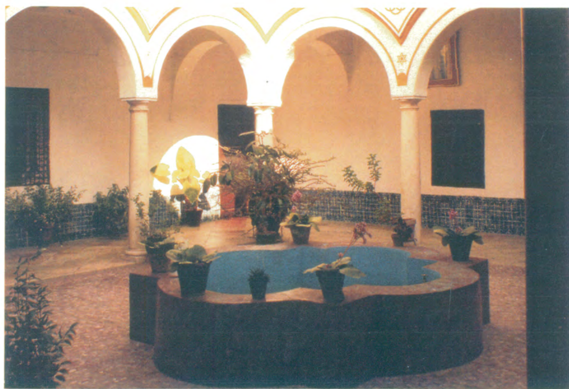
15. Patio del claustro del Convento con zócalo de azulejos del primer tercio del siglo XVIII y arcos decorados de medio punto sobre columnas toscanas. Ha sido pavimentado con materiales inadecuados.
