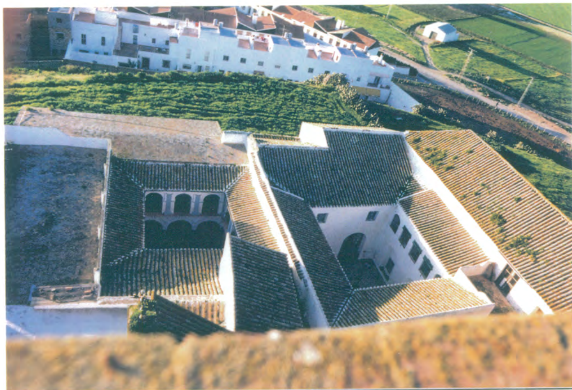
23. Vista desde la torre, de las cubiertas del patio del claustro y del patio interior del Convento.
