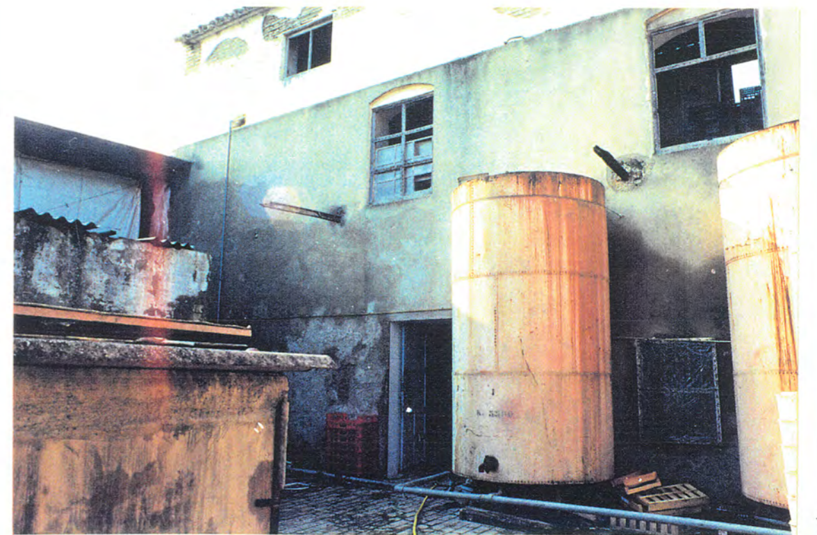
7. Vista del lateral izquierdo de la fachada posterior del Convento.
