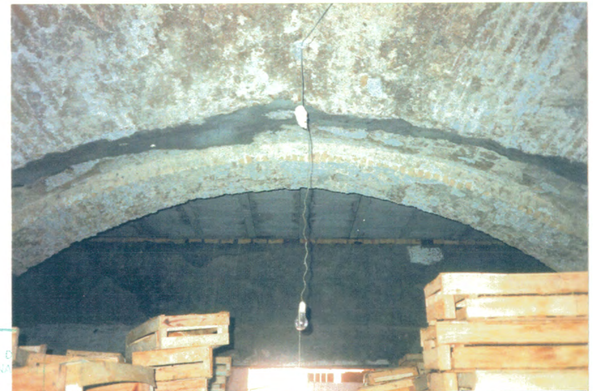
Detalle de la bóveda del panteón.
