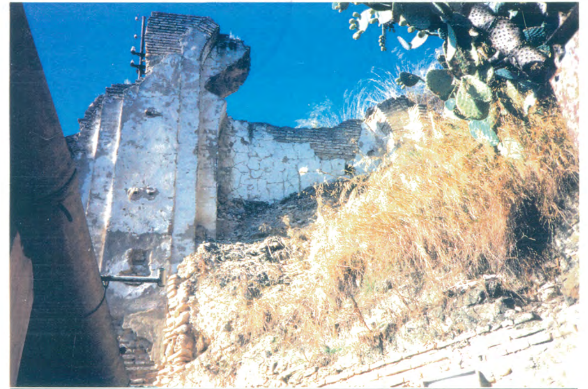
9. Desde el compás, vista en detalle de la pilastra y arranque del arco toral sobre el que estribaba una cúpula sobre pechinas, que cubría la pequeña iglesia del Convento.
