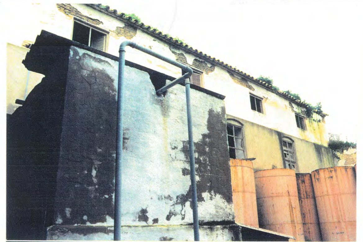
6. Desde el patio posterior (bajo cuyo nivel se sitúan bóvedas de posibles baños árabes, lateral derecho de la fachada posterior del Convento.
