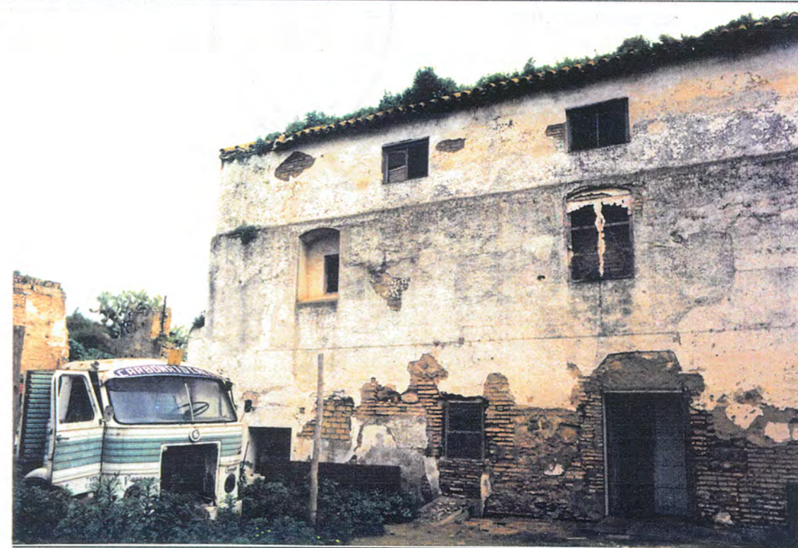
2. Desde el compás que da a la plaza, vista del lateral derecho de la fachada principal.
