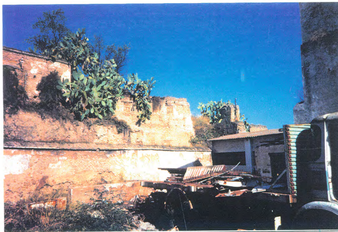
5. Detalle del muro del pasadizo y de los restos del palacio.
