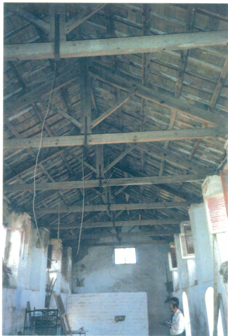
17. Vista de la sala-dormitorio en planta alta del cuerpo principal, la cubierta a dos aguas es de madera formada por puntales, pendolón, cabios y ladrillo por tabla.
