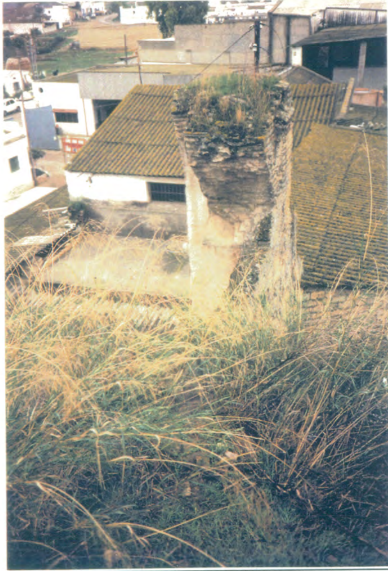
8. Desde el palacio Ducal, vista de restos de una pilastra y arranque de arco toral sobre el que estribaba una cúpula sobre pechinas, que cubría la pequeña iglesia del Convento.
