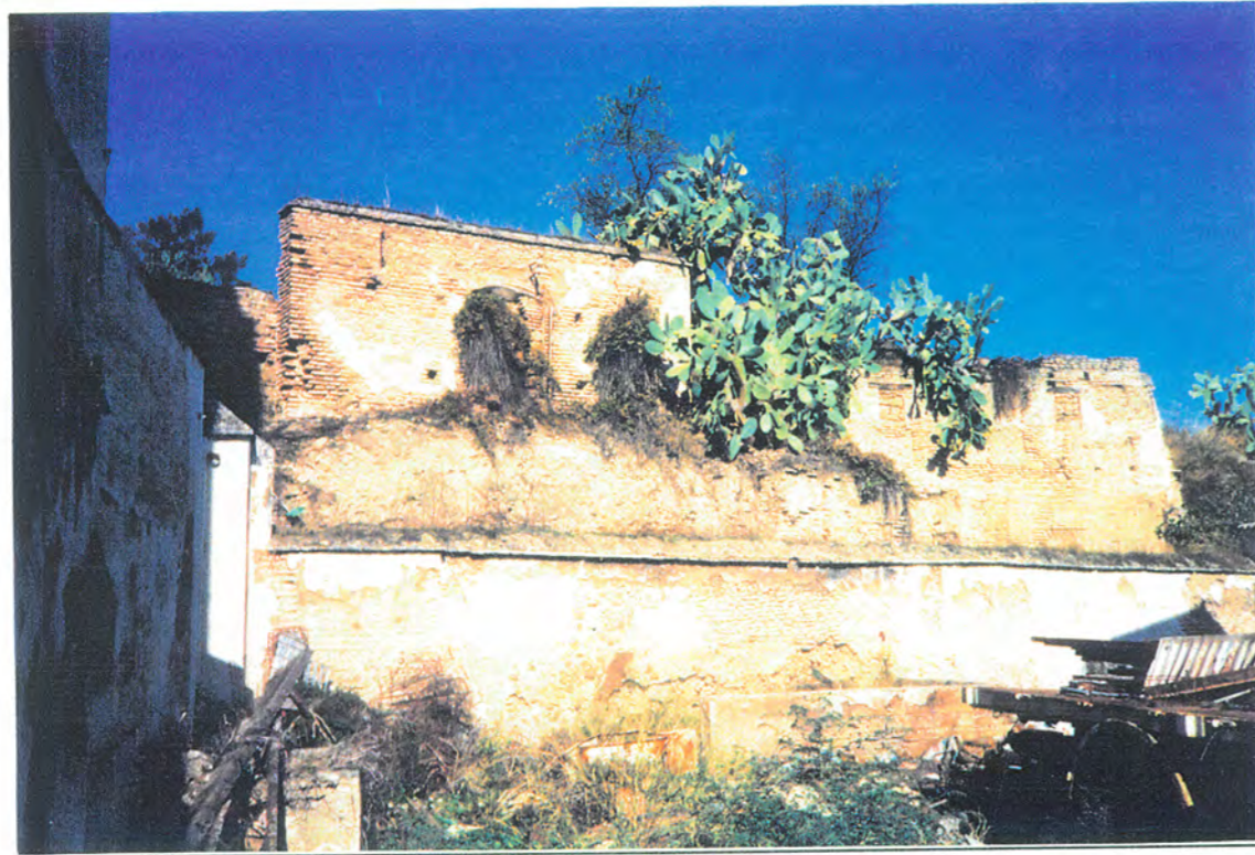
4. Desde el compás, en primer término muro de cerramiento del pasadizo y al fondo restos del palacio Ducal.
