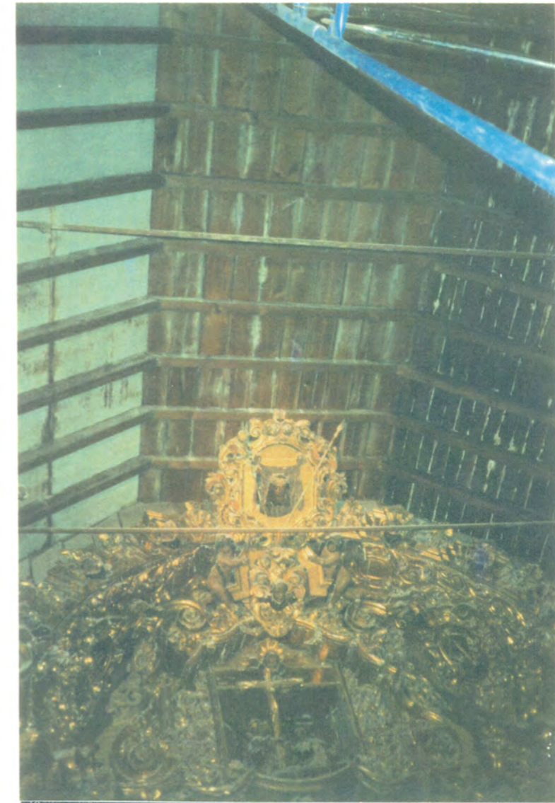
14. Vista del artesanado de la nave central antes de la reforma.
