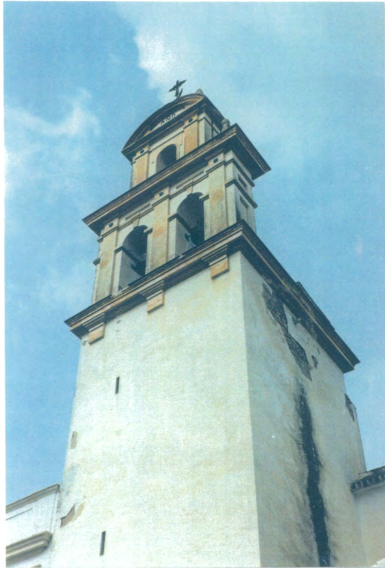
3. Torre cuadrada que sustenta la espadaña.
