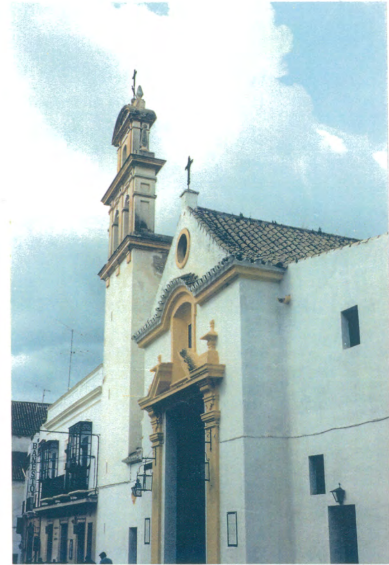
2. Detalle del conjunto de la portada y la espadaña, construída en 1949.
