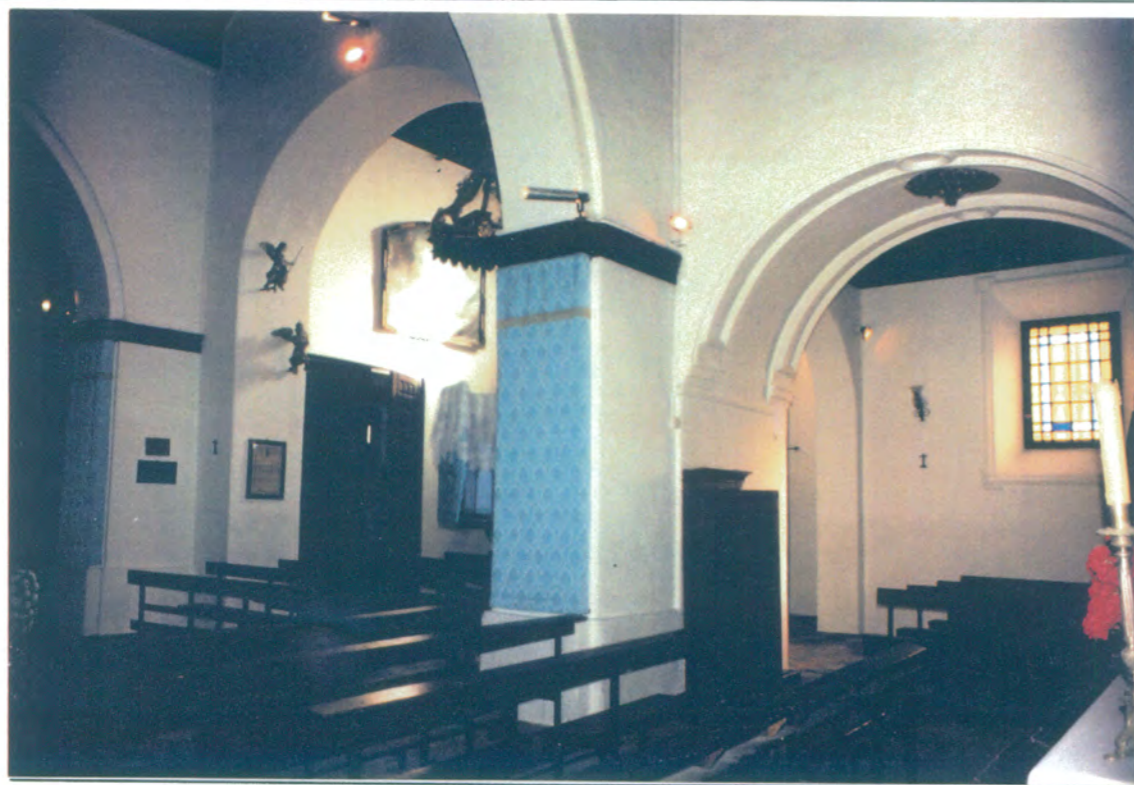
15. Vista parcial. A los pies de la iglesia, pilares cruciformes, arcos apuntados y de medio punto.
