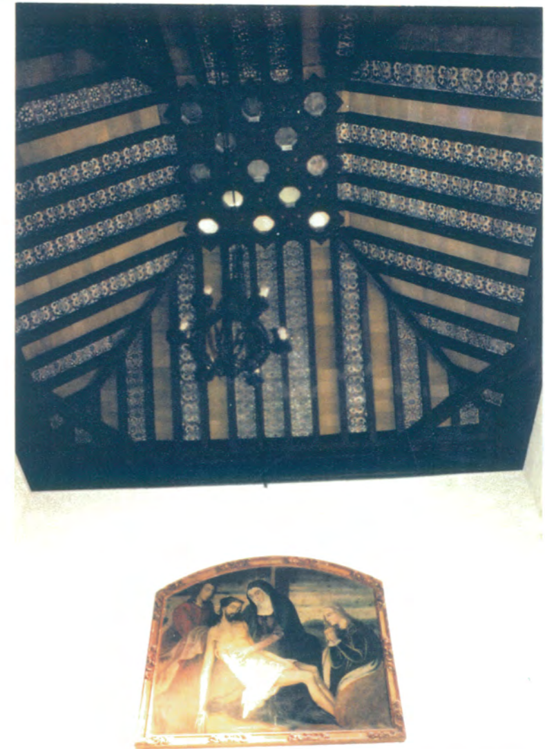
19. Artesonado de madera, moderno, con materiales anteriores como los azulejos por tabla de cuenca, melado, verde y azul.
