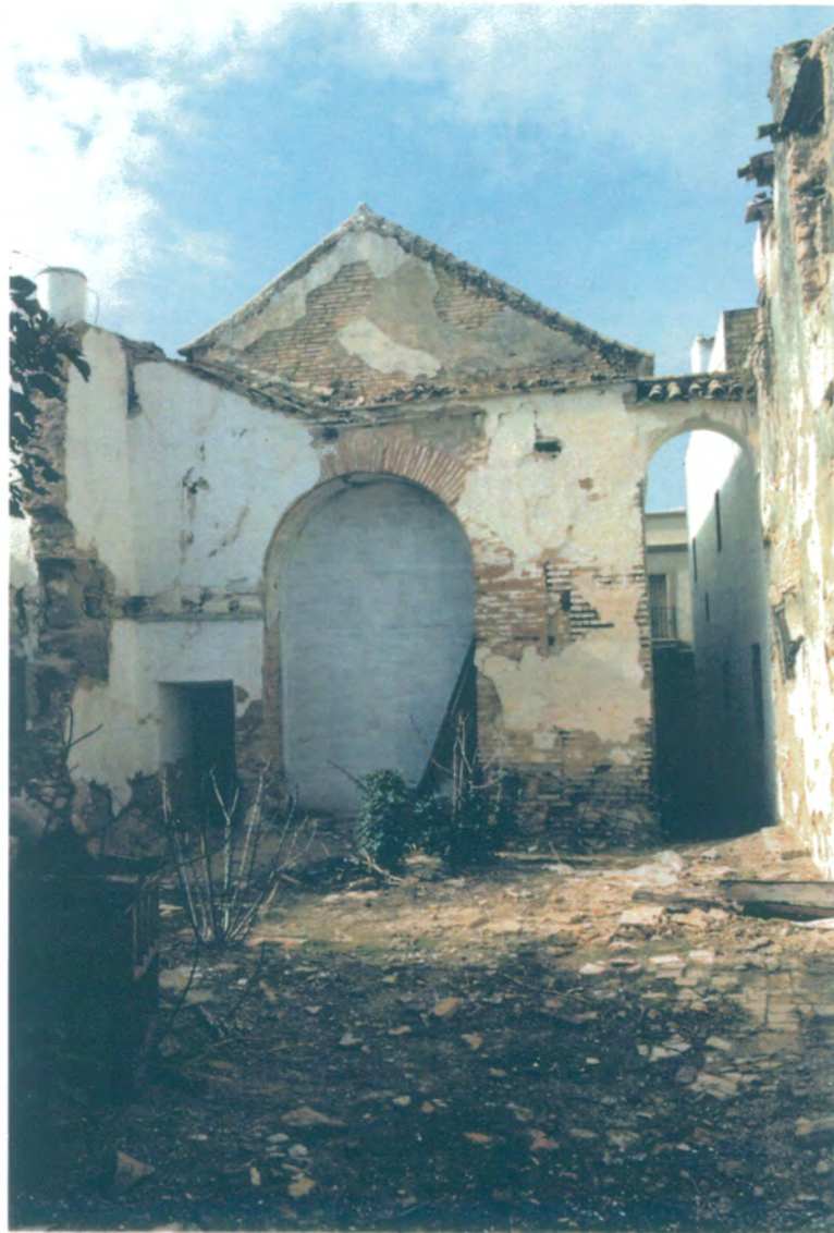
3. Fachada posterior de la iglesia, donde se observa la construcción de fábrica de ladrillos y tapial. El arquillo de arriostramiento al muro del lado del Evangelio, es el único existente de otros dos que han sido demolidos.
