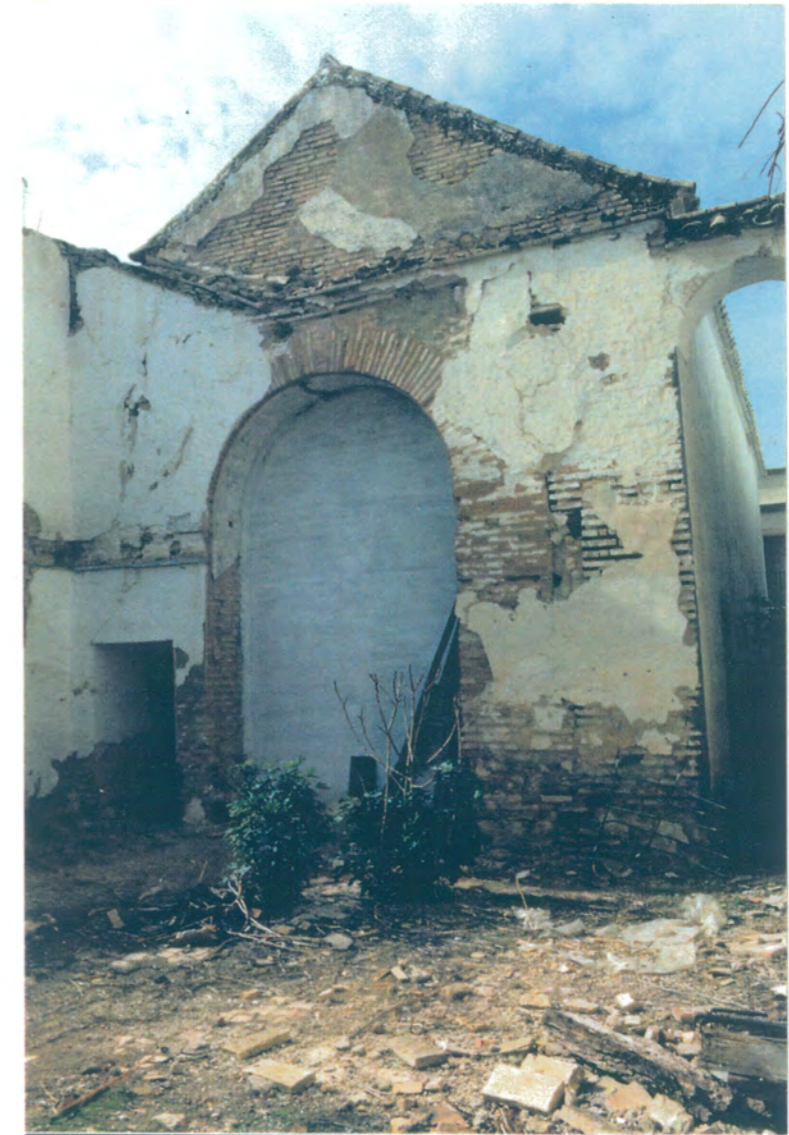
6. Detalle fachada posterior, arco de medio punto de fábrica de ladrillo.
