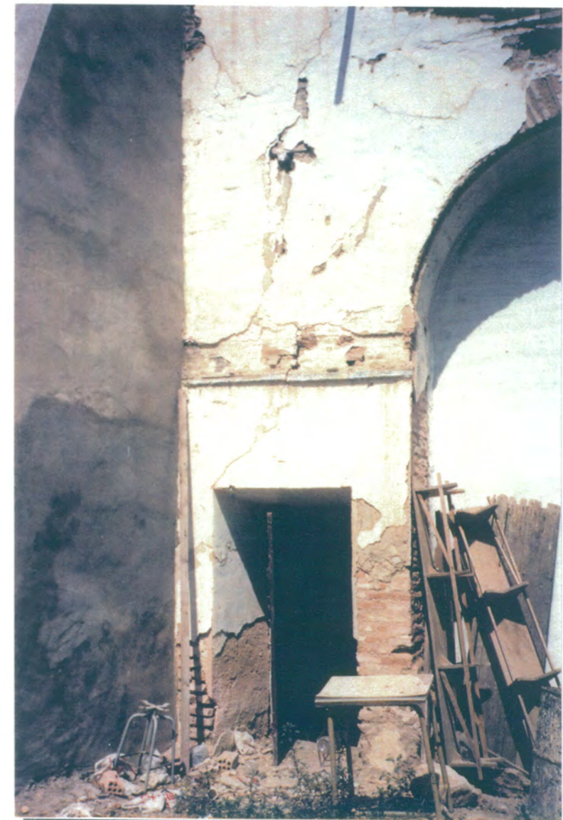
8. Detalle fachada posterior, puerta de salida desde la iglesia al patio.
