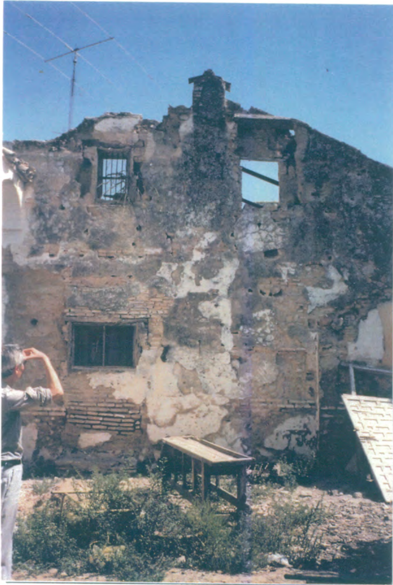
9. Medianera al patio posterior.
