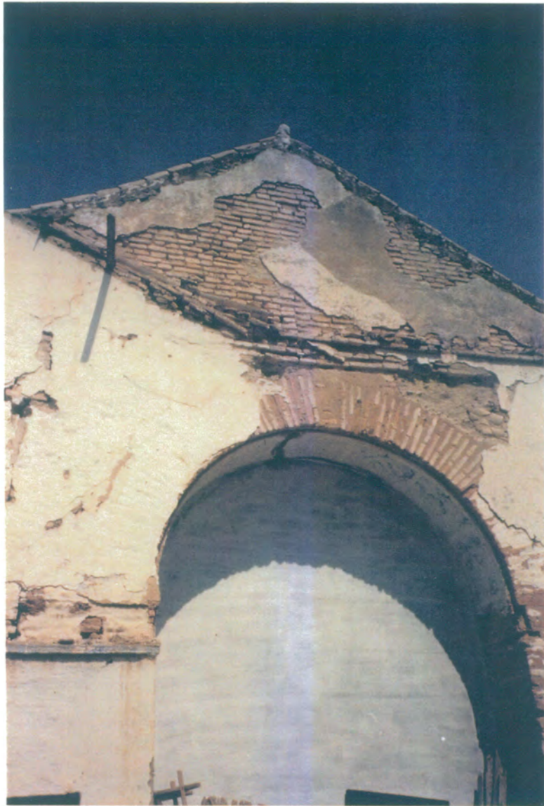
7. Detalle fachada posterior, del arco y de la cubierta a dos aguas de teja árabe.
