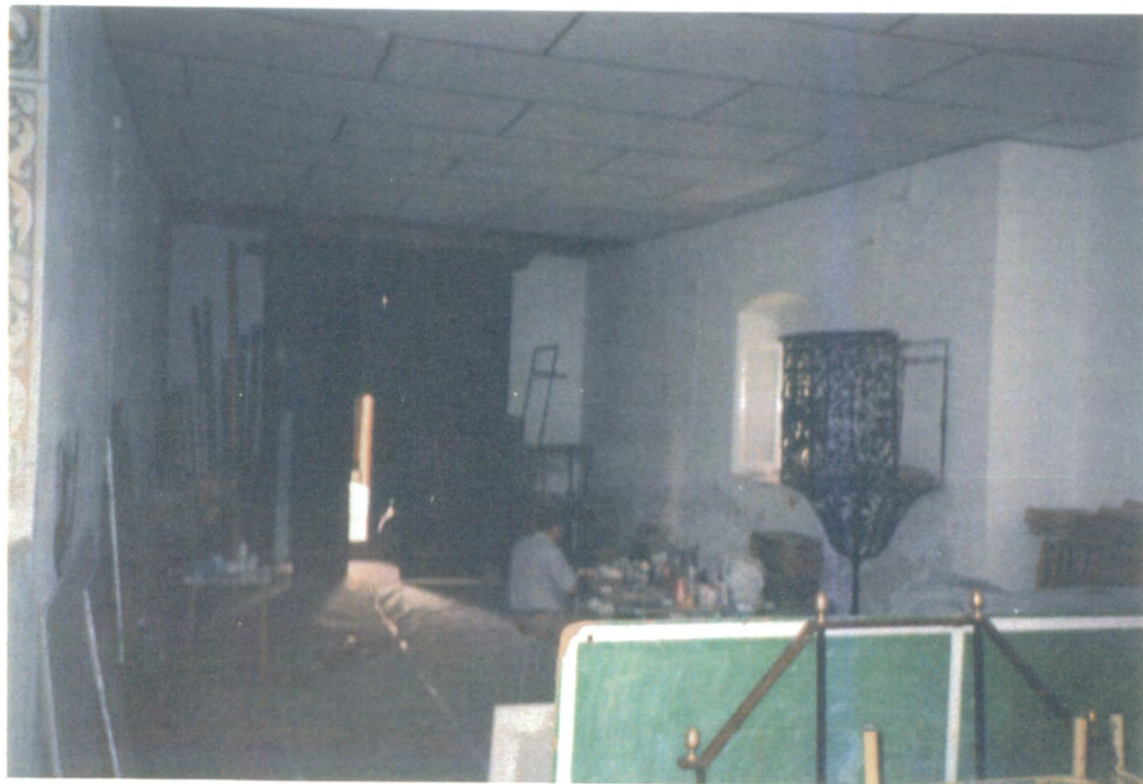
12. Vista general de la iglesia, estado actual, desde el presbiterio hacia los pies y al lado del Evangelio, se observa el púlpito.
