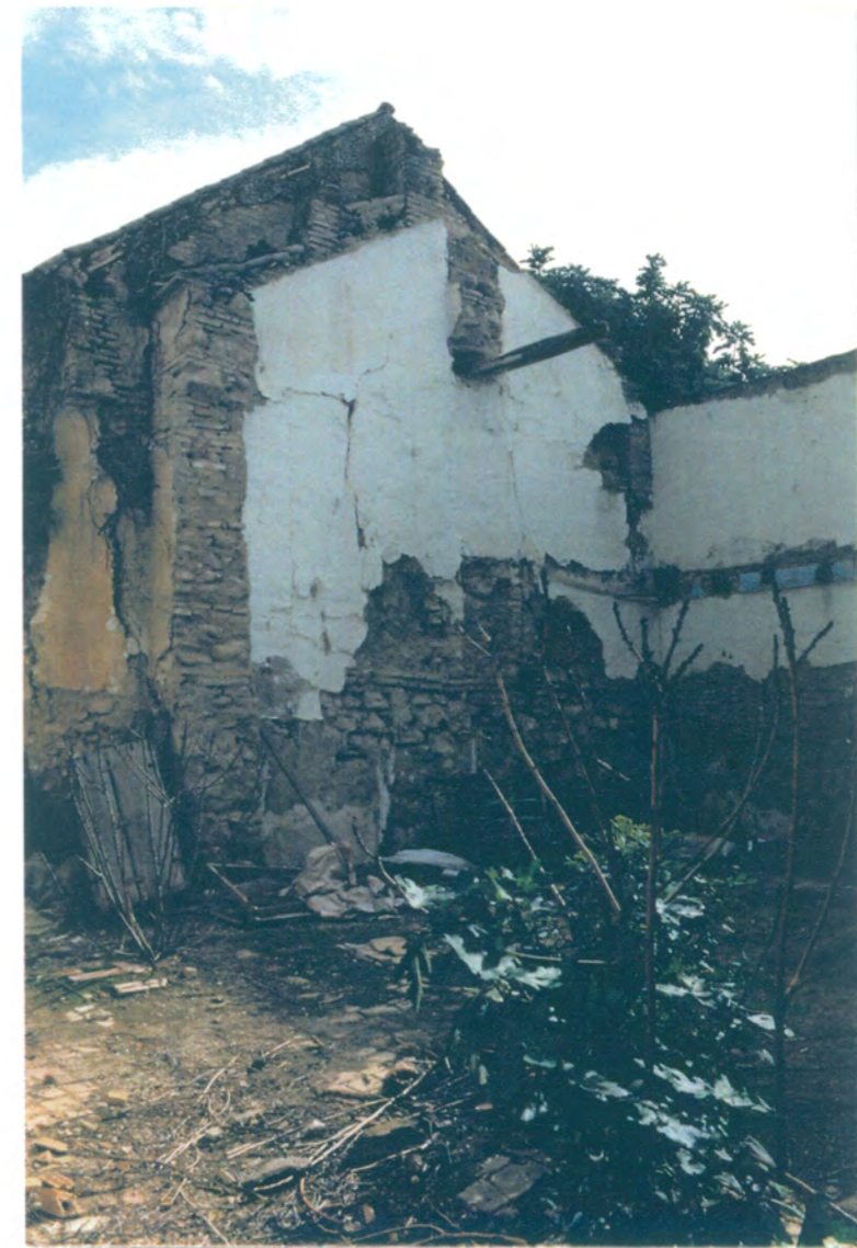
10. Medianera al patio posterior.
