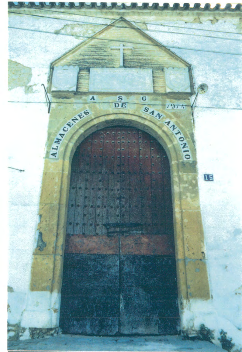
3. Portada de cantería, arco de medio punto y piñón triangular con dos escudos de piedra de la Villa y de los duques de Arcos y lápida con una inscripción ilegible.
