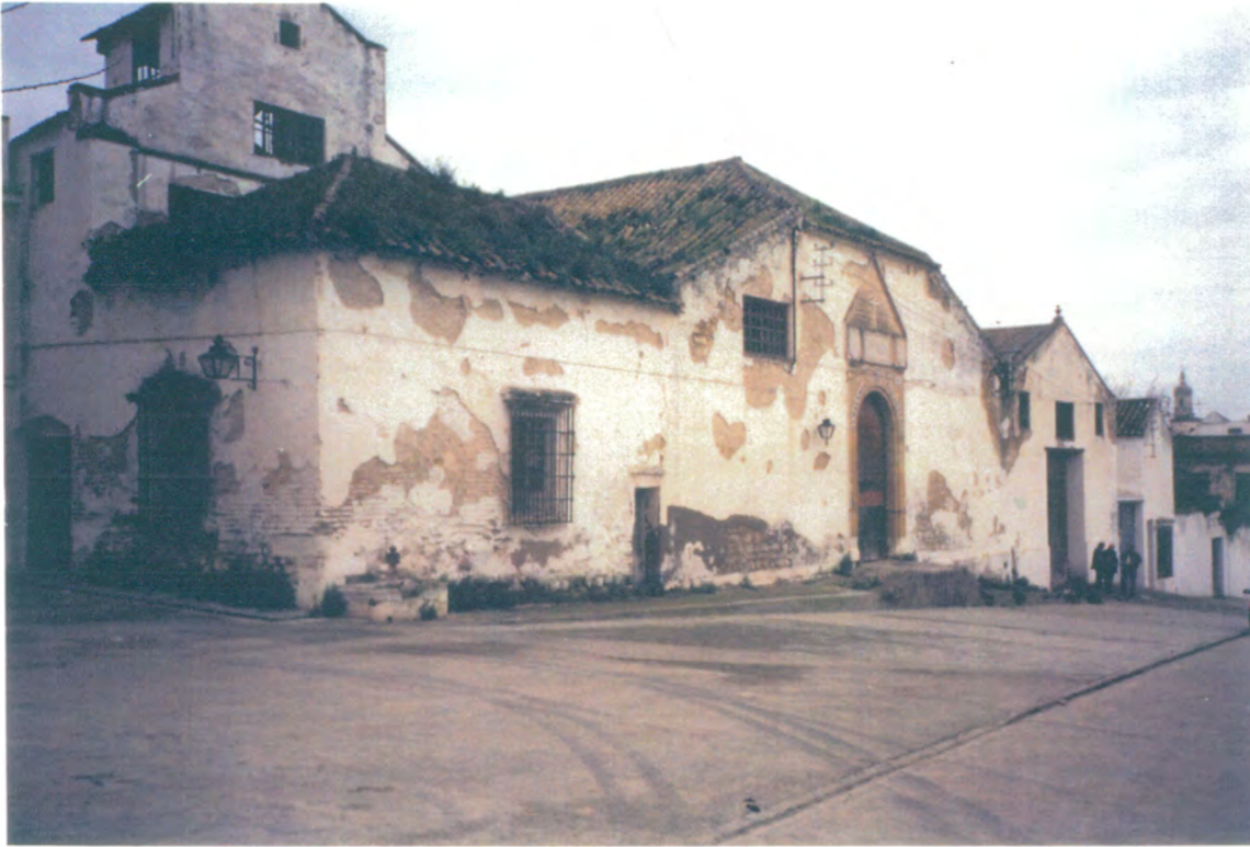
1. Vista general del conjunto del edificio, siglo XVIII.
