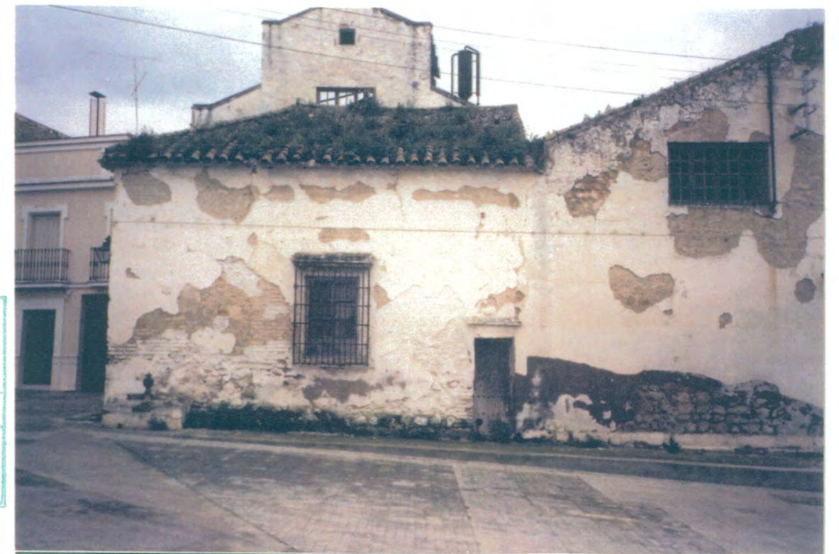
6. Detalle de fachada principal, lateral izquierdo.
