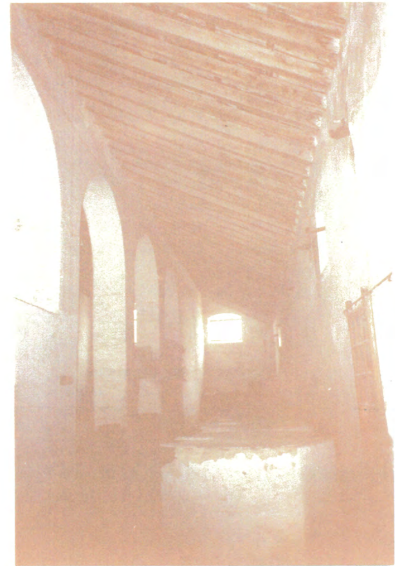
9. Vista de la nave lateral derecha desde los pies, arcos de medio punto sobre pilares de ladrillo y cubierta a dos aguas de par y nudillo. Se observa las bases de ladrillo para sustentar los depósitos construidos cuando se convirtió en fábrica de aceite.
