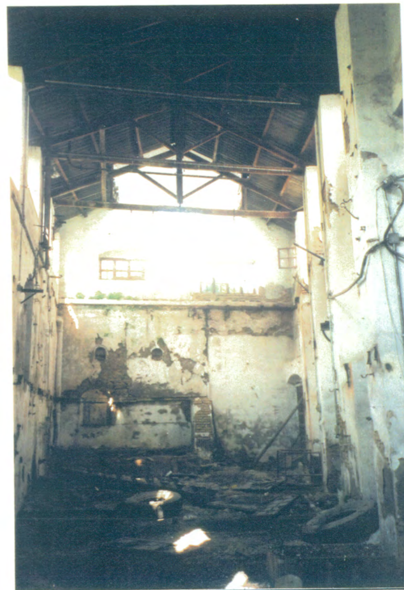
11. Vista de la nave a la que se accede desde la barreduela de C/ Cilla, es de construcción posterior y la cubierta es de uralita a dos aguas, sustentada por cerchas de madera, la vista es desde el fondo hacia la calle.
