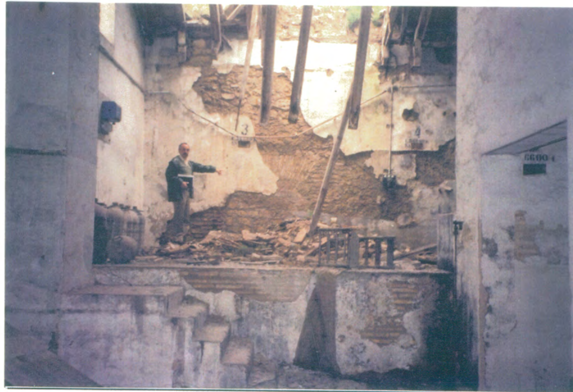
8. Vista fotográfica desde los pies, de la nave central del lateral izquierdo.
