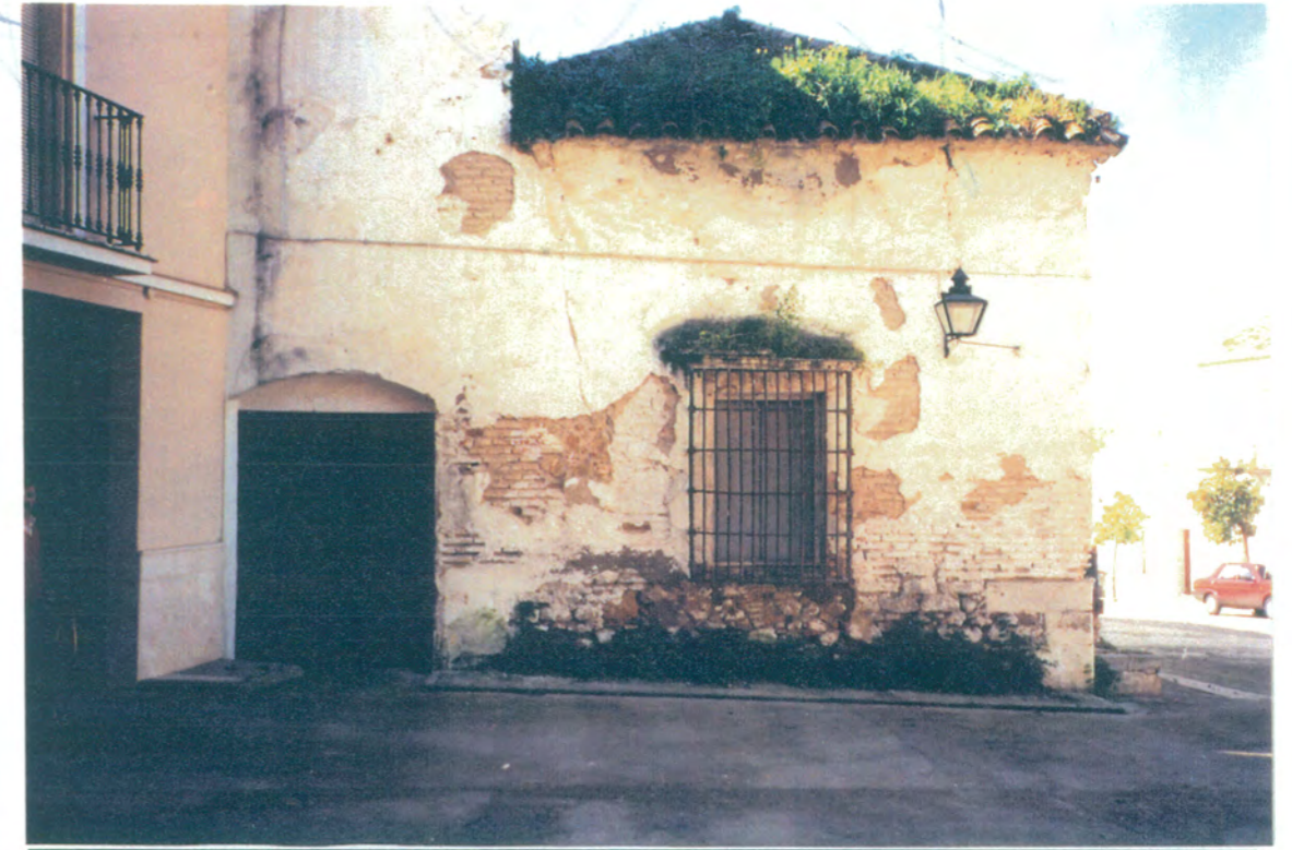
5. Detalle de fachada lateral a barreduela de C/ Cilla.
