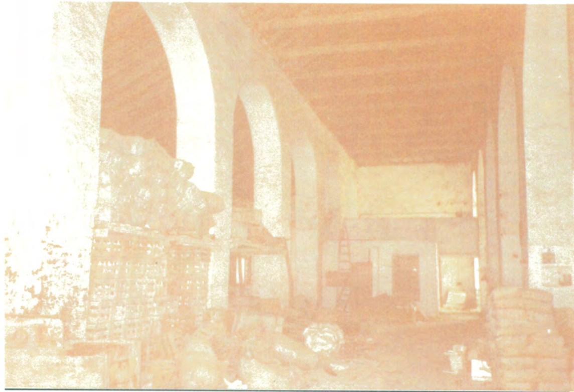
7. Nave Central del Pósito vista desde la cabecera, de planta basilical, arcos de medio punto sobre pilares de ladrillo y cubierta a dos aguas de par y nudillo.
