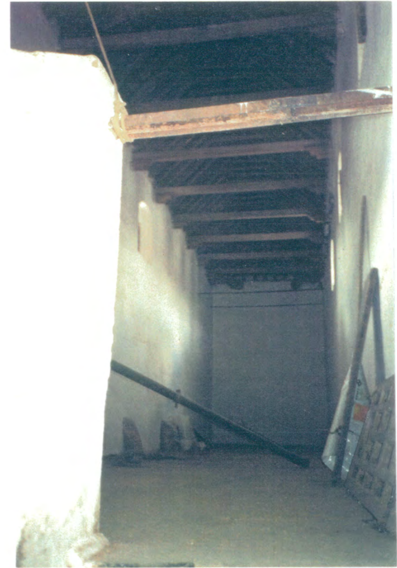
28. Interior de nave oeste, de dos plantas de altura, cubierta a dos aguas y artesonado de par y nudillo.
