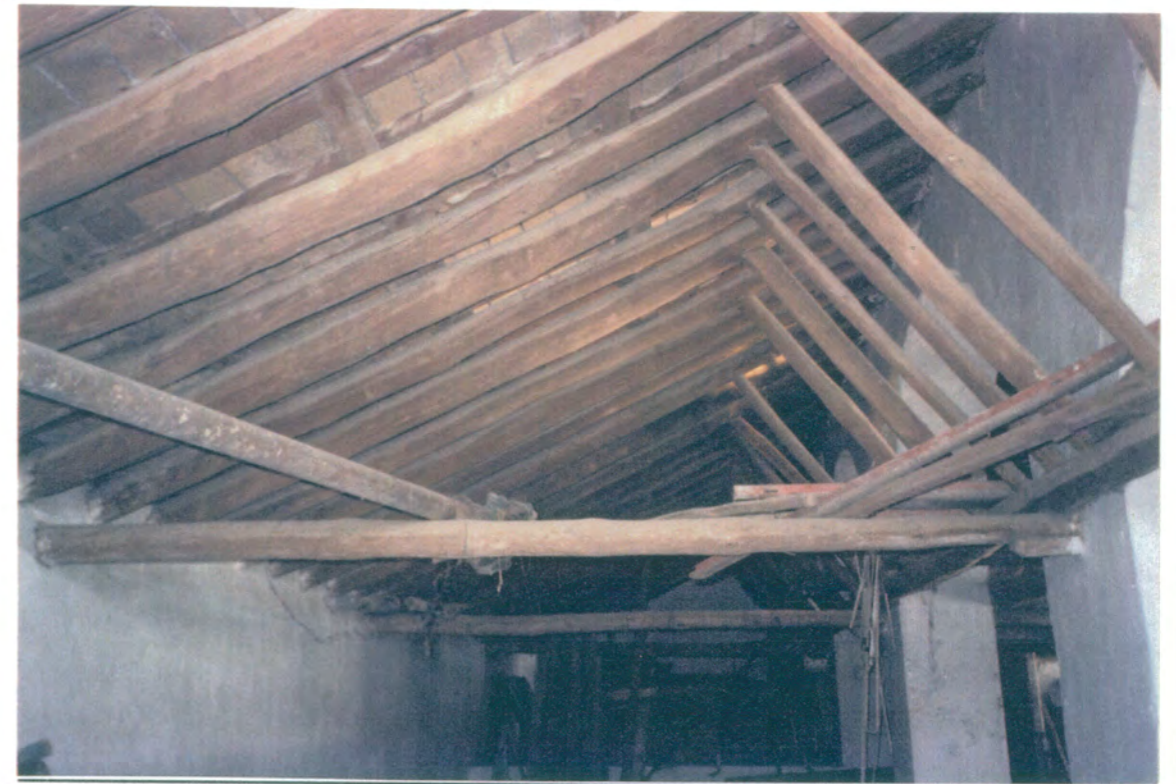
26. Detalle general del entramado que sustenta la cubierta a dos aguas.
