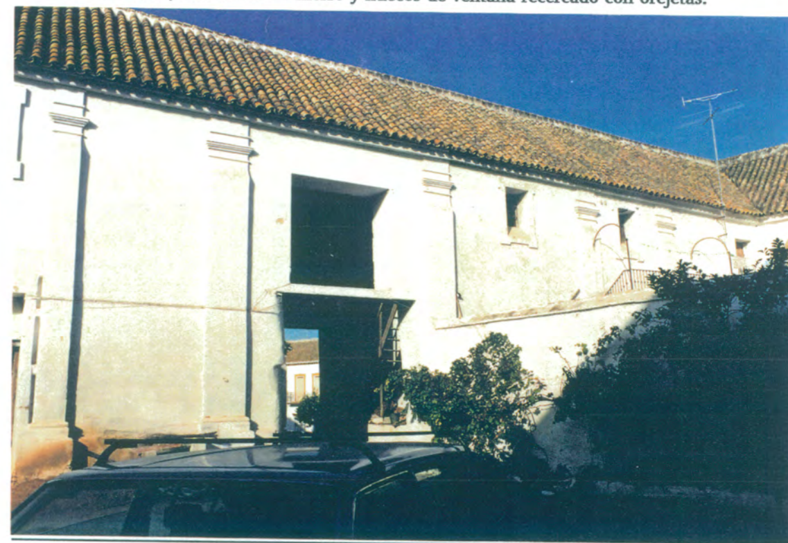
14. Fachada interior del patio, lado central. Se observa el portalón oeste por el que se accede desde C/ La Cilla al patio.
