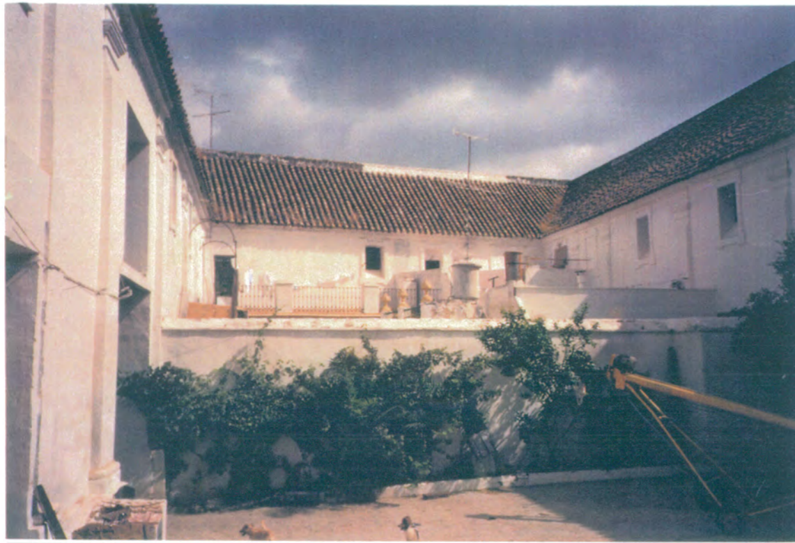
23. Cerramiento en el patio, que separa las segregaciones realizadas en el ala norte.
