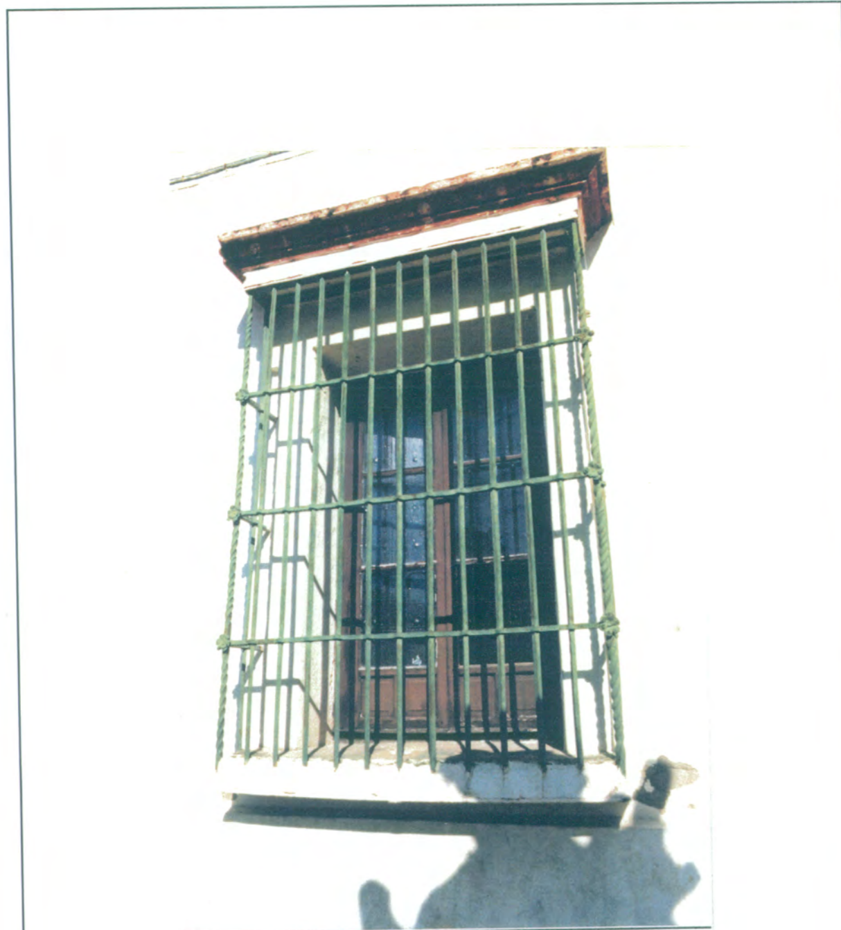
7. Detalle de cierro en planta baja fachada principal.
