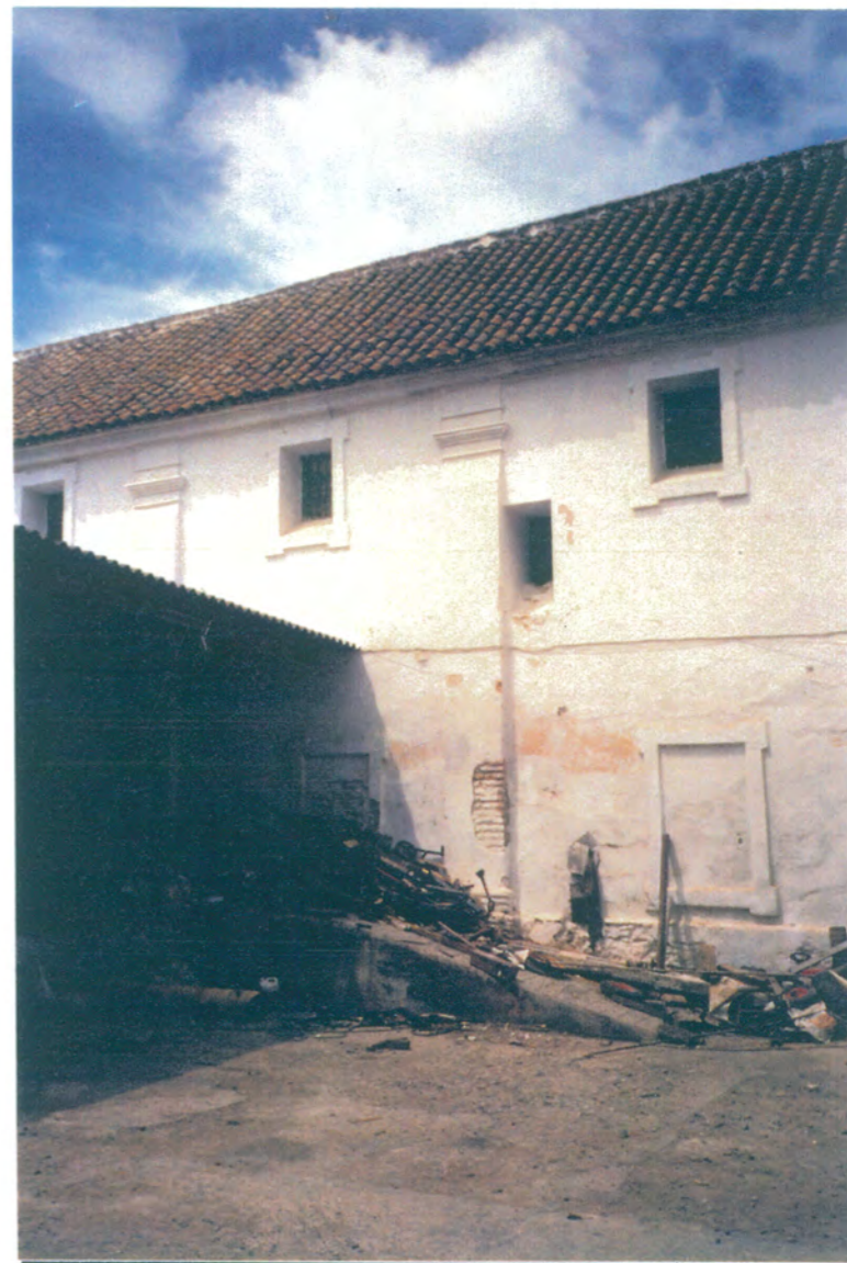
16. Nave oeste, fachada desde el patio interior, lado derecho.
