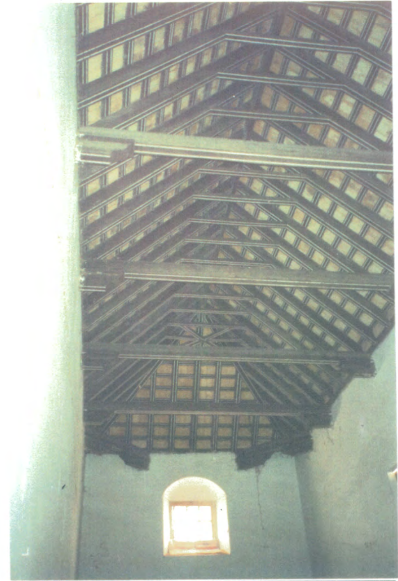
30. Cubierta a dos aguas y artesonado de par y nudillo del granero, nave este.
