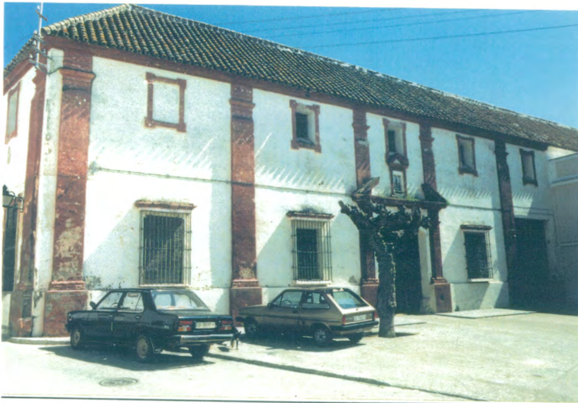
1. Vista general del edificio . Fué proyectado en 1771 por el maestro mayor del Arzobispado Hispalense, José Alvarez.
