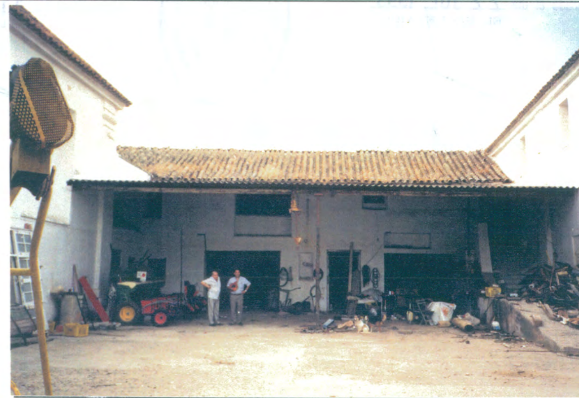
21. Tinglado con cubierta de uralita, adosado a la construcción que resta del siglo XVII, en el lado sur.
