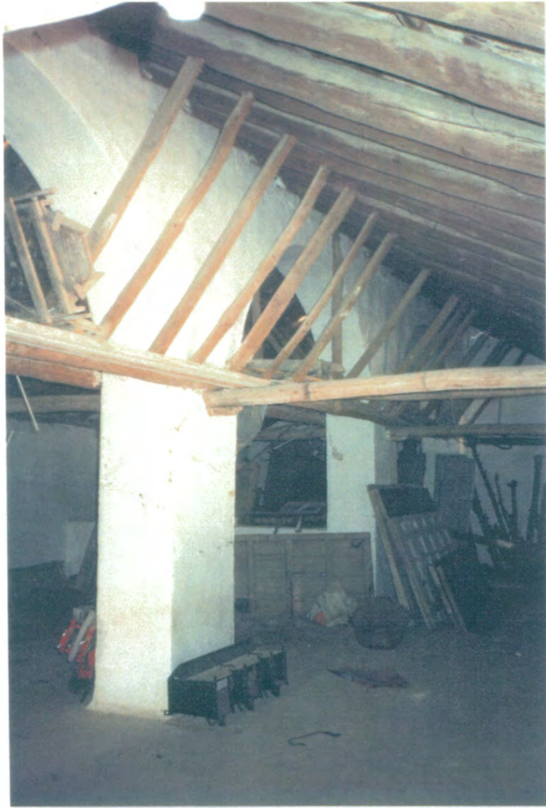
27. Detalle de escalera, de los tirantes y puntales del entramado.
