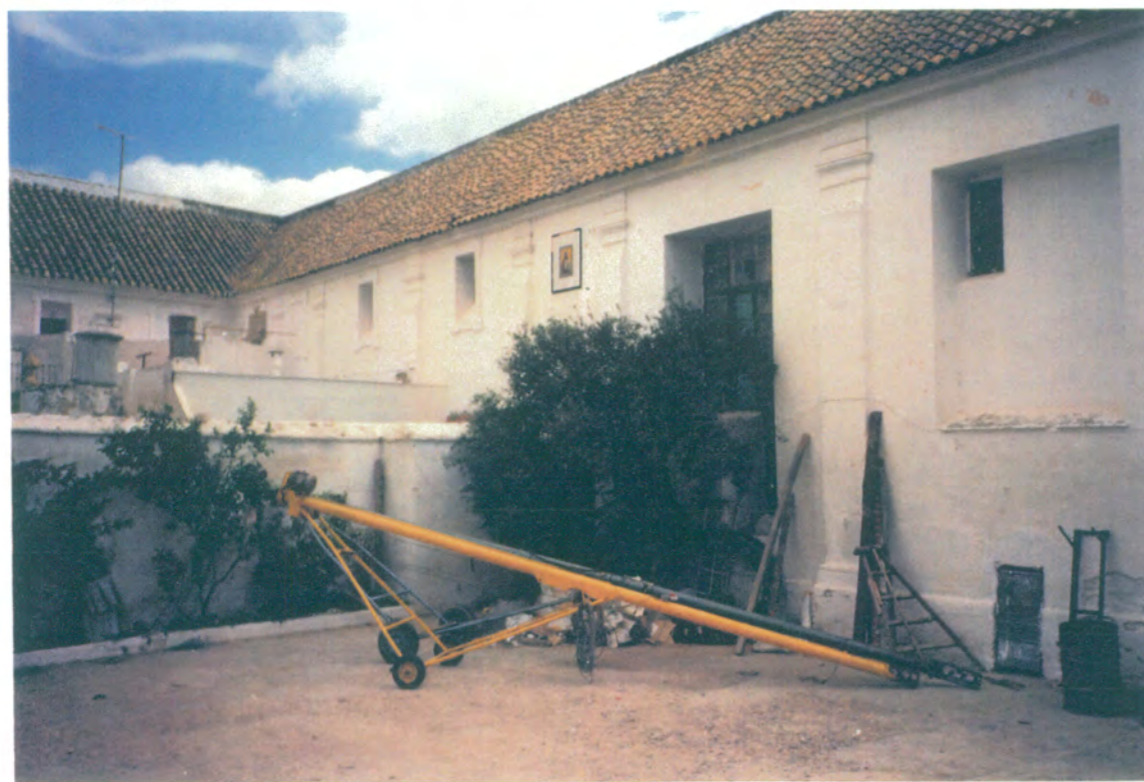
20. Nave este, puerta interior al patio, formada por pilastras toscanas gigantes y azulejos con imagen que representa al Sagrado Corazón.
