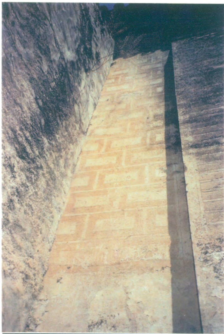
10. Detalle de esgrafiado a base de rectángulos del muro de cierre, sur de la fachada principal.
