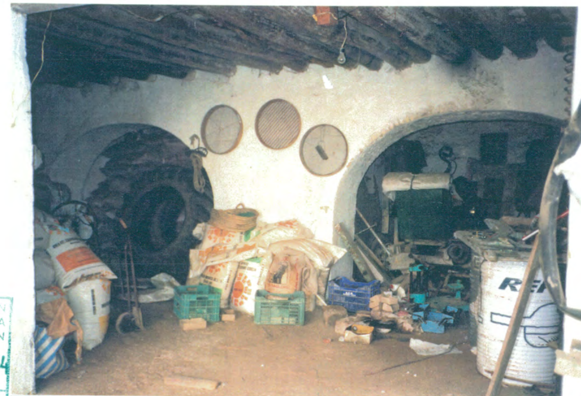
22. Primera crujía en planta baja de la nave sur. Restos del siglo XVII, formada por arcos rebajados y cubierta por rollizos de madera, tablazón y ladrillos por tabla. Al fondo segunda crujía.
