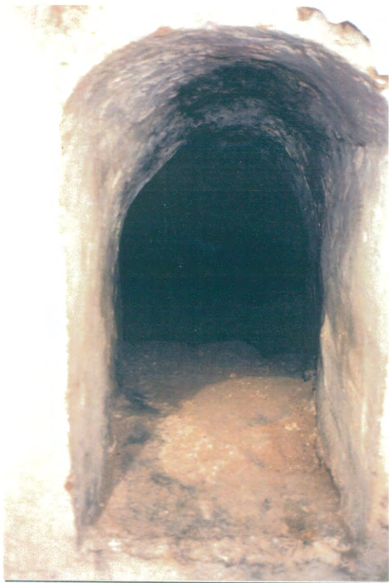
34. Cámara de vaciado de grano, nave este.
