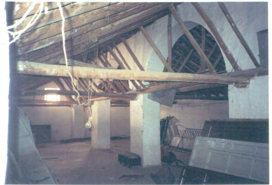
25. Planta alta de la nave sur. Resto de construcción del siglo XVII. Se accede a ella por escalera desde el patio. Sustenta la cubierta un entramado formado por vigas de rollizo, tablazón y ladrillo por tabla.
