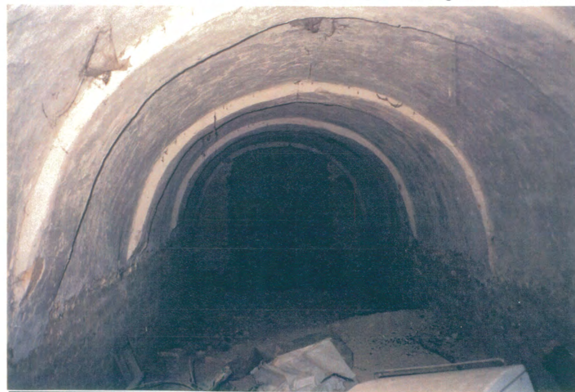
36. Semisótano formado por bóveda de cañón, que sirve para aislar el grano de la humedad.
