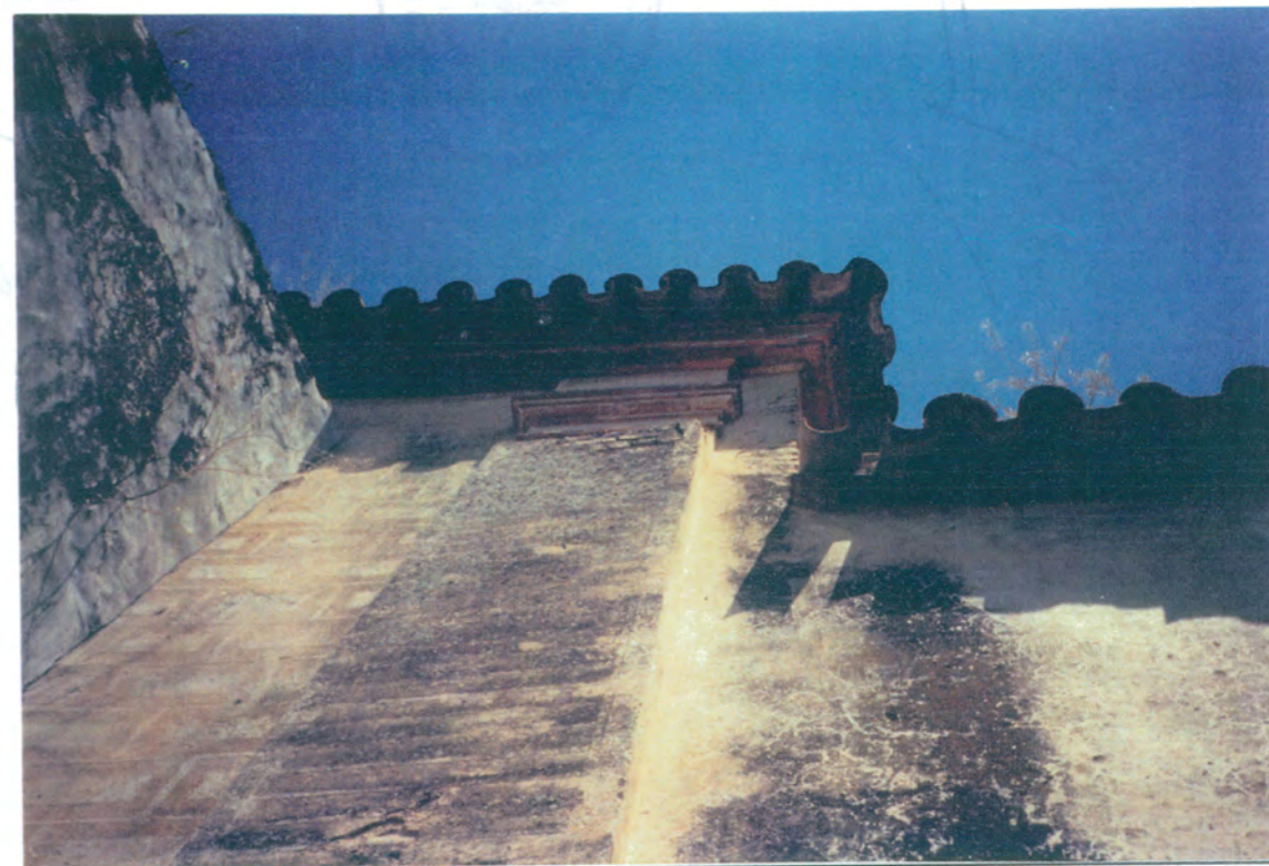
8. Detalle de pilastra y esgrafiado del muro de cierre, sur de la fachada principal.
