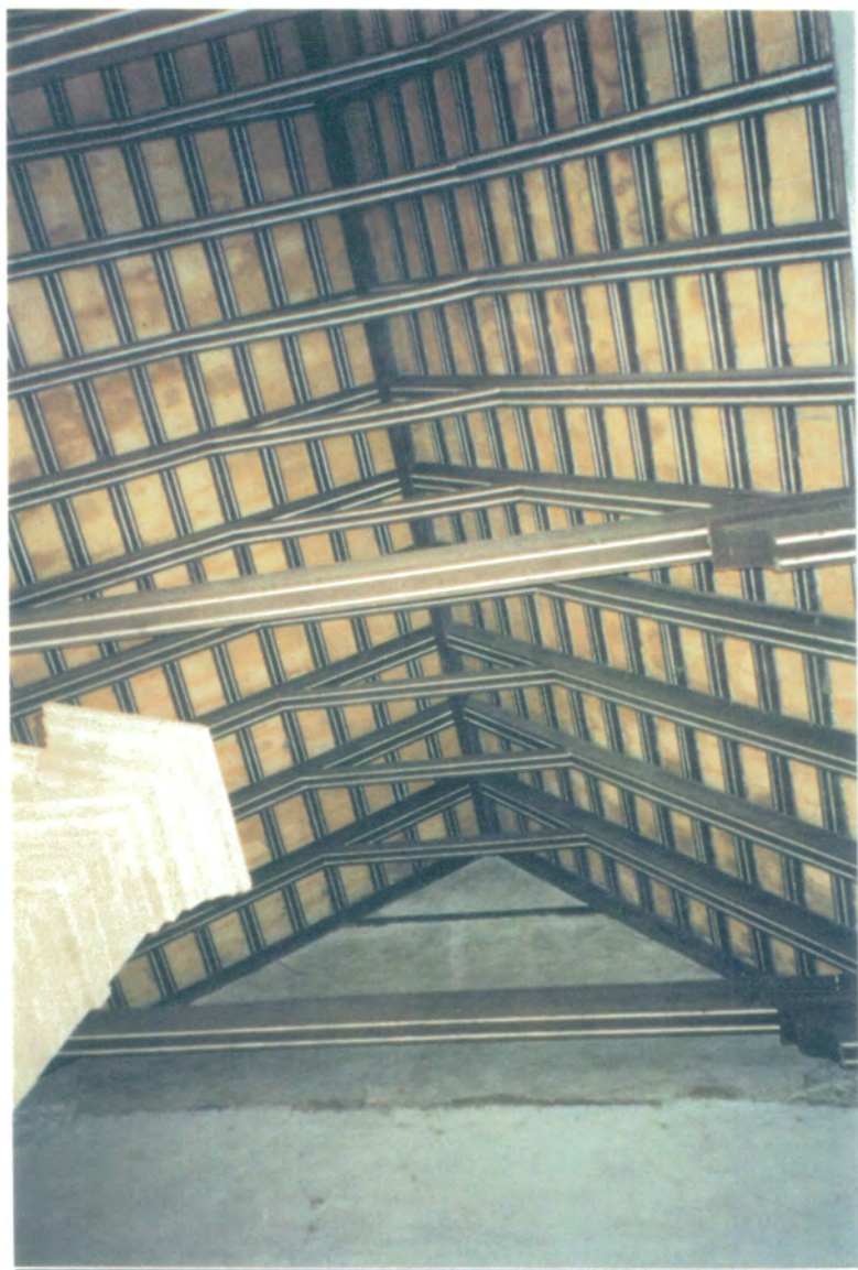
31. Detalle del artesonado, par y nudillo del granero, nave este.
