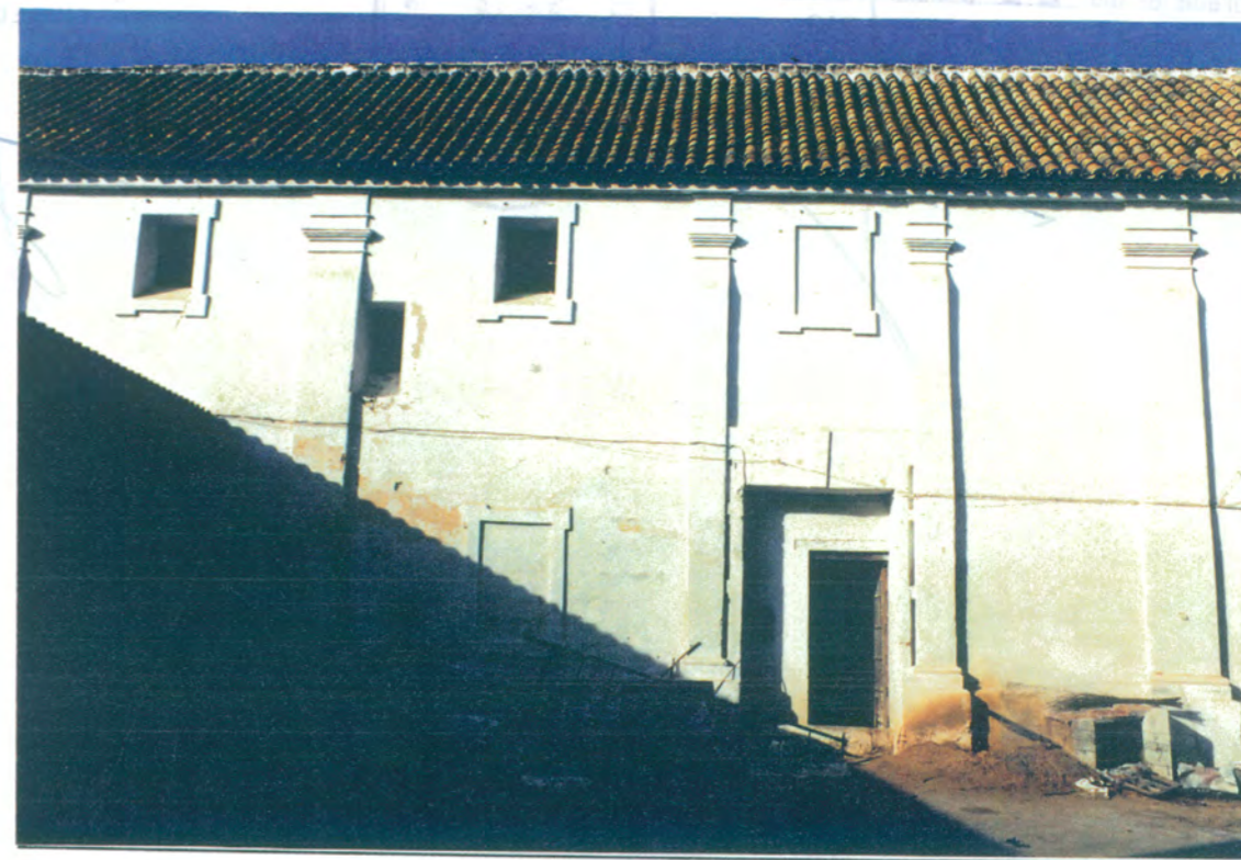
13. Fachada interior oeste del patio, lado izquierdo. Se observa puerta de entrada a la nave, de madera, con clavos de hierro y huecos de ventana recercado con orejetas.
