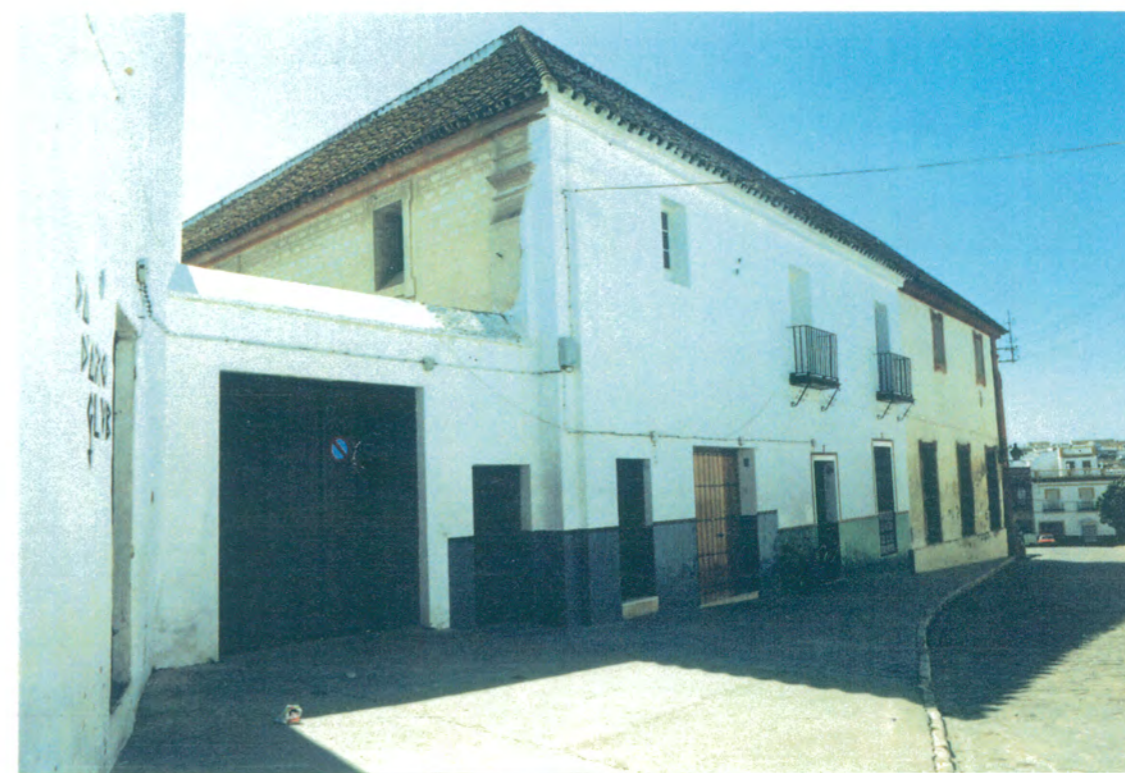
6. Fachada lateral, donde se observan las modificaciones introducidas, y en el muro este pilastra gigante y esgrafiado.
