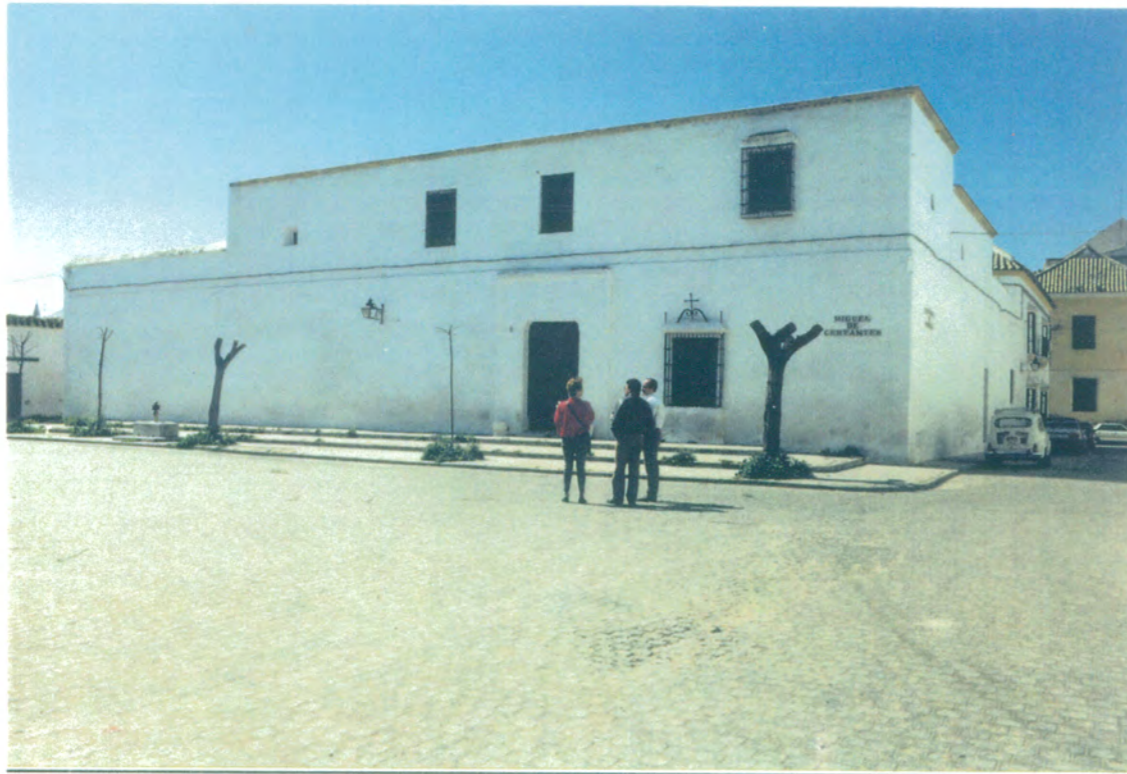
1. Vista general del edificio, de dos plantas, con portada mudéjar de ladrillo del S. XVI, adintelada, enmarcada por una cornisa con baquetones a modo de alfiz; posee reja del S. XVIII, esta reja está situada en el ciérro de planta baja donde estuvo situada la capilla.
