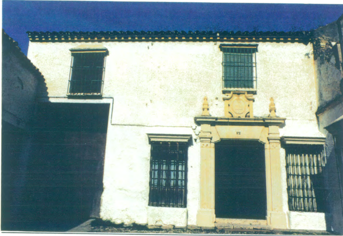
1. En barreduela de C/ Doctor Diego Sánchez, portada de cantería adintelada, enmarcada por pilastras de transición neoclásica y escudo de Díez de la Cortina, de principios del S. XIX.
