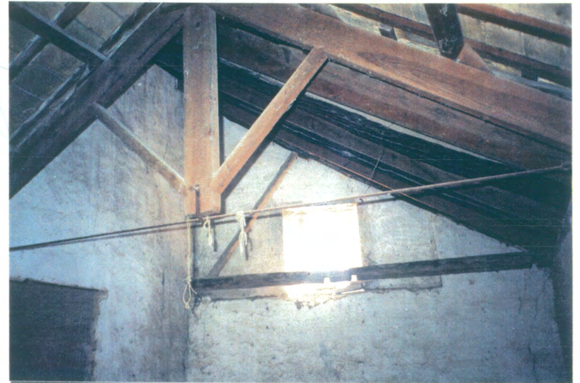
32. Detalle de cercha de madera, tirante de hierro y ladrillo por tabla del ala sur, vista hacia el ángulo suroeste.
