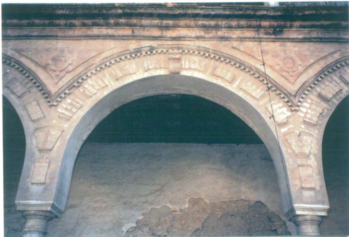
9. Detalle de arcada en planta baja, compuesta por columnas toscanas, arcos de medio punto, con claves resaltadas y decoradas con dados.
