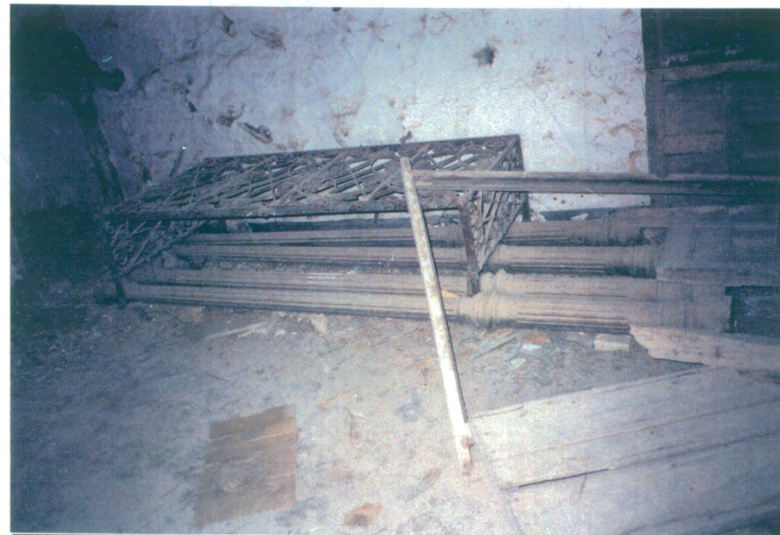
21. Vista de la habitación situada en el ala este al lado de la escalera tomada desde la galería. Las cuatro columnas son de hierro fundido y el balcón de hierro forjado.
