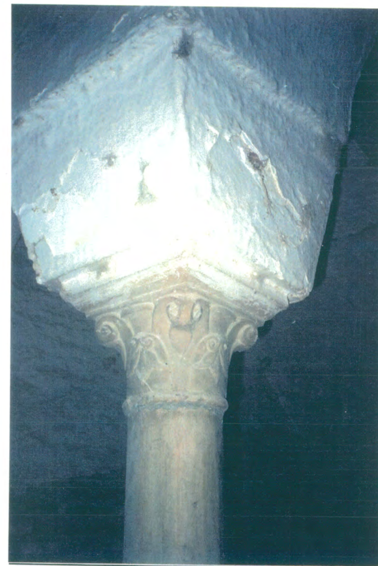
19. Detalle del capitel de la columna toscana sobre la que se apean los arcos que dan acceso a la escalera principal.
