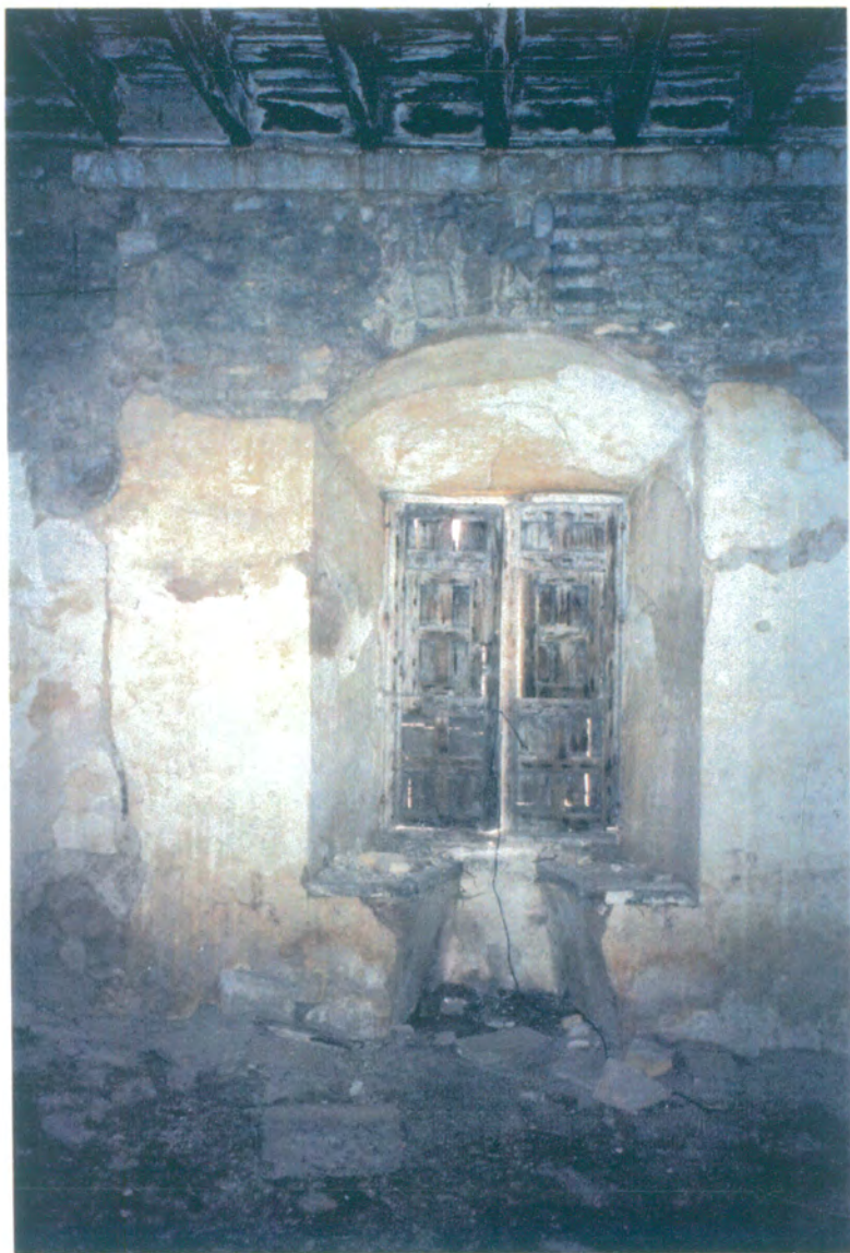
29. Hueco de ventana con carpintería de madera y asientos de cerámica embebidas en el muro. Situada en la segunda crujía de planta alta, en el ala norte.
