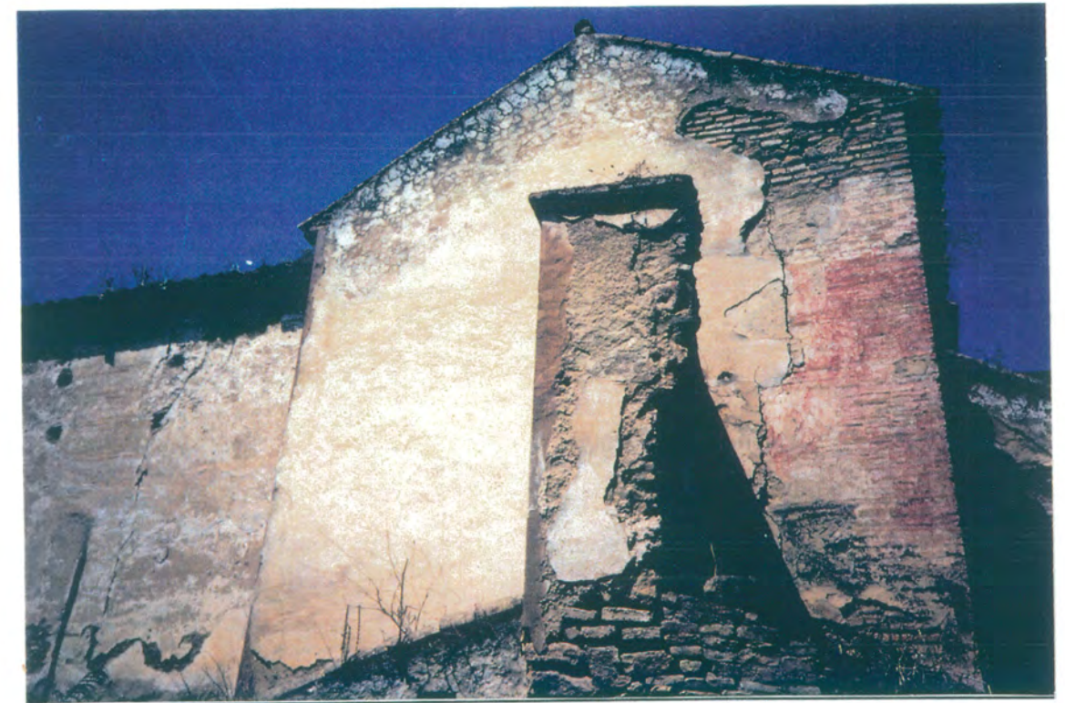
41. Vista desde el solar colindante del alzado este del ala norte. (El tiro de chimenea que aparece en primer lugar no pertenece al edificio que nos ocupa).
