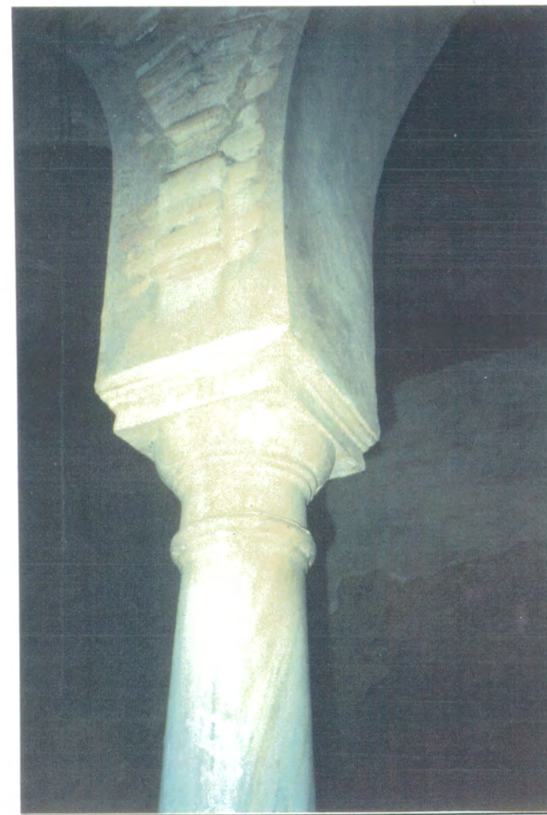
17. Detalle de capitel y arranque de los arcos de las galerías de planta baja.
