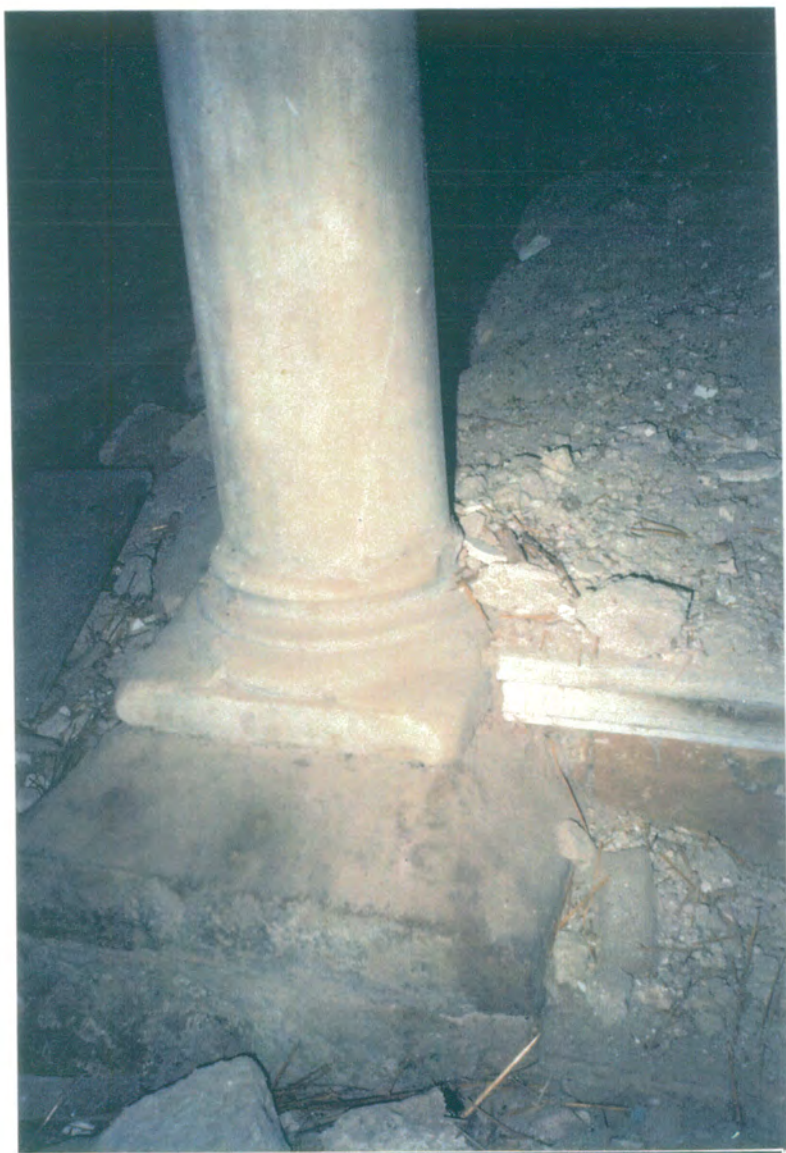
18. Detalle de basa, sobre suplemento de piedra, de la columna que sustenta los arcos peraltados por los que se accede a la escalera principal.
