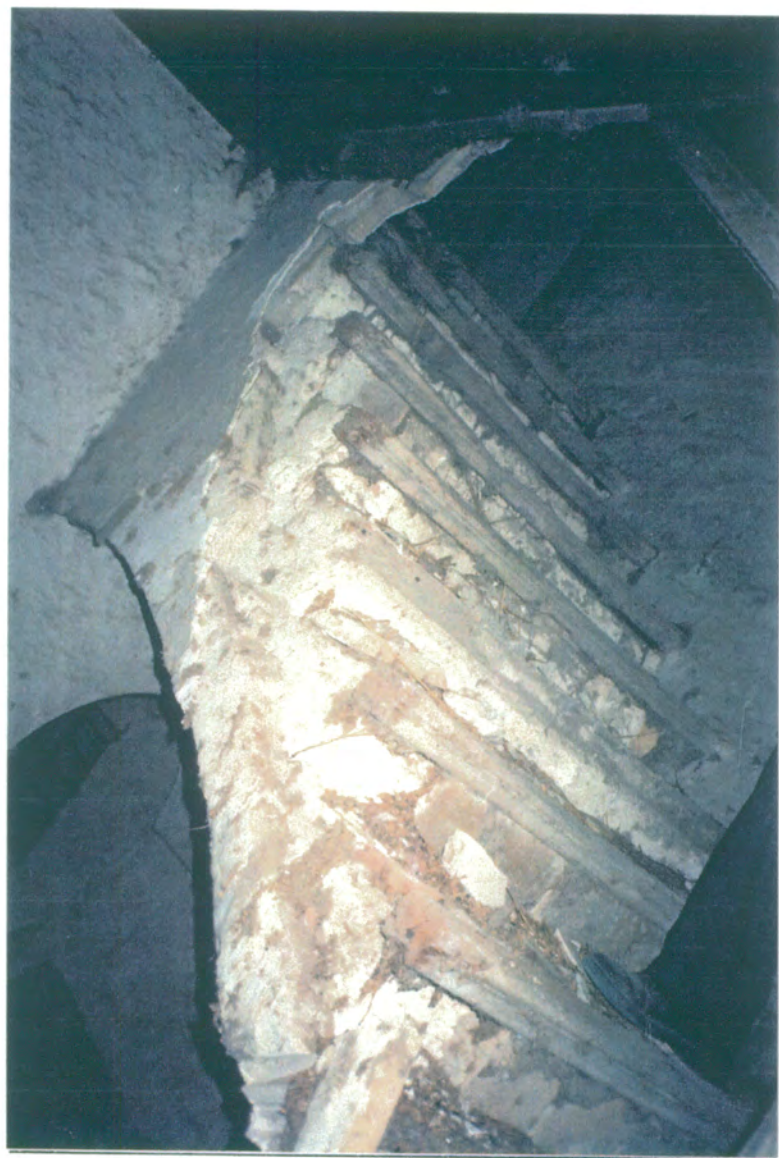
23. Detalle del segundo tramo de escalera donde se aprecian los escalones de ladrillo y maderlón de madera.
