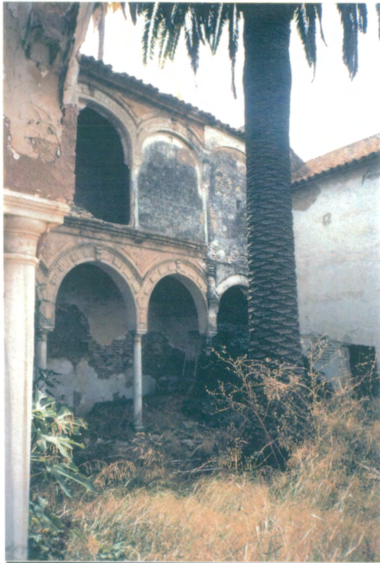
7. Vista del ángulo de las alas este y sur del edificio desde el jardín principal.
