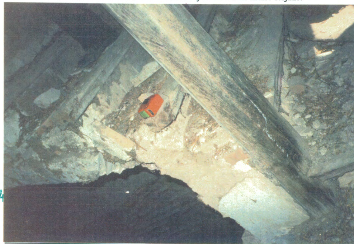
22. Detalle del segundo tramo de escalera. En primer plano pilar de madera que sustenta el artesonado del techo.
