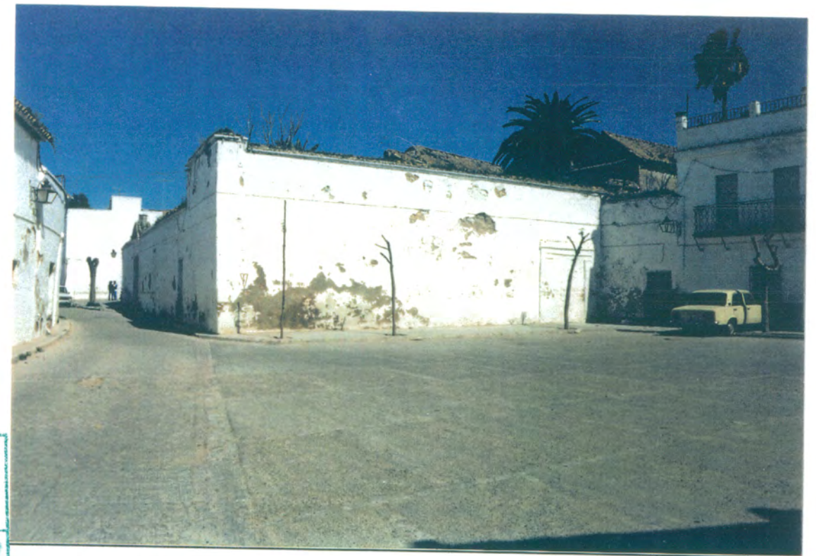
4. Vista del lado sur del cerramiento, donde se aprecia una puerta cegada formada por pilastra y dintel con cornisa.
