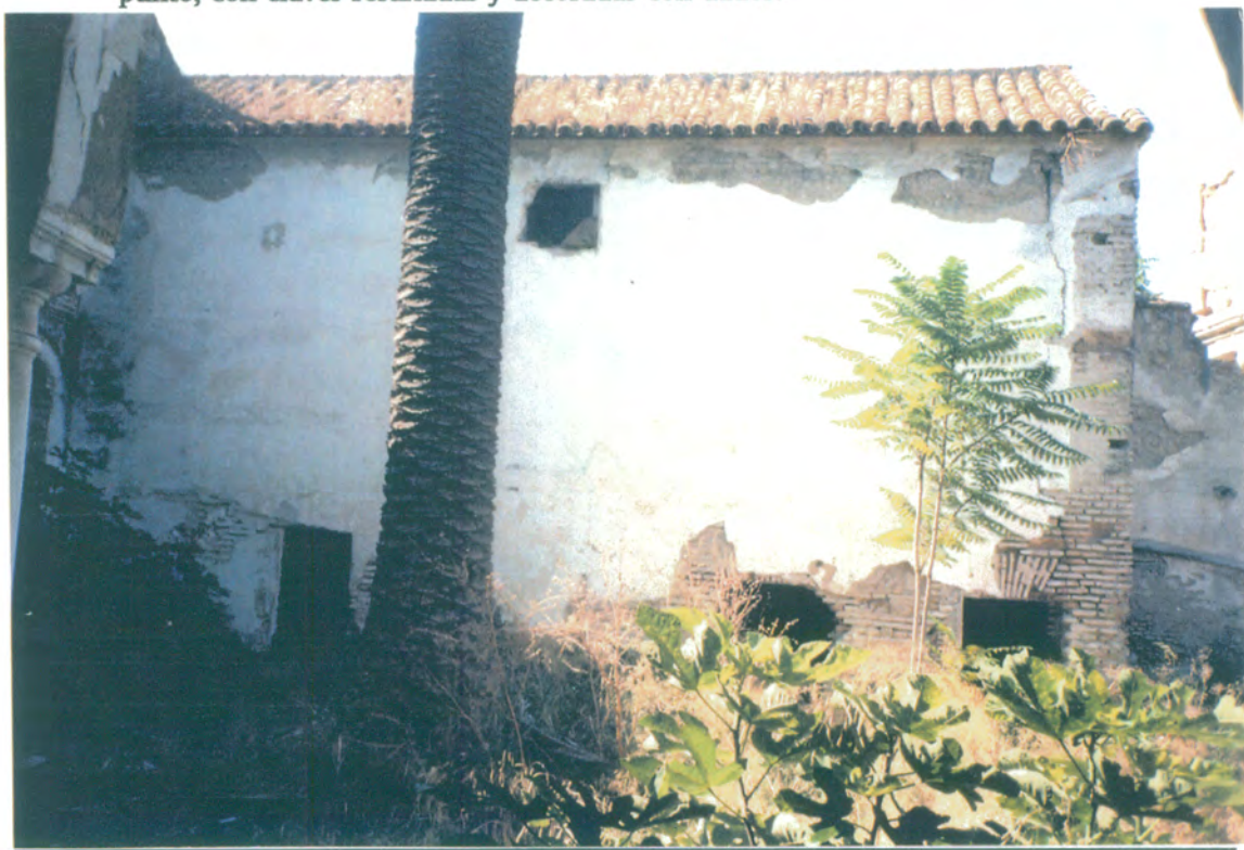
10. Alzado norte del ala sur desde el jardín principal, por el hueco situado en el lado derecho de planta baja, es por el que se accede al sótano.
