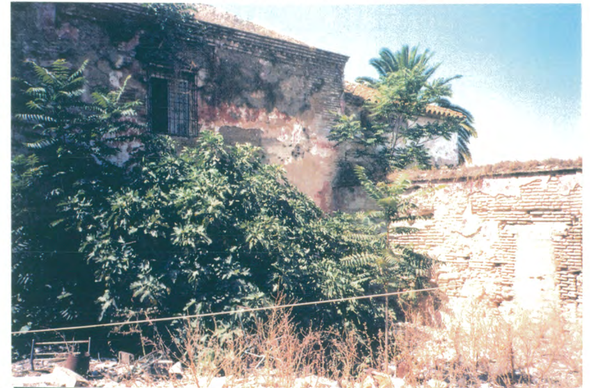
38. Vista desde la huerta del ángulo formado por la fachada norte, con el cerramiento que divide el jardín principal de la huerta.
