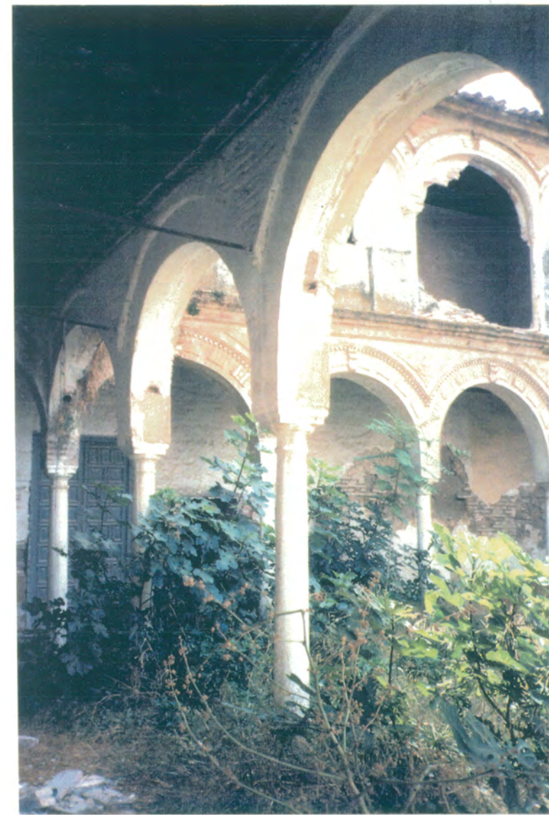
11. Vistas de las galerías de las alas norte y este del edificio.
