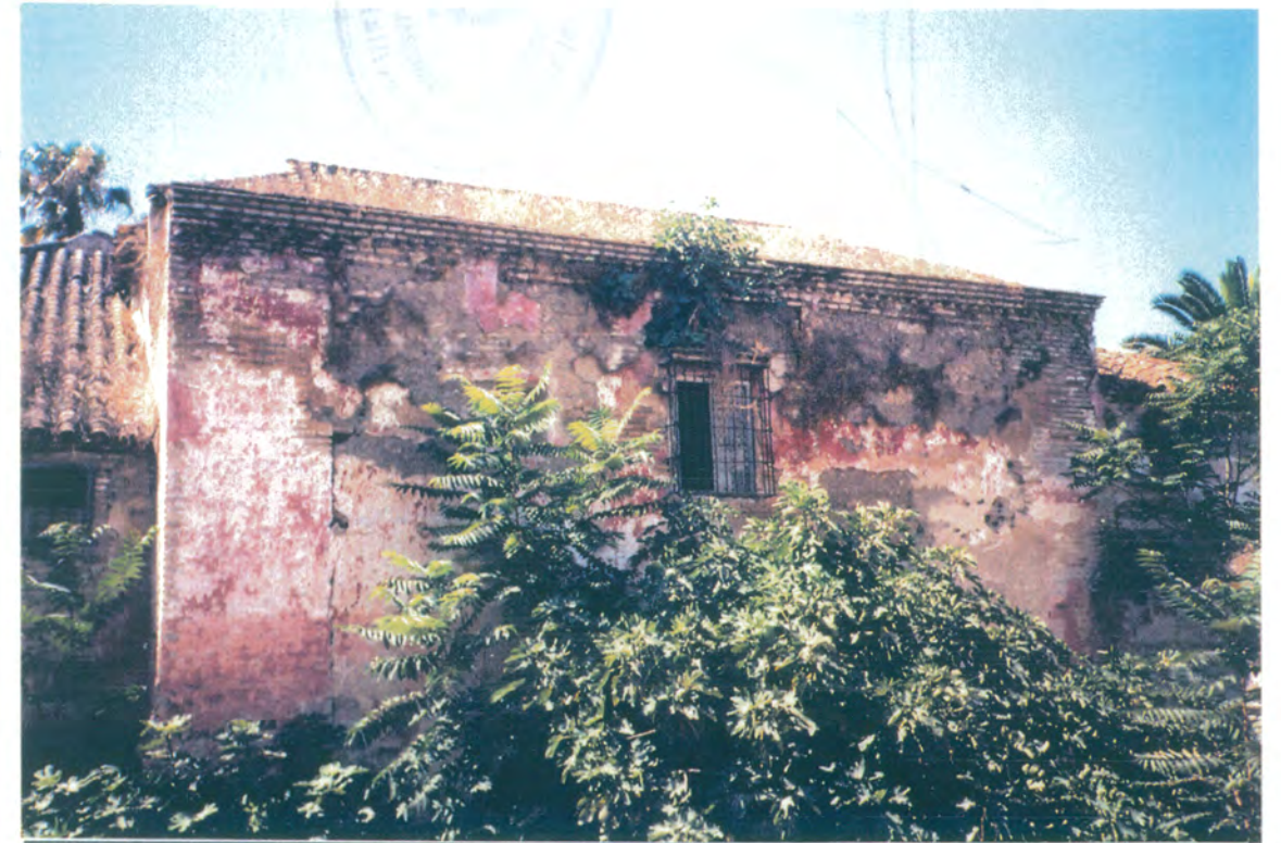
37. Vista desde la huerta del alzado norte. La cubierta es azotea perdida de ladrillo.
