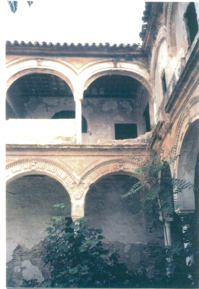
8. Vista del ángulo de las alas norte y este del edificio desde el jardín principal. En esta fotografía se observan las galerías sustentadas por arcadas de ladrillos, apoyadas en columnas toscanas, con claves resaltadas y decoradas con dados y arcos de medio punto en la planta baja y rebajados en la alta.
