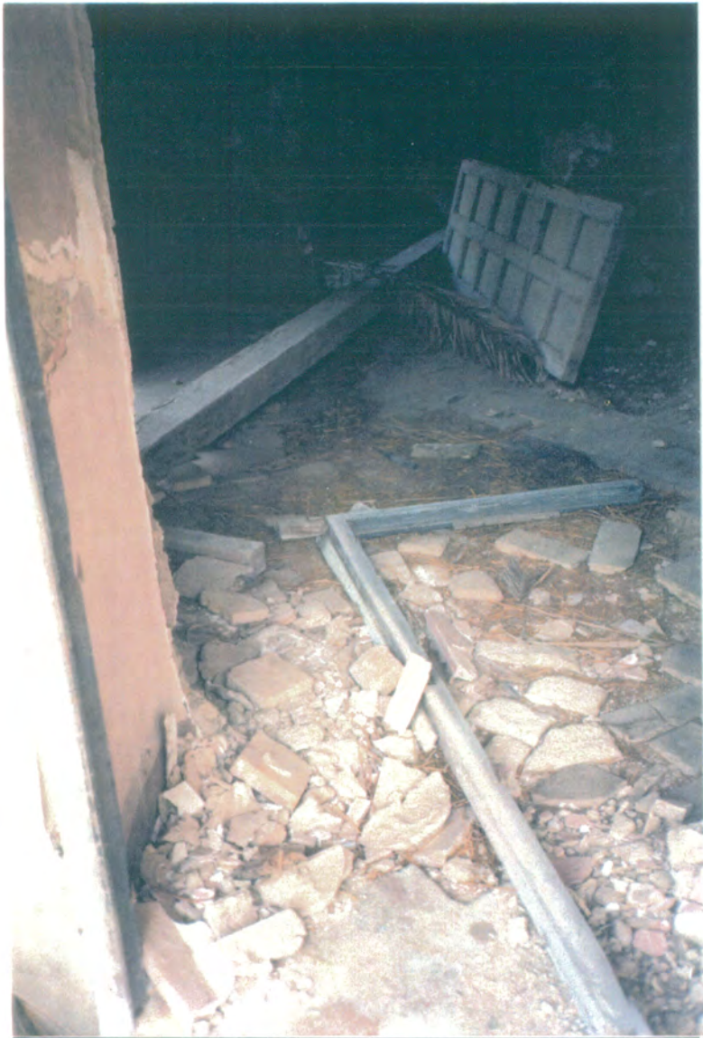
14. Habitación situada en la primera crujía de la planta baja del ala norte, fotografía tomada desde la galería.
