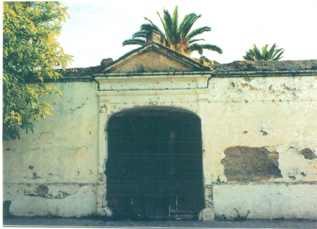
1. Detalle de portada en el cerramiento, a Plaza Miguel de Cervantes, formada por pilastras toscanas, cornisa y frontón.
