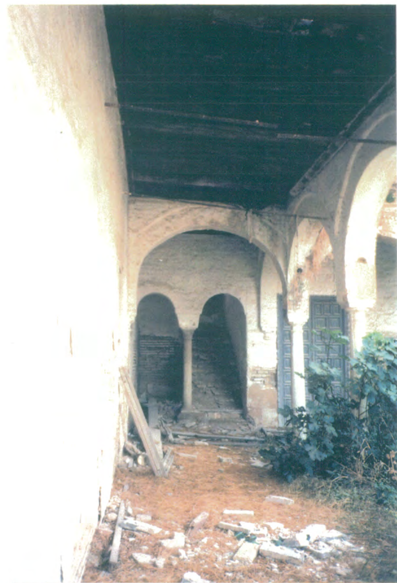
12. Desde la galería del ala norte, arranque de escalera.
