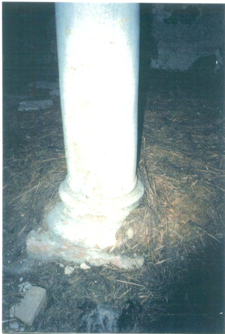
16. Detalle de base de las columnas toscanas situadas en planta baja.
