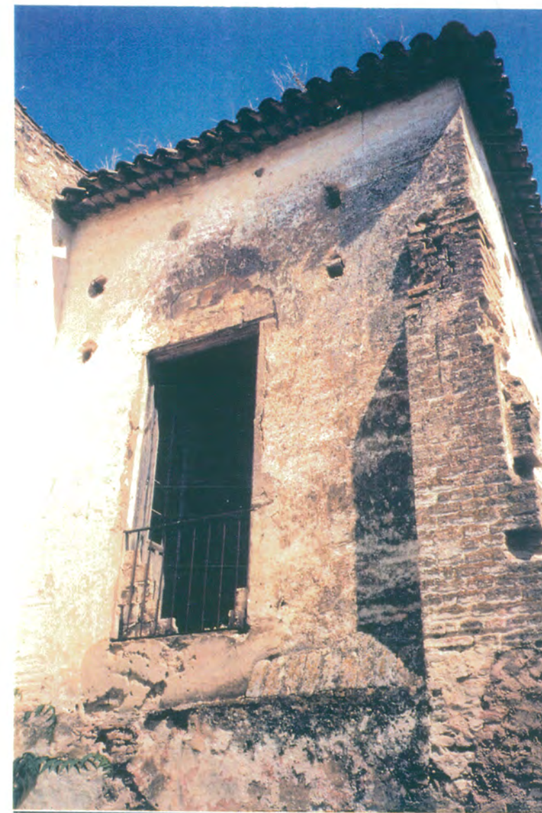
43. Vista desde el patio de servicio, de la planta alta de la fachada sur, del ala este.
