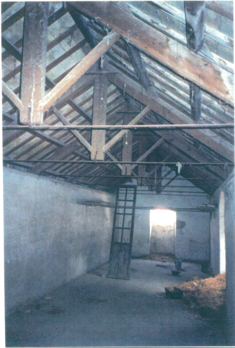
31. Cerchas de madera con tirantes de hierro y ladrillo por tabla para la formación de cubierta en el ala sur, vista hacia su lado oeste.
