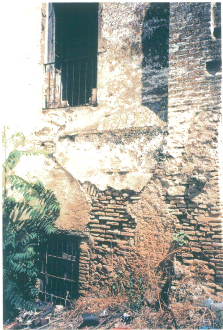
44. Vista desde el patio de servicio, de la planta alta y baja de la fachada sur, del ala este.
