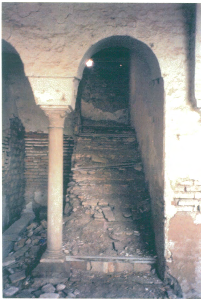
20. Vista general del conjunto de escalera, sobre la columna toscana arcos peraltados de medio punto, escalones de ladrillo y mampelán de madera, decorada con azulejos del S. XVIII desaparecidos.
