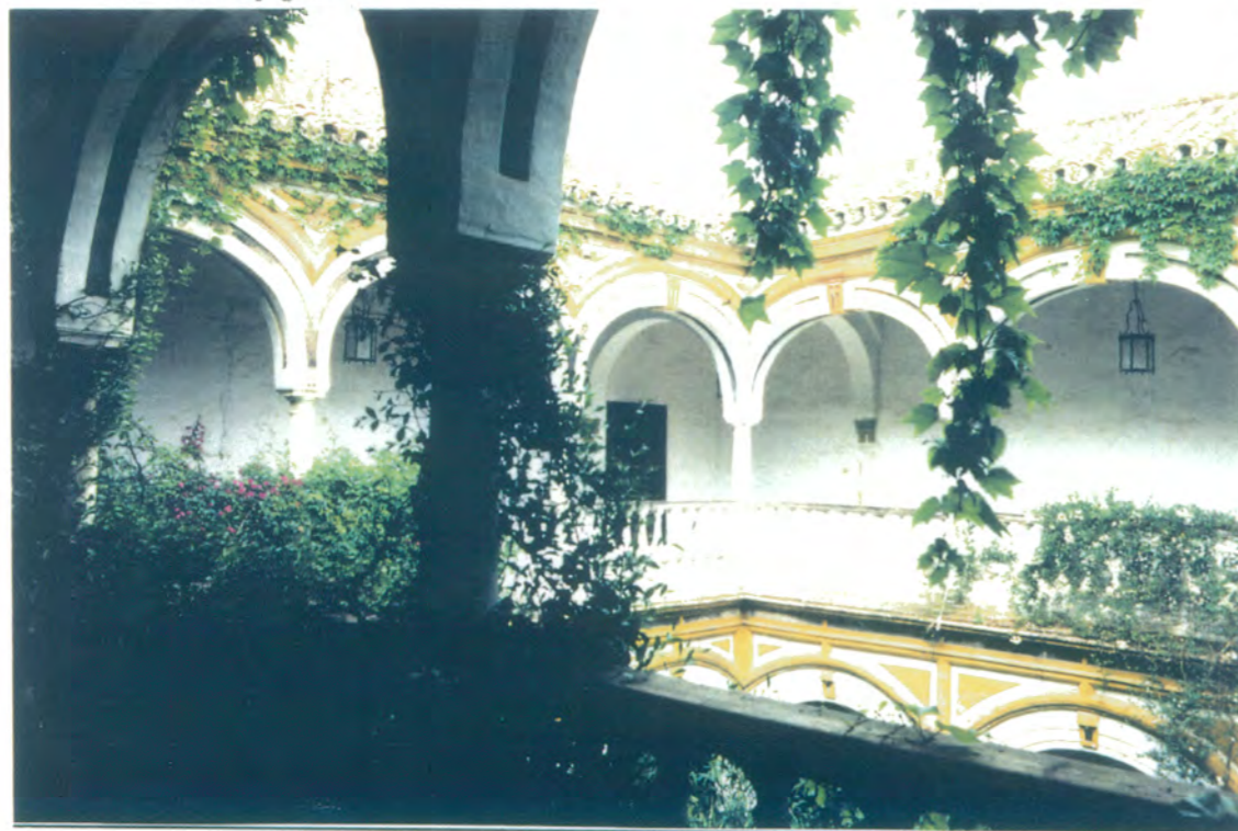
19. Vista general en planta alta de las galerías en tres de sus lados del patio principal, que se configura mediante arquerías rebajadas sobre columnas toscanas recercadas y decoradas con cartabones y claves resaltadas.
