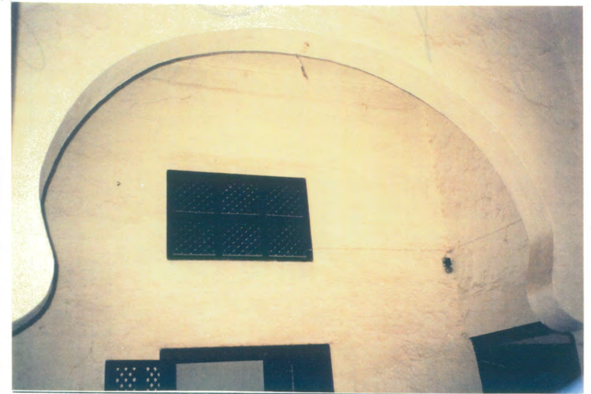
29. Pasillo del lado oeste por el que se accede desde la cocina al apeadero.
