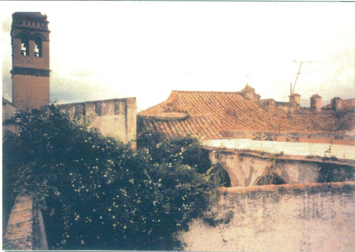
48. Desde la azotea visitable de la primera crujía del ala sur, huecos y azotea perdida del antepatio; al fondo cubierta de tejas de la escalera principal y de la segunda crujía y galería del patio principal del ala oeste y azotea de la segunda crujía del ala oeste.
