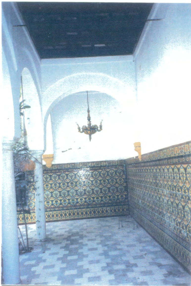
24. Encuentro de las galerías del lado este y norte del patio principal, con arcos de medio punto sobre columnas toscanas y pinjantes, zócalo de cerámica del S. XVIII y artesanado de madera de ladrillo por tabla.
