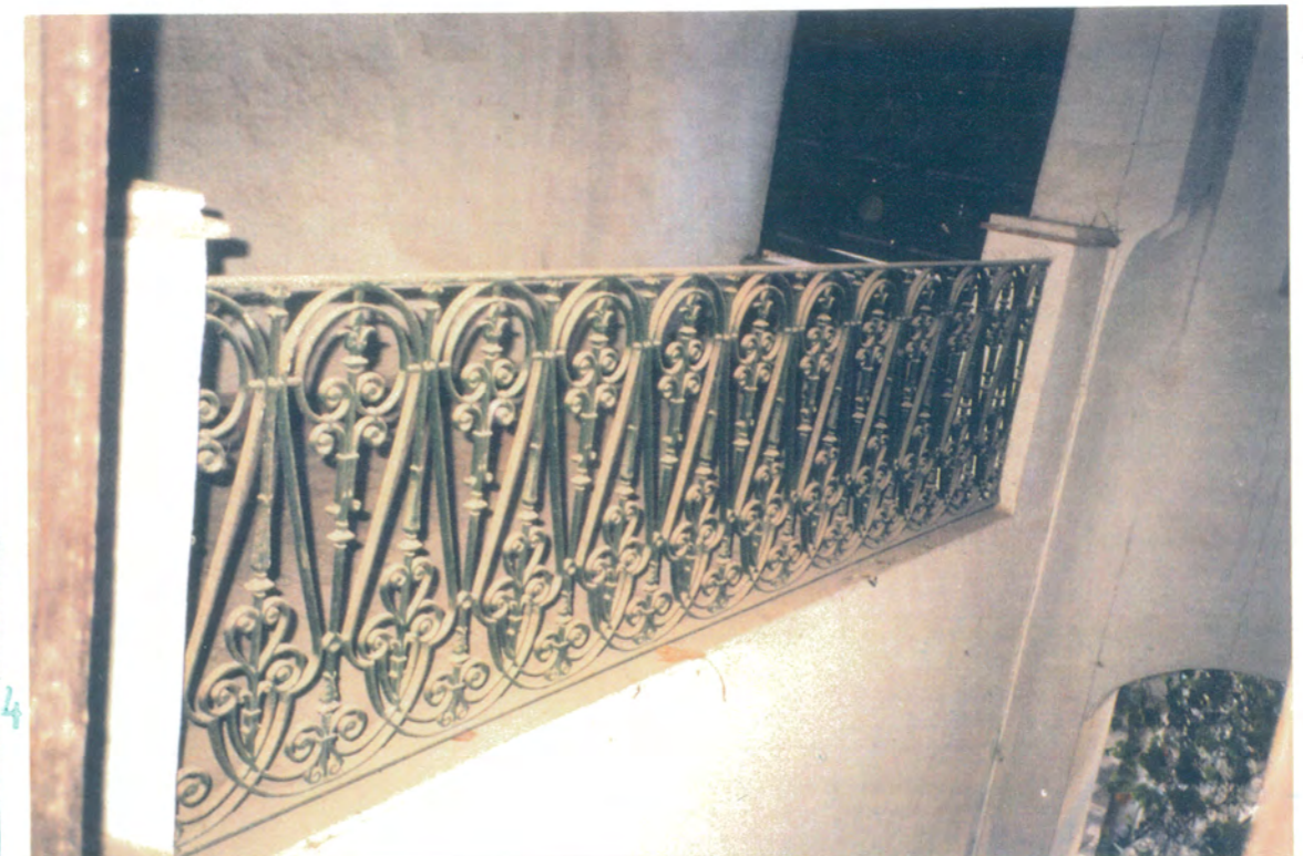
44. Detalle de la baranda en el descansillo de la escalera.
