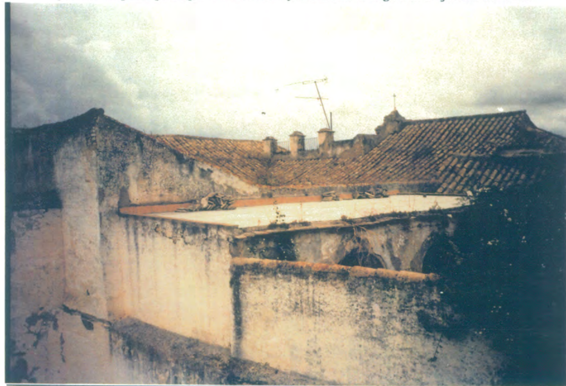
49. Desde el lado oeste de la azotea visitable de la primera crujía del ala sur, azotea perdida cubierta de tejas y azotea visitable de la segunda crujía del ala oeste.
