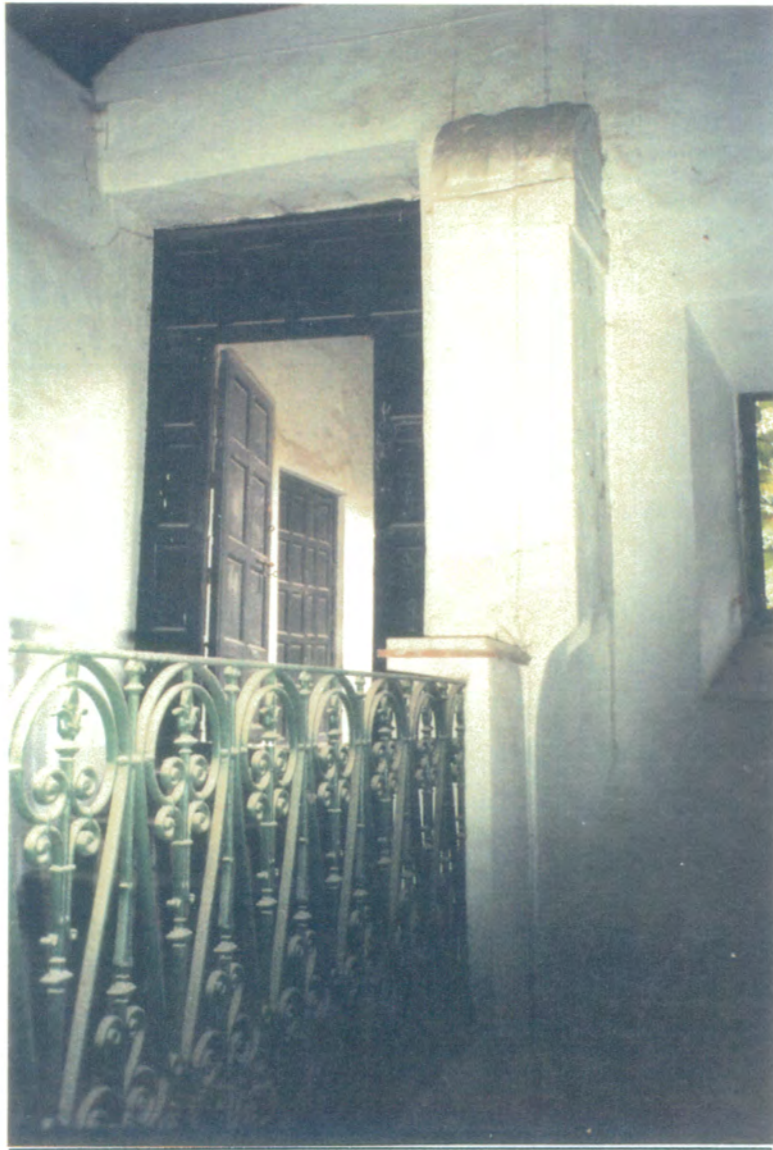
42. Vista desde el descansillo del desembarco de la escalera, hacia la salida a la galería del ala oeste del patio principal; barandilla de hierro forjado sobre contrafuerte y carpintería de madera del S. XVII.
