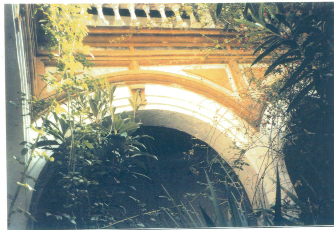
22. Detalle de arcos de medio punto, recercados y decorados con cartabones y claves resaltadas, situados en la planta baja del patio principal.
