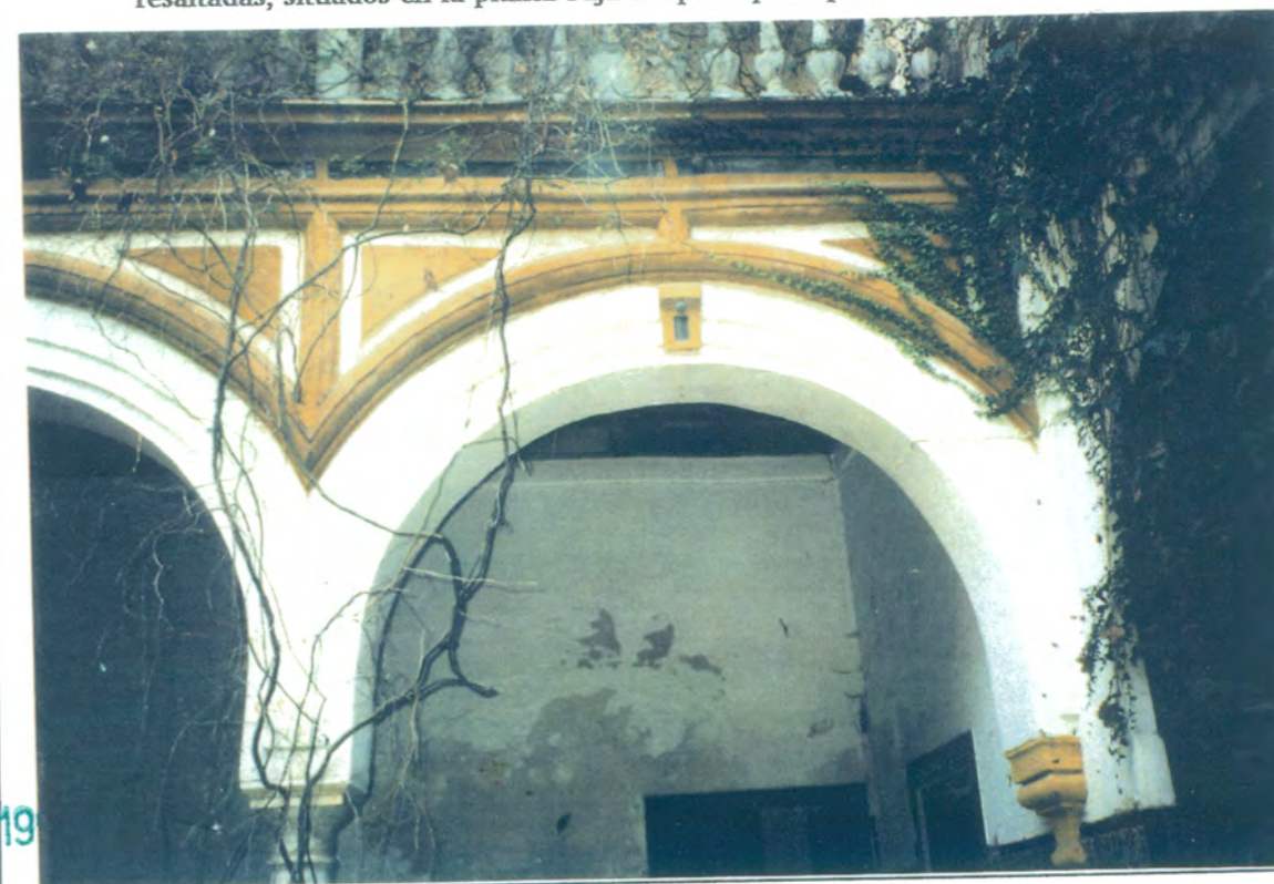
23. Detalle de arcos de medio punto sobre columnas toscanas, recercados y decorados con cartabones y claves resaltadas, situados en planta baja del patio principal.
