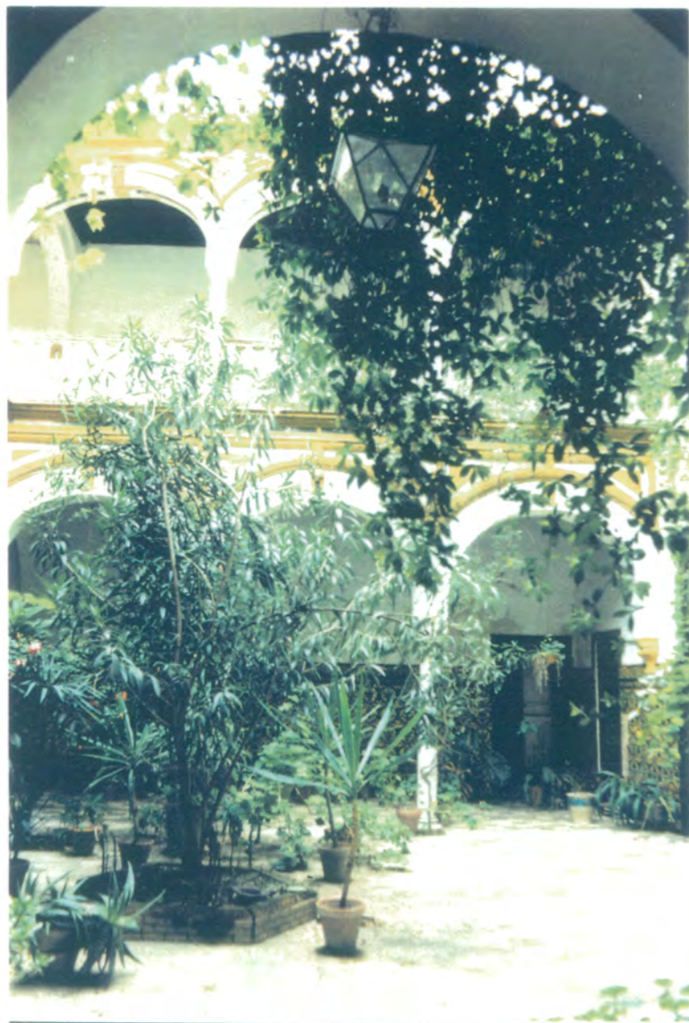
14. Vista general del patio principal, ángulo nordeste, configurado por galerías formadas mediante arquerías de medio punto en planta baja y rebajadas en planta alta. Todas sobre columnas toscanas.
