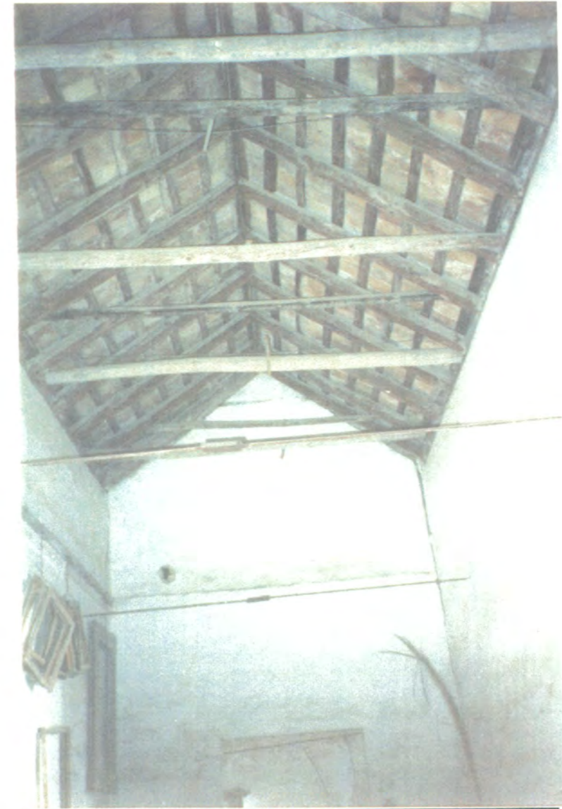
41. Vista de entramado para la formación de cubierta de la primera crujía del ala norte (c/ Doctor Diego Sánchez), formado por viguería y alfajía de madera y ladrillo por tabla.
