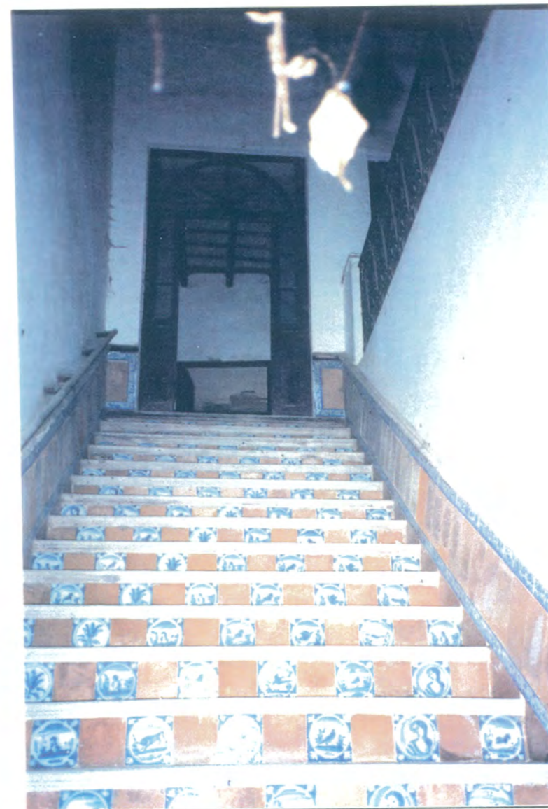
27. Desde el patio, escalera principal compuesta por peldaños de ladrillo, azulejos del X. XVIII y maderlán de madera. La zanca y el zócalo son del mismo material y el pasamanos de madera.
