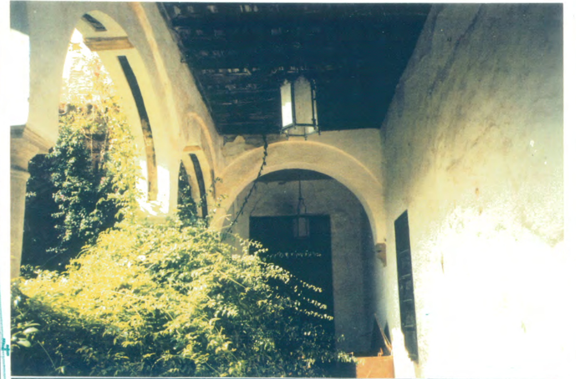
39. Vista de la galería de planta alta del ala norte y de este a oeste, vigería y tablazón de madera.
