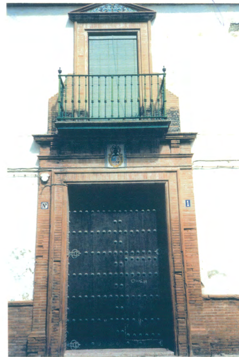
2. Detalle de portada de principios de este siglo de ladrillo visto, adintelada y enmarcada por moldura de ladrillo formando pilastra, en la clave del dintel escudo de azulejos, puerta de entrada de madera con clavos y bisagras de bronce, cornisa sobre canecillos de ladrillo en la que se apoya un balcón adintelado de ladrillo y frontón, con azulejos, la baranda del balcón es de hierro forjado.
