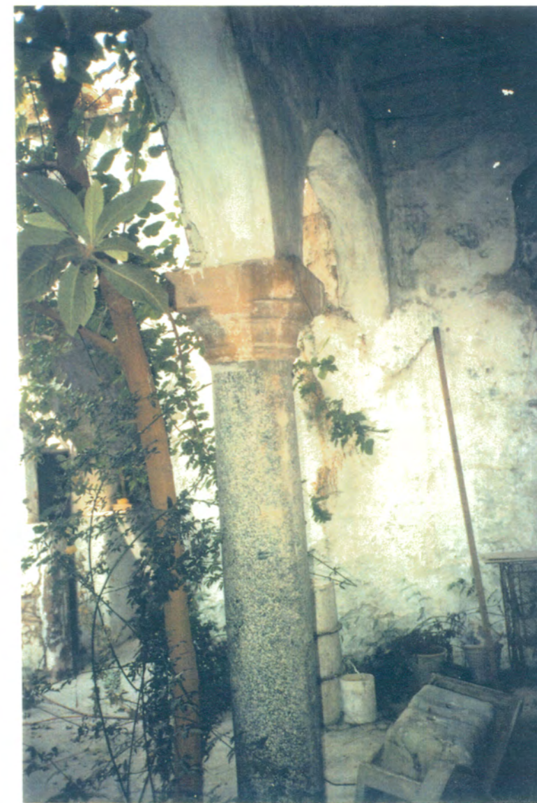
32. Vista del porche del apeadero formado por arcos de medio punto sobre columnas de granito.
