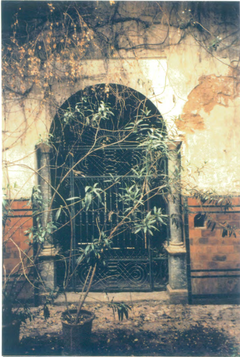
8. Desde el antepatio, vista del cancel de entrada y del zócalo de ladrillo con cantoneras y tiras horizontales de cerámica, de color verde.
