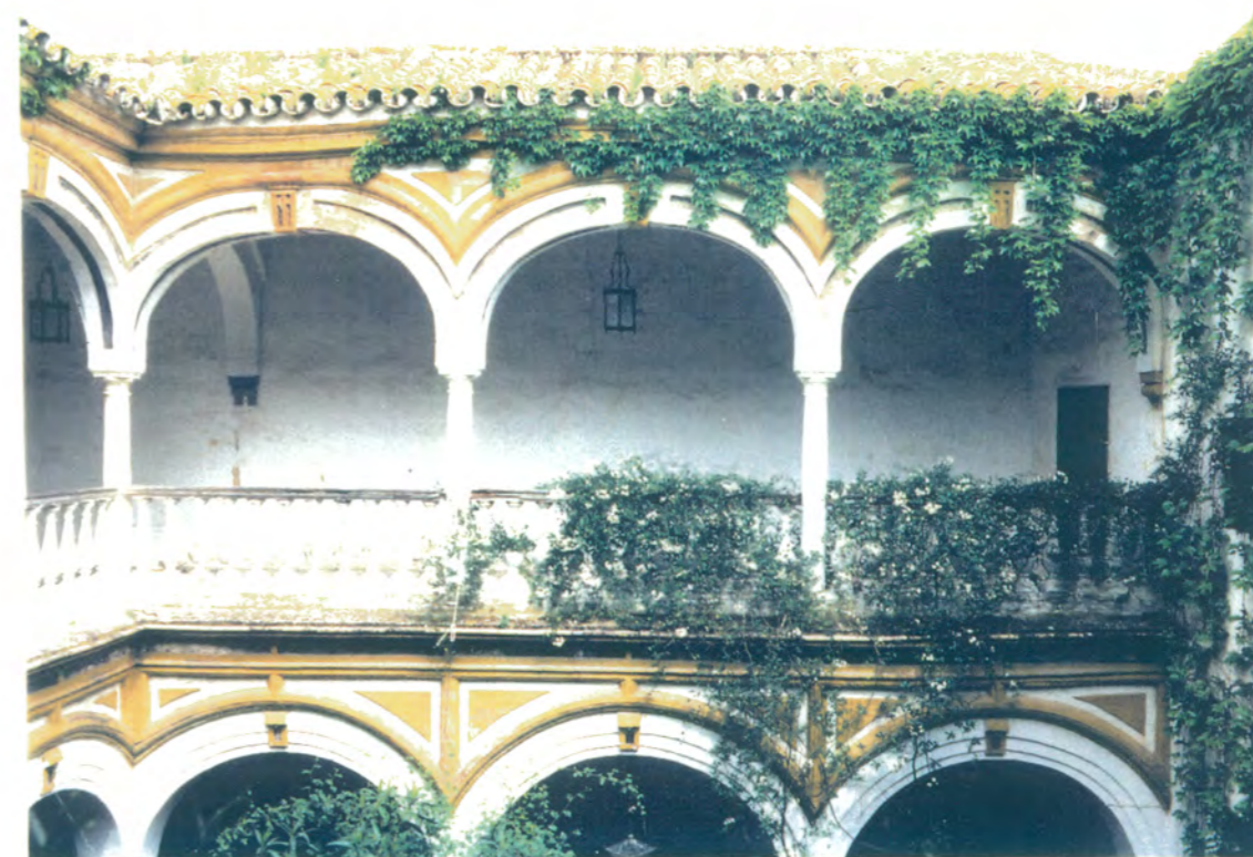
20. Vista de la galería norte en planta alta. Se observa la galería formada por arcos rebajados sobre columnas toscanas recercadas y decoradas con cartabones y claves resaltadas, balaustrada de mampostería enfoscada y pintada y pasamanos de madera.
