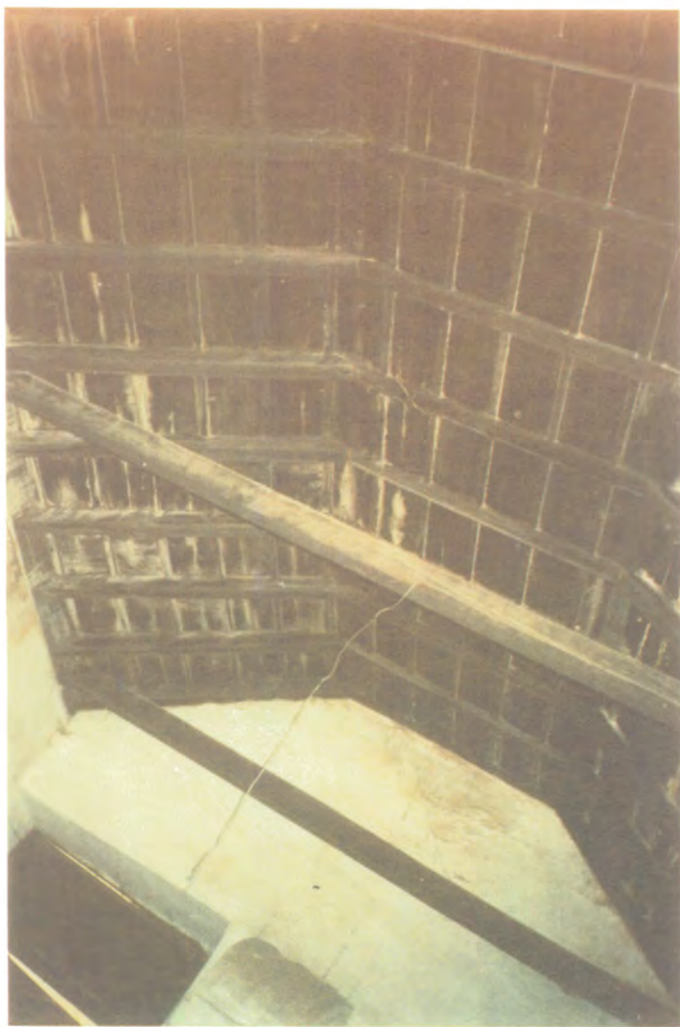
45. Vista del artesanado de la escalera principal, formado por vigería, alfajía y tablazón de madera.
