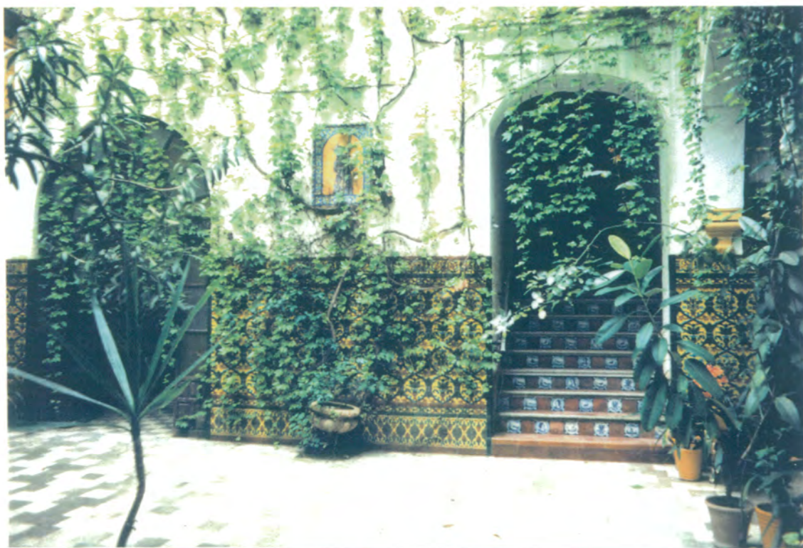
18. Vista del lado sur del patio principal. Se observa el arranque de escalera, el zócalo de cerámica, azulejo del Cristo el Gran Poder y pavimento con losas de cemento pretensado en blanco y gris.
