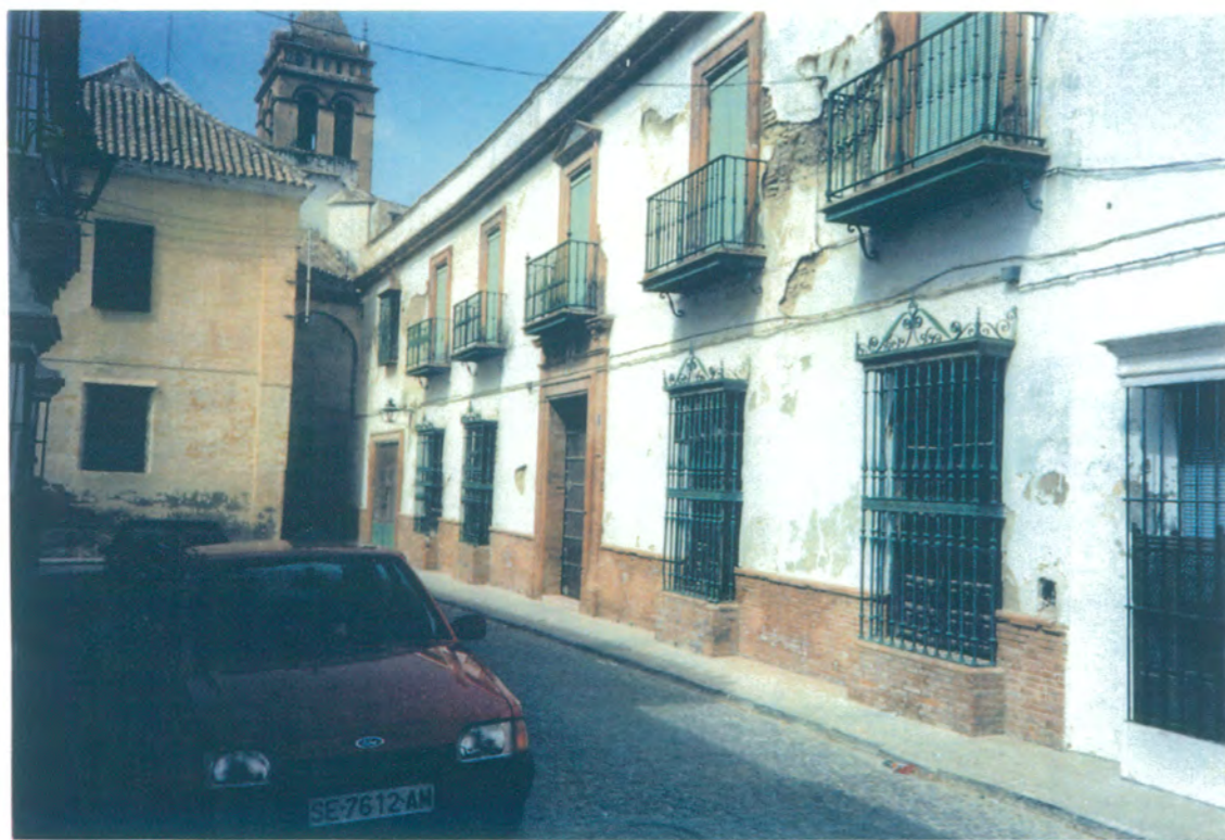
1. Alzado principal de principios de este siglo a C/ Crstóbal de Morales, al fondo arquillo de arriostramiento de la Iglesia de San Juan.
