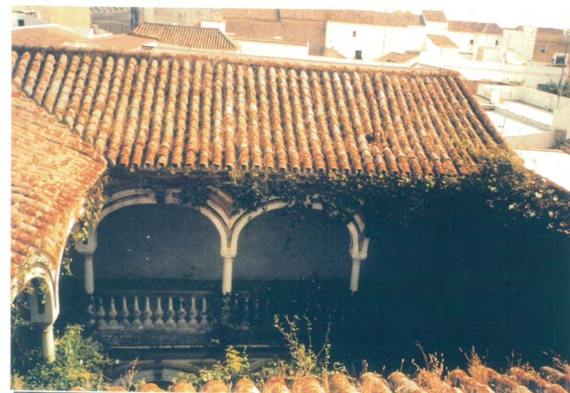
47. Desde la azotea del ala oeste, cubiertas de tejas de las galerías del patio principal, S. XVII.
