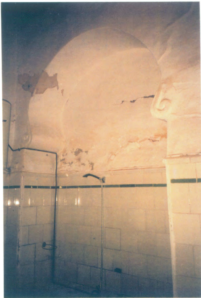
31. Vista parcial del cuarto de baño situado en la segunda crujía de fachada principal con ventana al antepatio, se accede a él a través de la habitación izquierda que da al zaguán.
