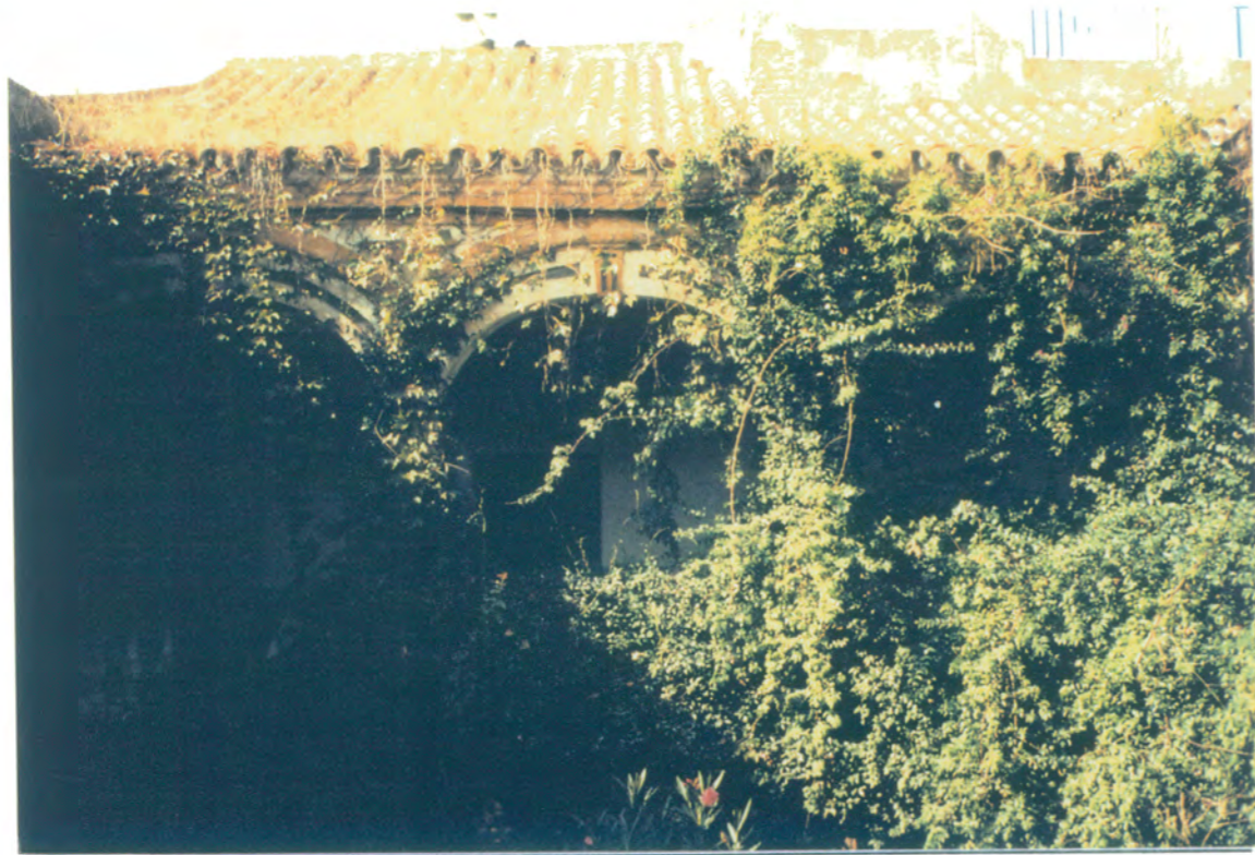
36. Desde la galería de planta alta del ala este del patio principal, vista de la galería del ala sur.
