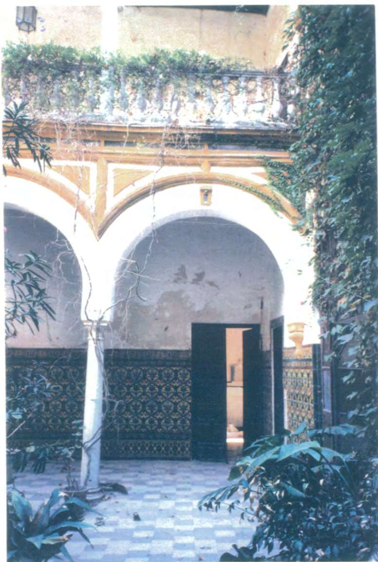
21. Vista de arcos de medio punto sobre columnas toscanas, balaustrada y zócalo de azulejo del S. XVIII de la galería este del patio principal.
