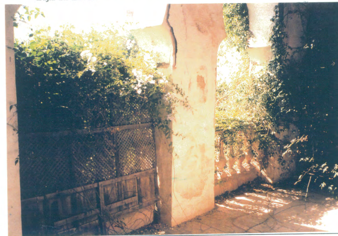
35. Galería de la planta alta del antepatio, formado por arcos de herradura y balaustrada de mampostería, copia de la del patio principal.
