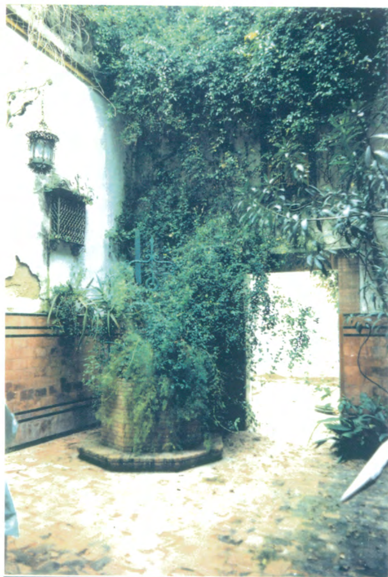
11. Vista del ángulo nordeste del patio pintoresquista, pozo de traza octogonal de mampostería de ladrillo visto y herrajes de hierro forjado.
