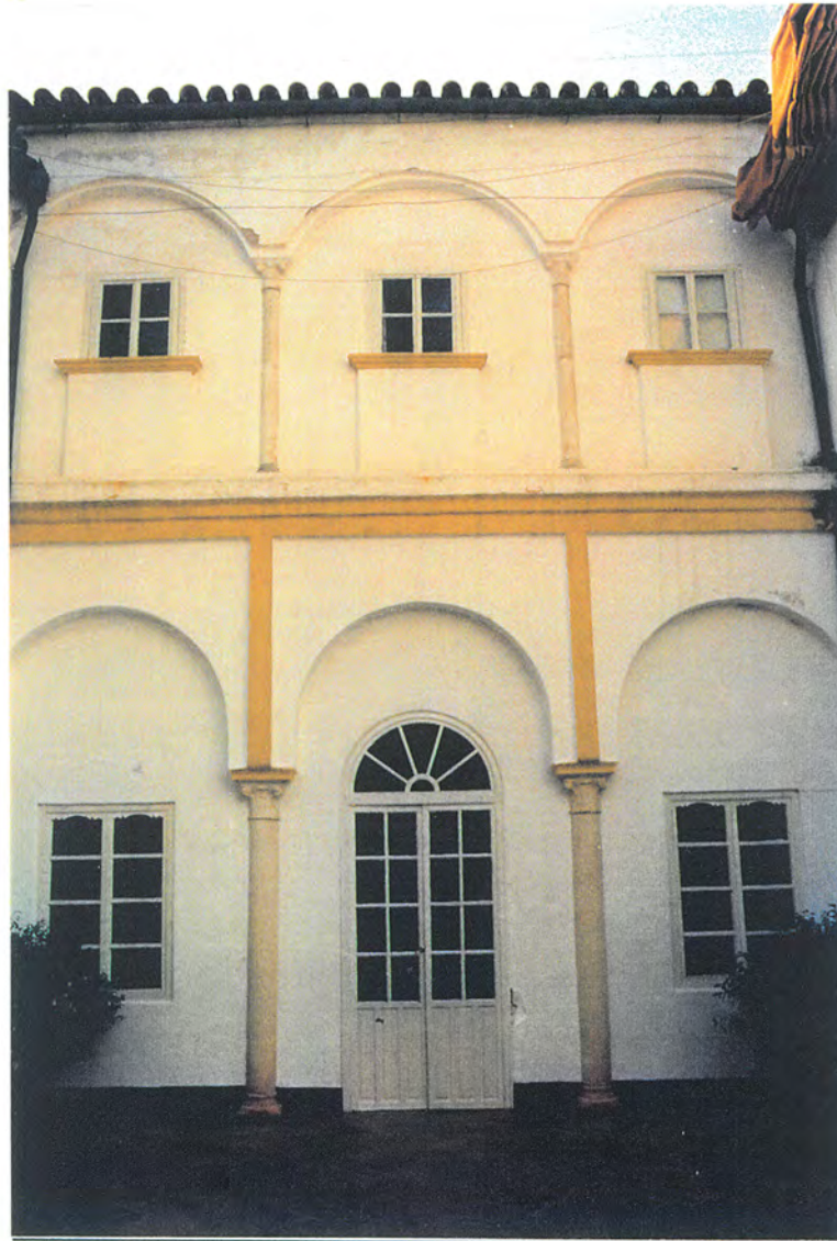
6. Fachada lateral derecha del patio, de doble galería cegadas con columnas adosadas de mármol de orden corintio, sobre las que se apoyan arcos peraltados por altices y rematado con cornisa continua en planta baja, y por arcos de medio punto con molduras muy simples en planta alta.
