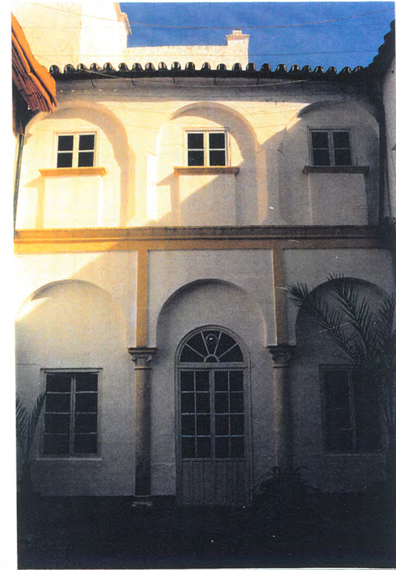
7. Fachada lateral izquierda del patio.
