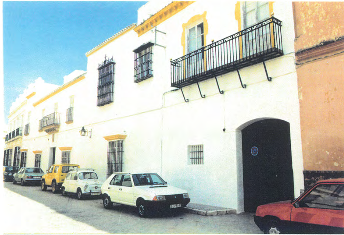
1. Fachada principal del X. XVIII, de dos plantas, herrajes del S. XVIII. Es de destacar el cierro existente en la planta alta, de hierro profundo con guardapolvo de chapa rematado con una cruz, y el blacón corrido procedente del Palacio Ducal.
