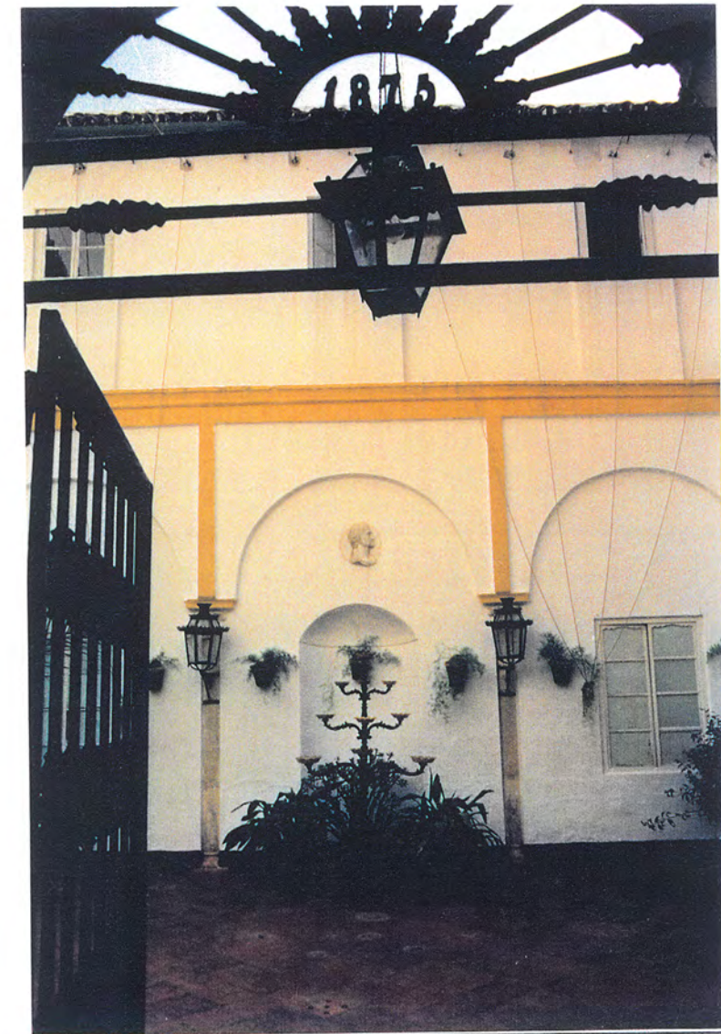
5. Vista de la fachada frontal del patio, desde la cancela.
