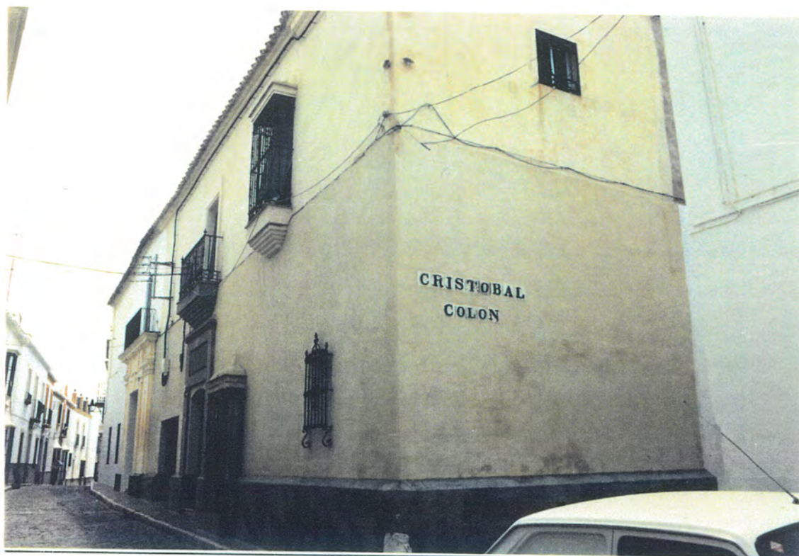
1. Vista general de la fachada a C/ Padre Marchena.
