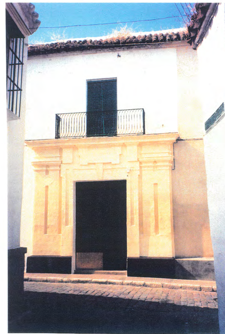
4. Detalle de la portada de la parte del edificio que menos transformación ha sufrido, esta portada es adintelada con puerta de duelas de madera y zócalo de chapa de metal, cartela en la clave del dintel, flanqueada por pilastras pareadas de orden toscano con entablamento y rematada por una cornisa sobre la que se apoya un balcón, sin decoración.
