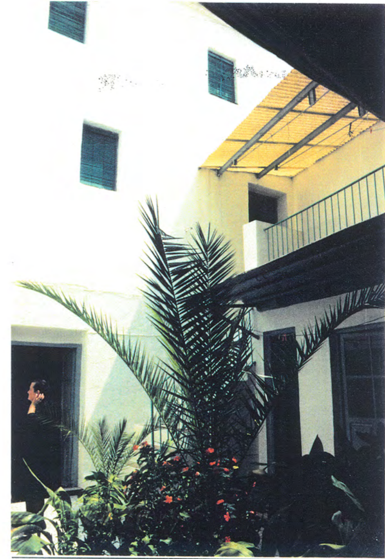
8. Patio de labor, en el que se observa la nave situada en crujía de fachada para almacenamiento que conserva elementos constructivos originales.
