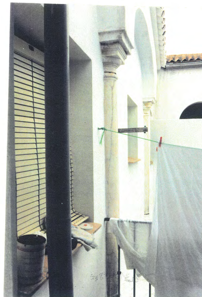
6. Fachada del patio, arcos de medio punto sobre columnas toscanas de mármol.
