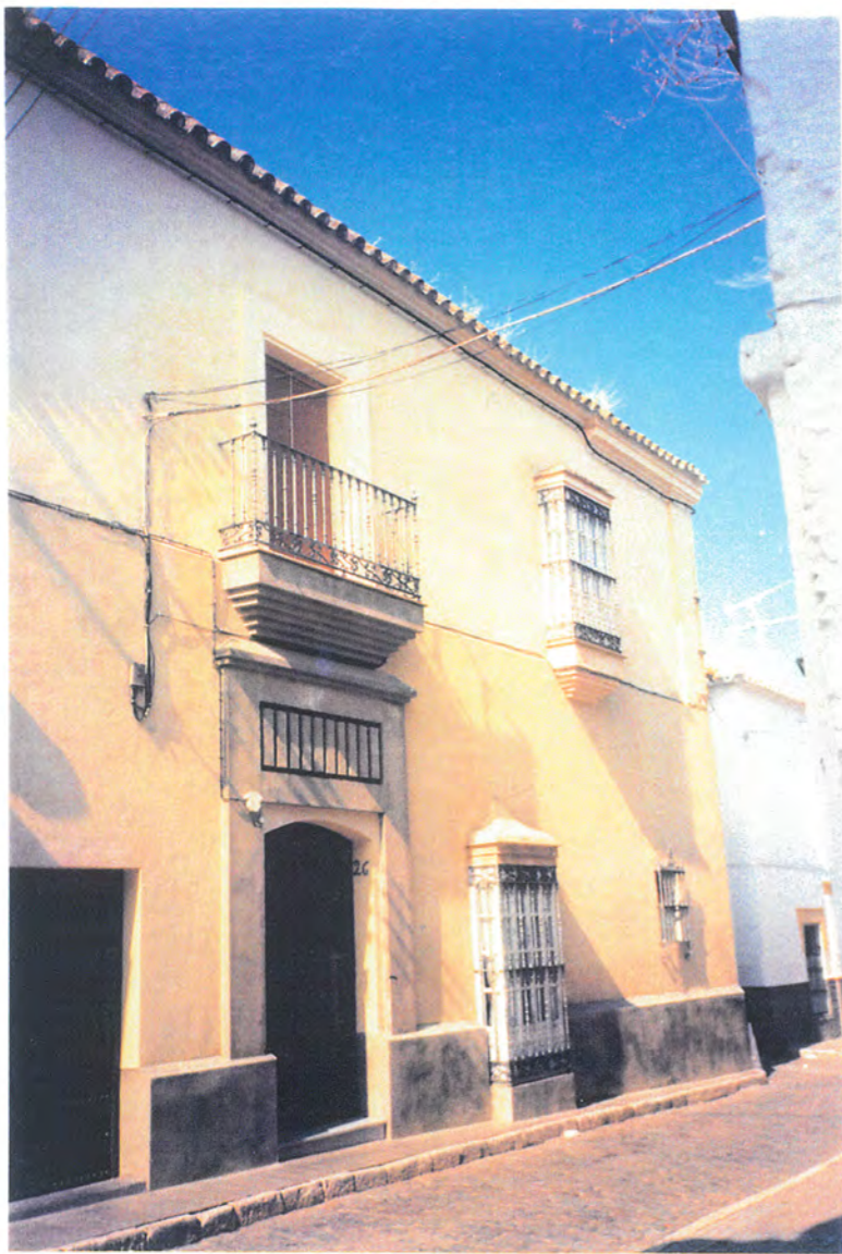
3. Vista de la parte del edificio que ha sufrido más transformaciones. La portada como el resto del edificio está enfoscada y pintada y no tiene ningún interés.
