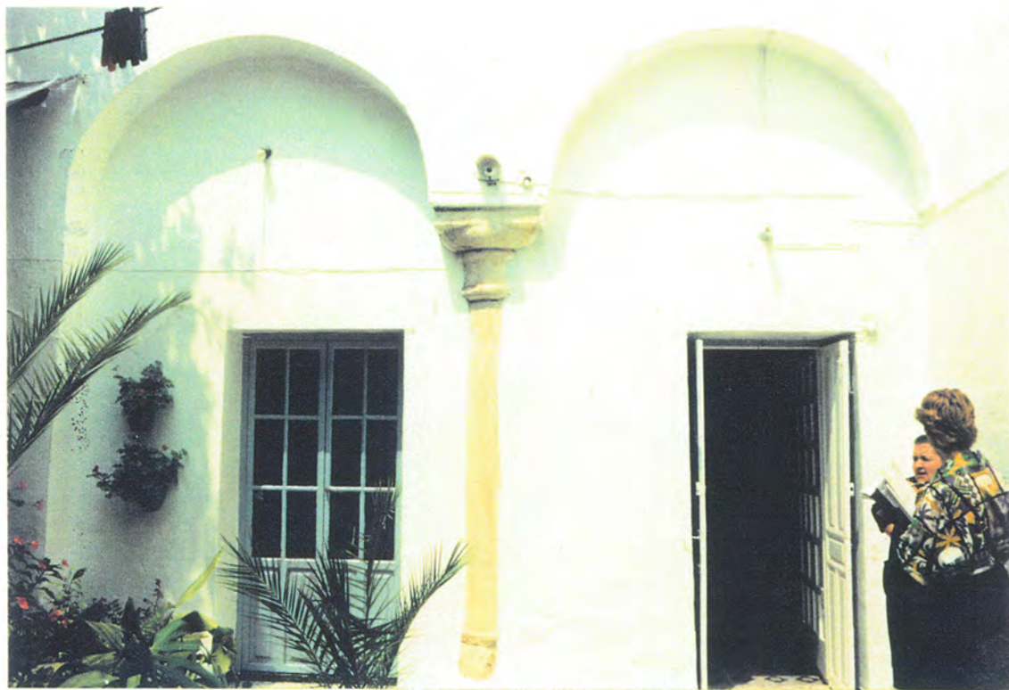
9. Acceso al patio de labor, a través de dos arcos de medio punto que descansan sobre columnas de granito.
