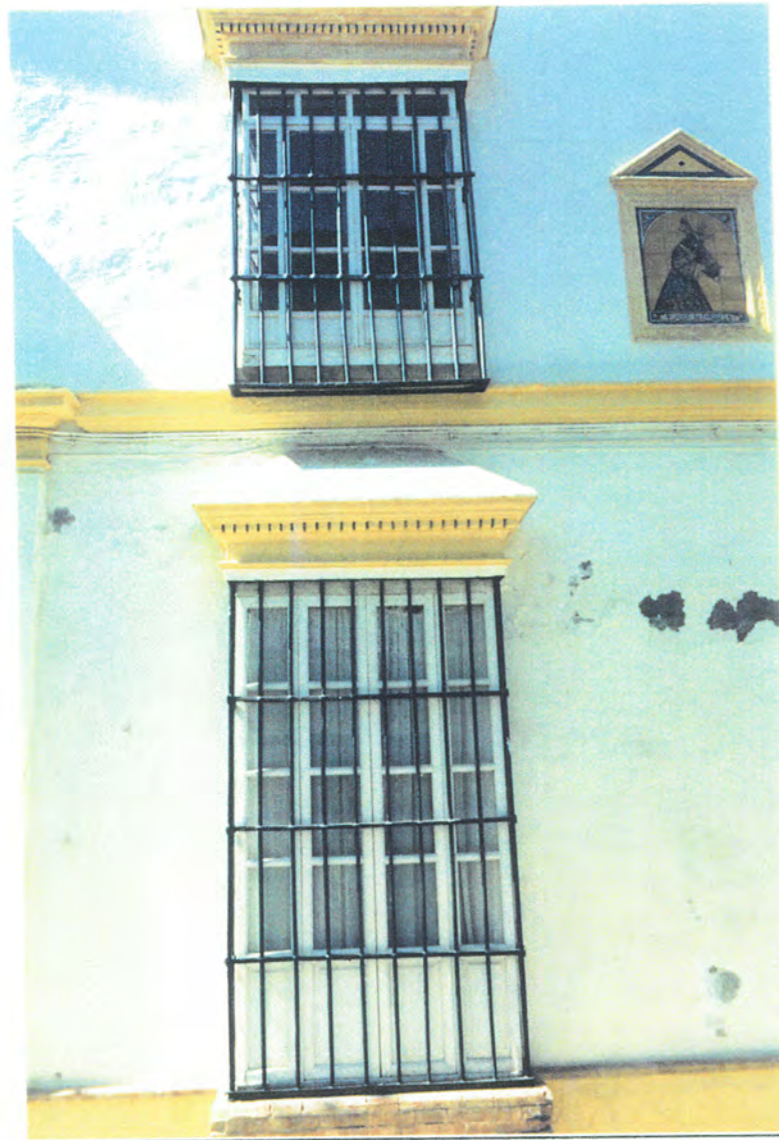
5. Detalle de cornisa y cierros. En planta baja se apoyan sobre fábrica vista de ladrillo, siendo volados en planta alta. La cerrajería es de forja del S. XVIII y la carpintería de madera. Los azulejos de cerámica representando a Jesús Nazareno parecen de la época.
