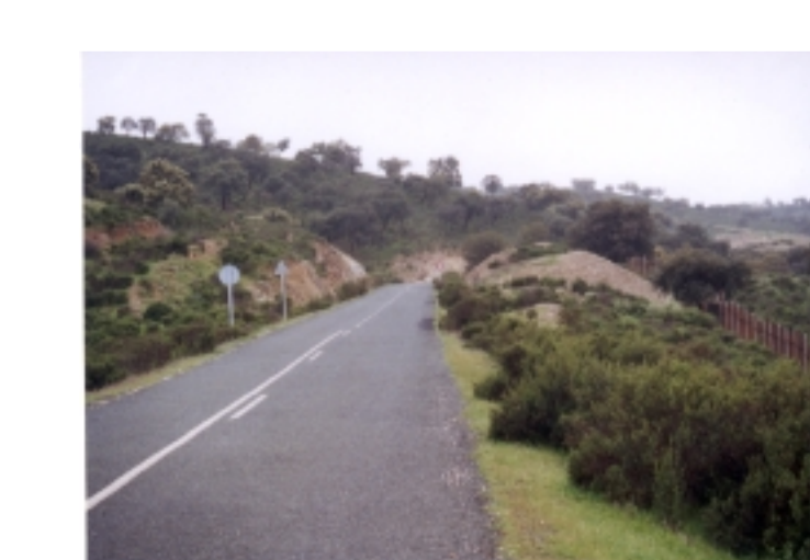
Las escombreras resultantes de las obras en la carretera alteran la morfología natural.
